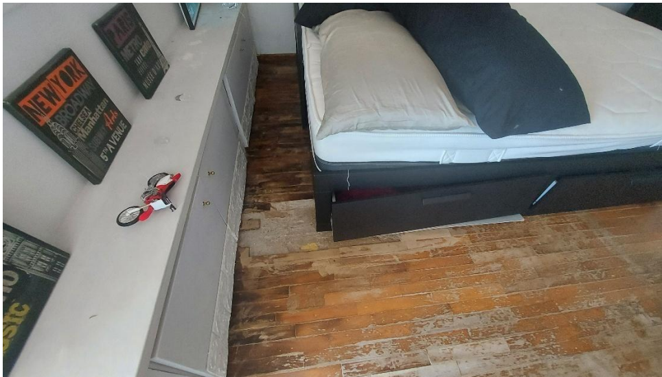
Particolare - danni infiltrazioni pavimentazione camera L3
