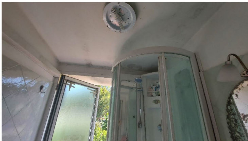
Tracce infiltrazioni soffitto bagno wc 2
