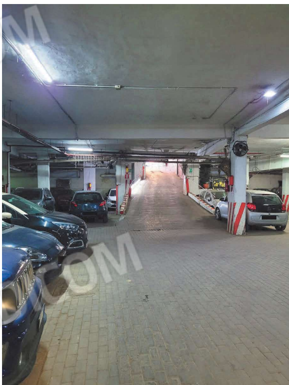
Vista generale locale garage
