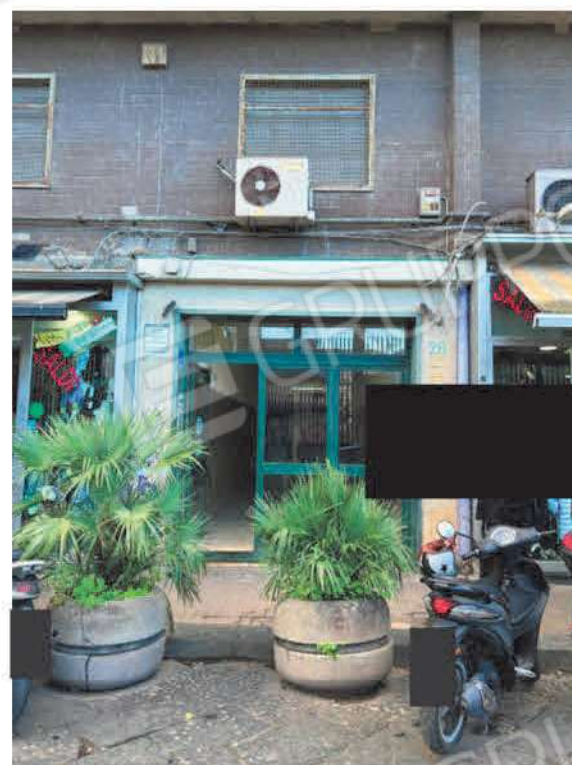
Vista portone di accesso allo stabile
