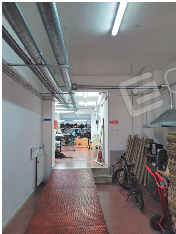
Vista rampa di ingresso al locale laboratorio
