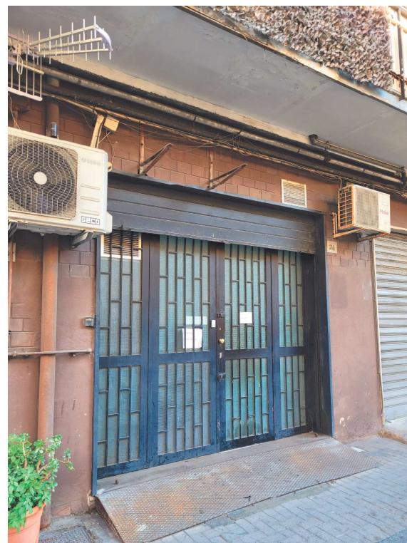
Vista cancello di accesso all'immobile
