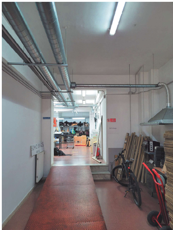
Vista rampa di ingresso al locale laboratorio
