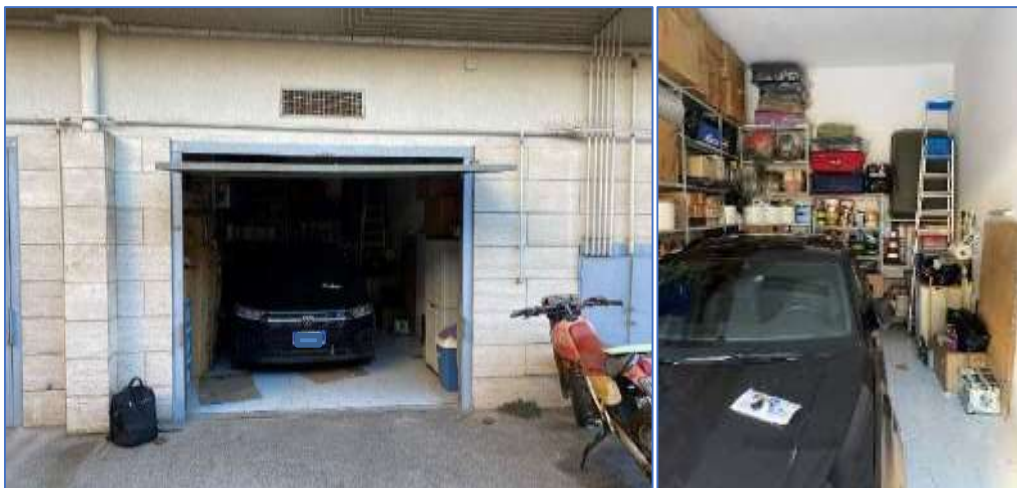
Figura 68. Rilievo fotografico (estratto dell'allegato C-7).
