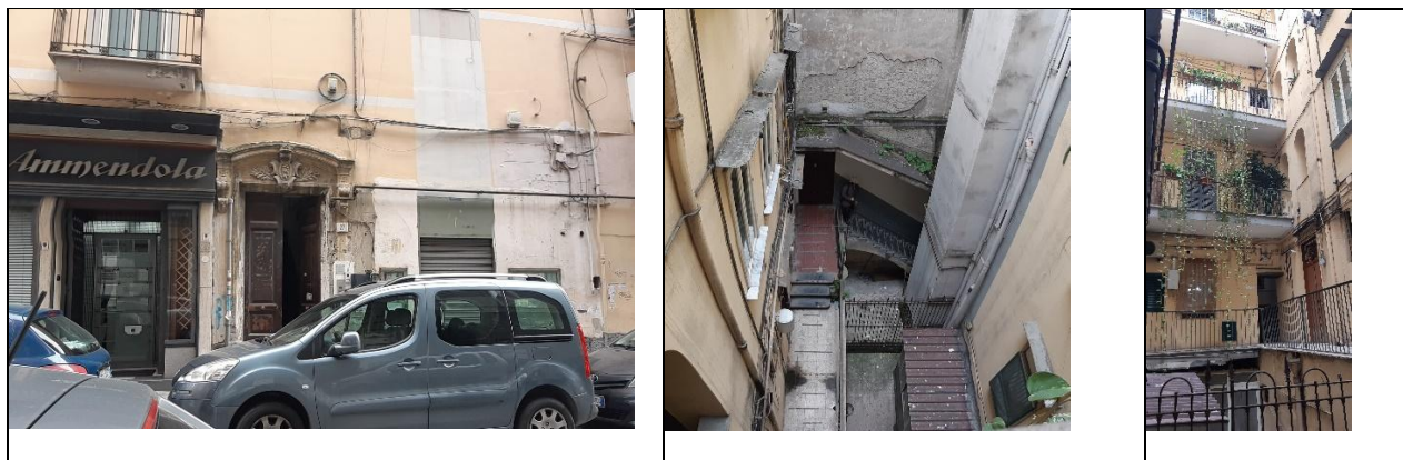
Foto n.2 (portone al c.27) -4-6 (corte interna)
