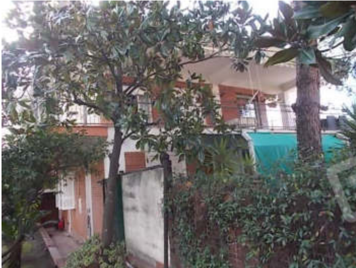
fabbricato e alloggio pignorato visti dal cortile comune
