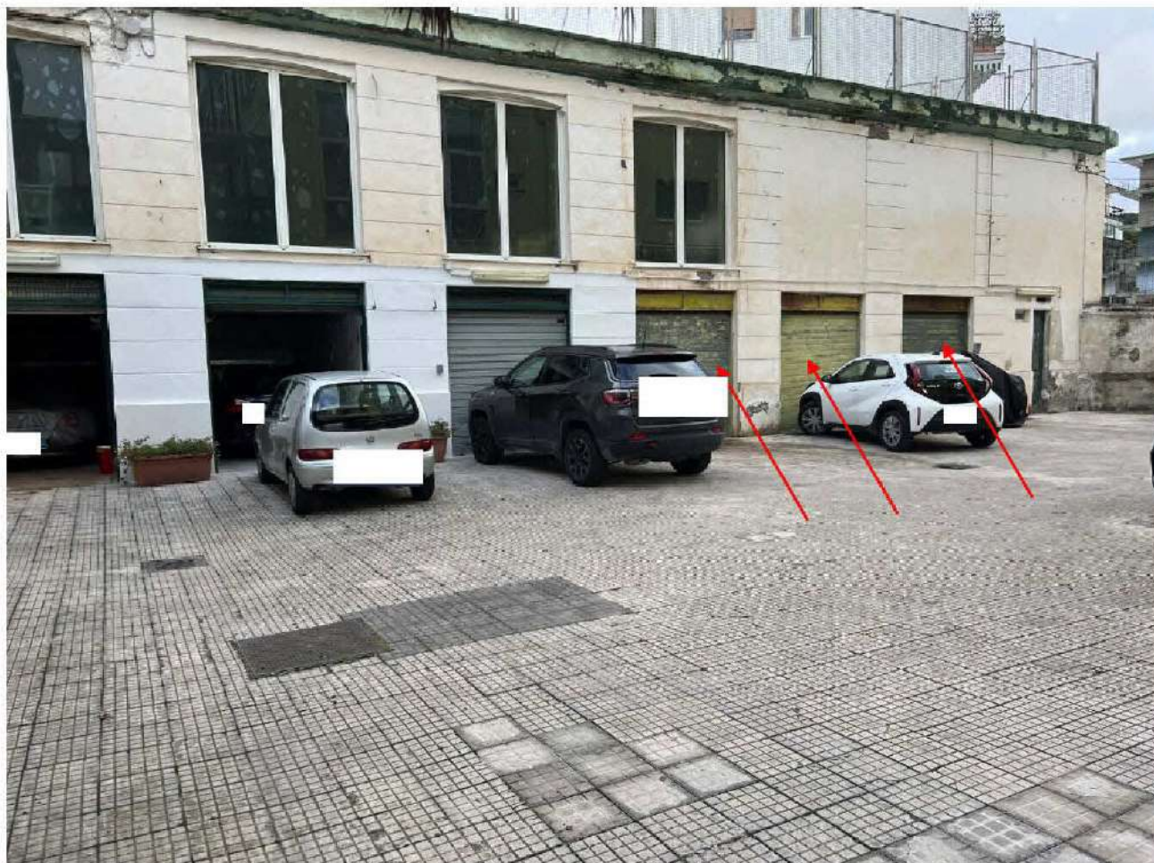
Foto 5 – Vista delle tre saracinesche di accesso al locale staggito NN. 7,8,9
