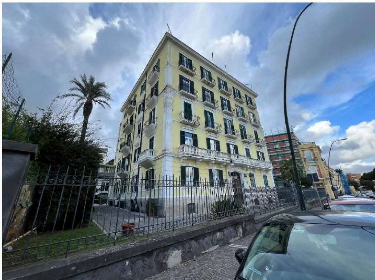
Foto 1 - Vista del fabbricato di via Santo Strato n. 25, Napoli – villa Florida
