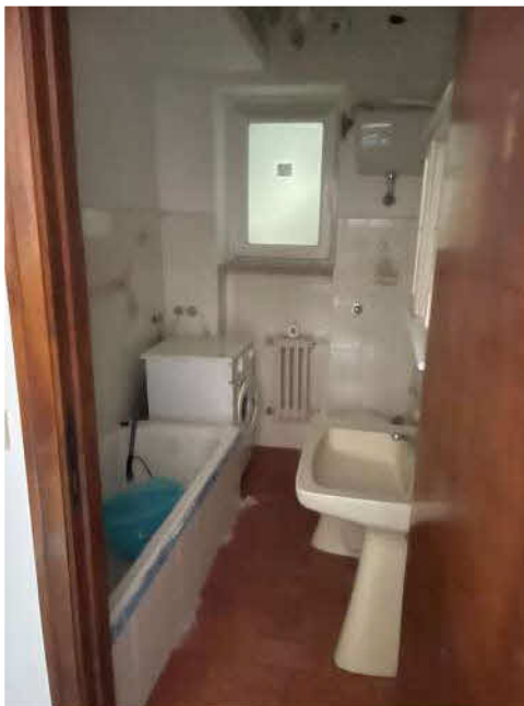
Foto n. 11: • Bagno “zona notte” attrezzato con vasca.
