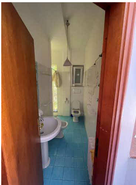
Foto n. 15: • Bagno adiacente alla cucina attrezzato con doccia.
