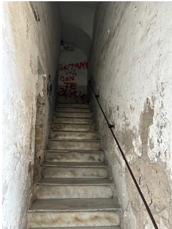
Scala condominiale di accesso ai piani
