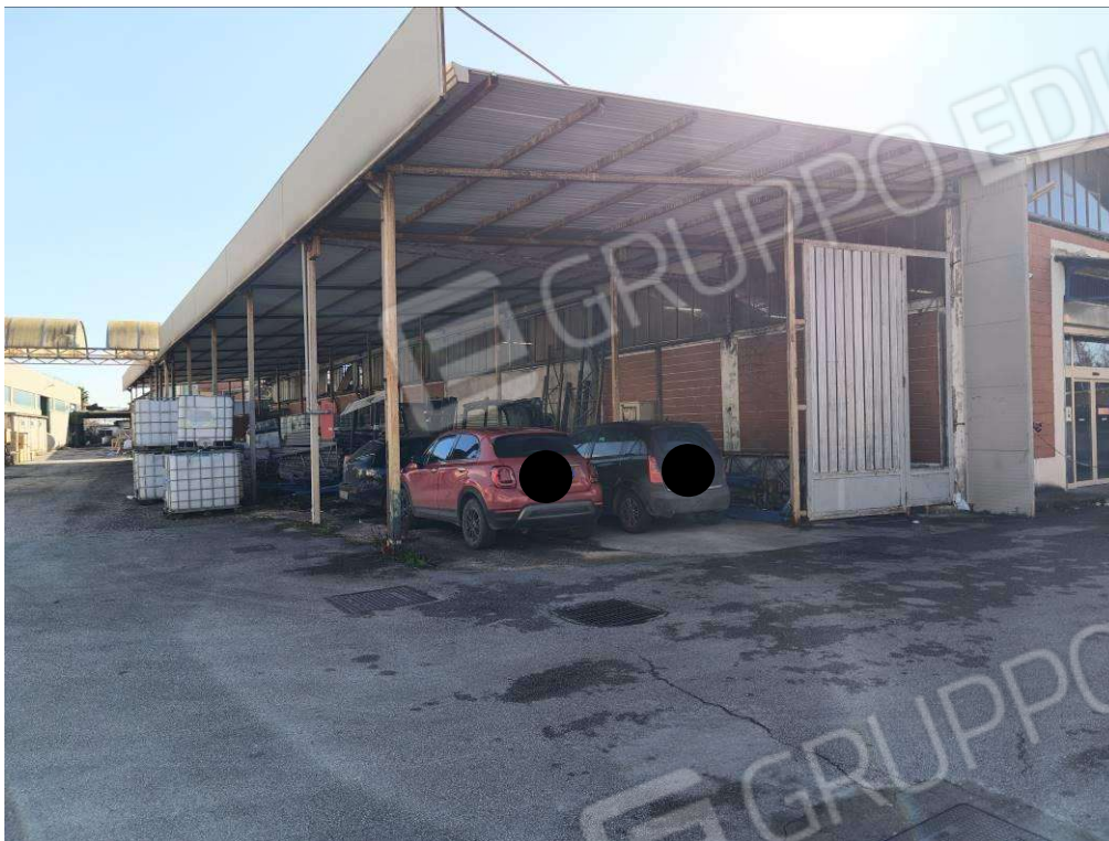
Foto 3 Sub. 6 Edif B1
