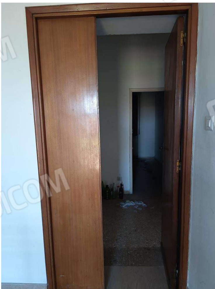
Foto 6 Sub. 5 piano primo
