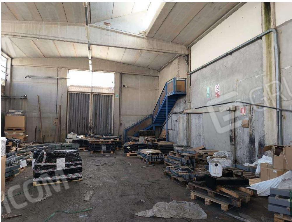
Foto 14 Sub. 6 P.T. Edif B2
