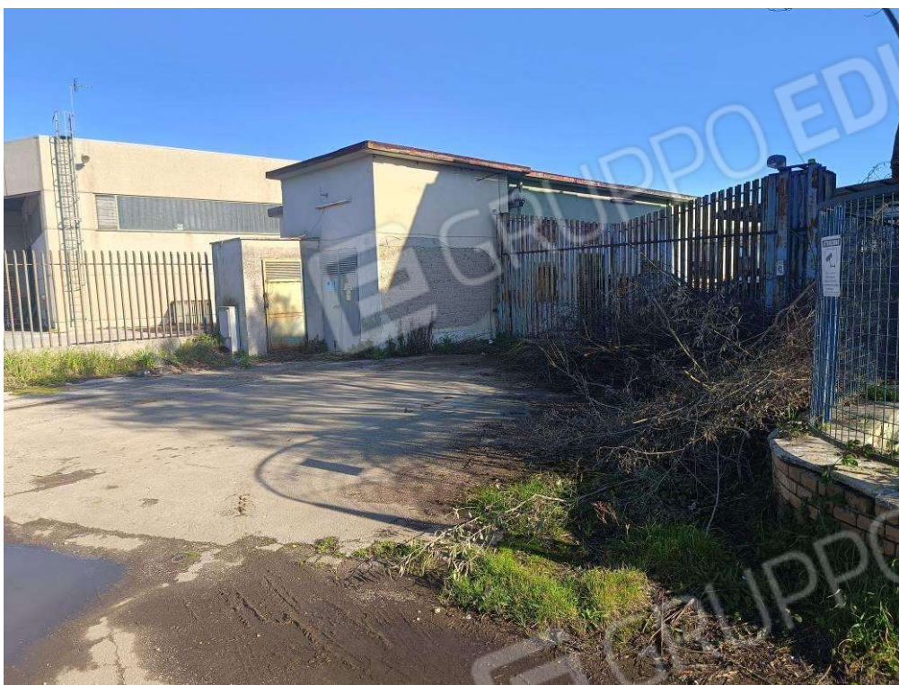
Foro 29 Sub. 6 Edif D2
