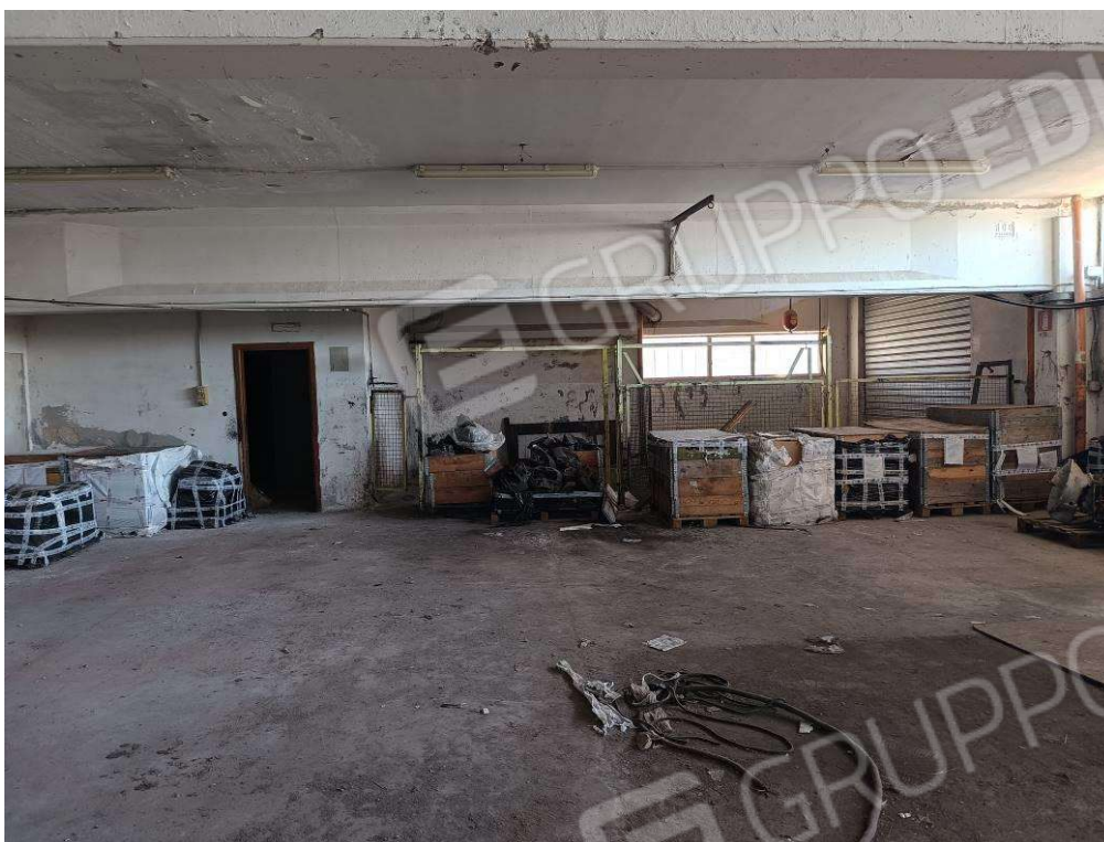
Foto 9 Sub. 6 P.T. Edif B2
