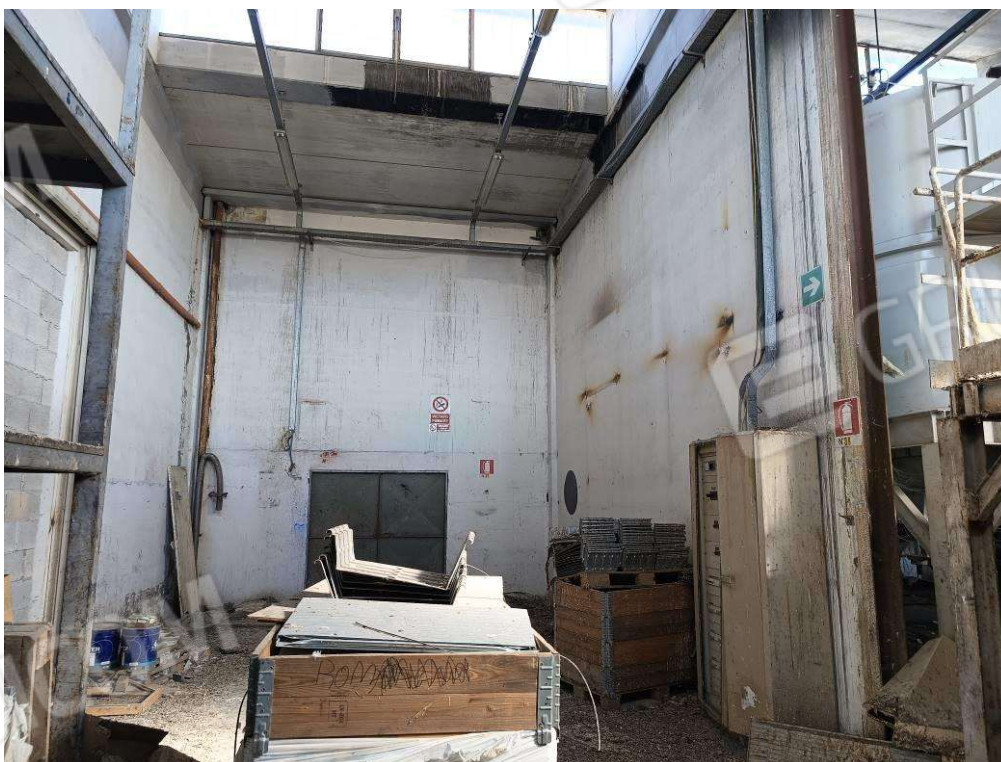
Foto 6 P.T. Sub. 6 Edif B2
