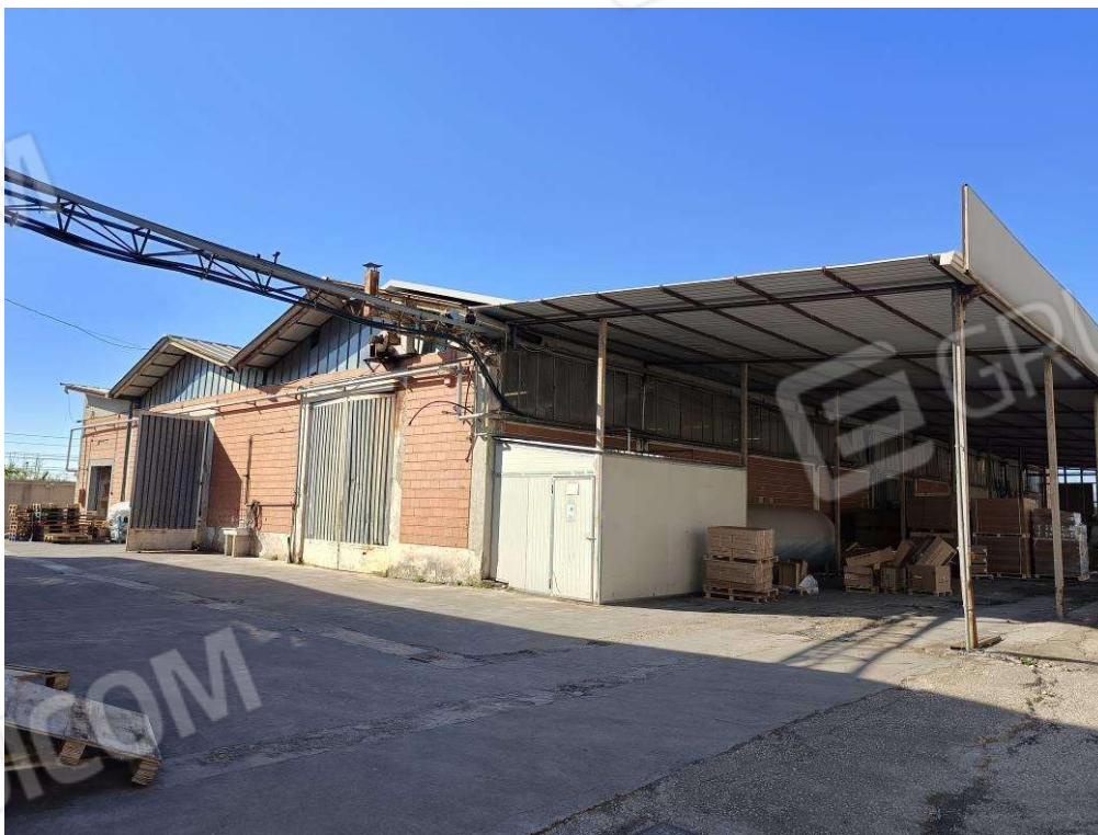
Foto 2 Sub. 6 Edif B1
