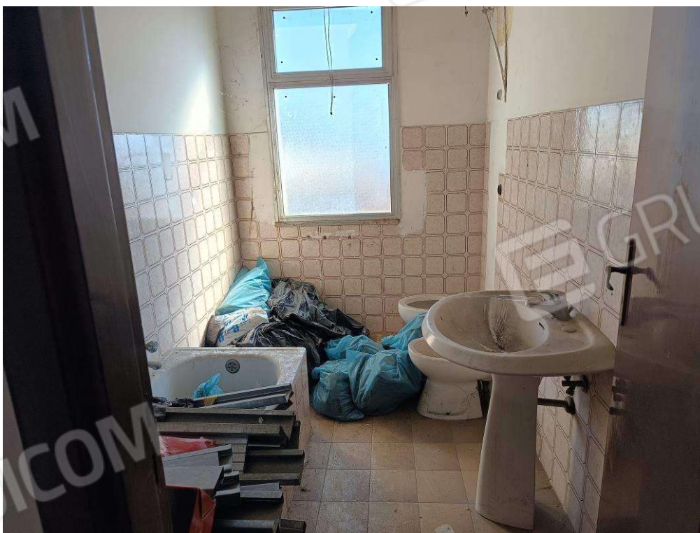
Foto 18 Sub. 6 P.1° Edif B2
