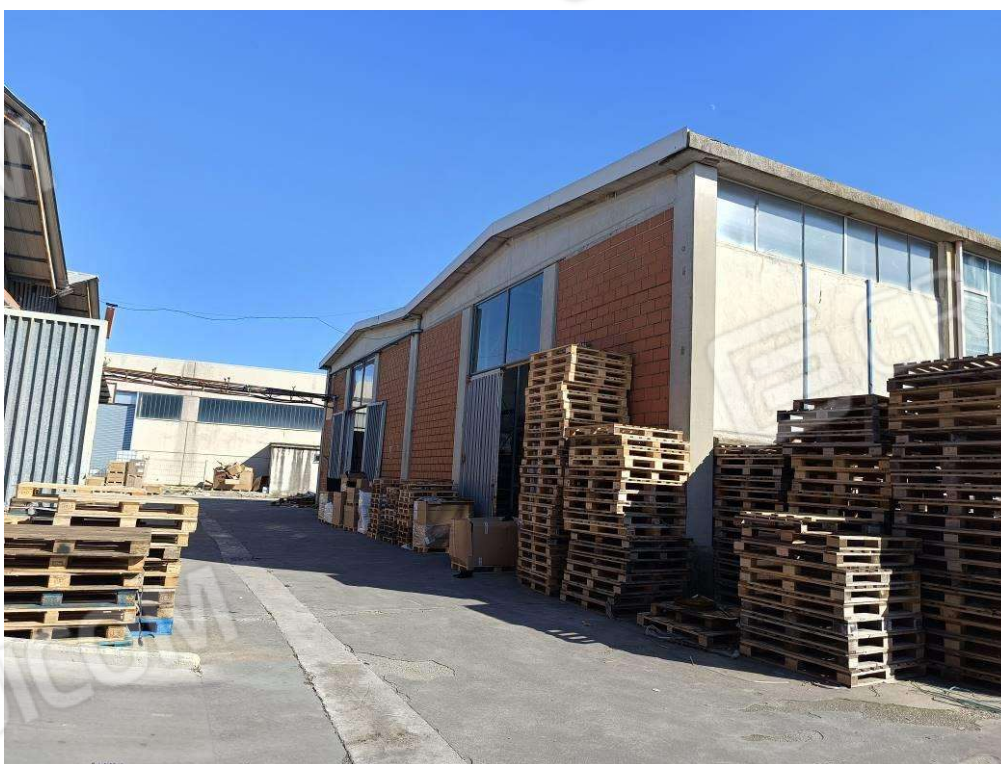
Foto 2 Sub. 6 Edif B2
