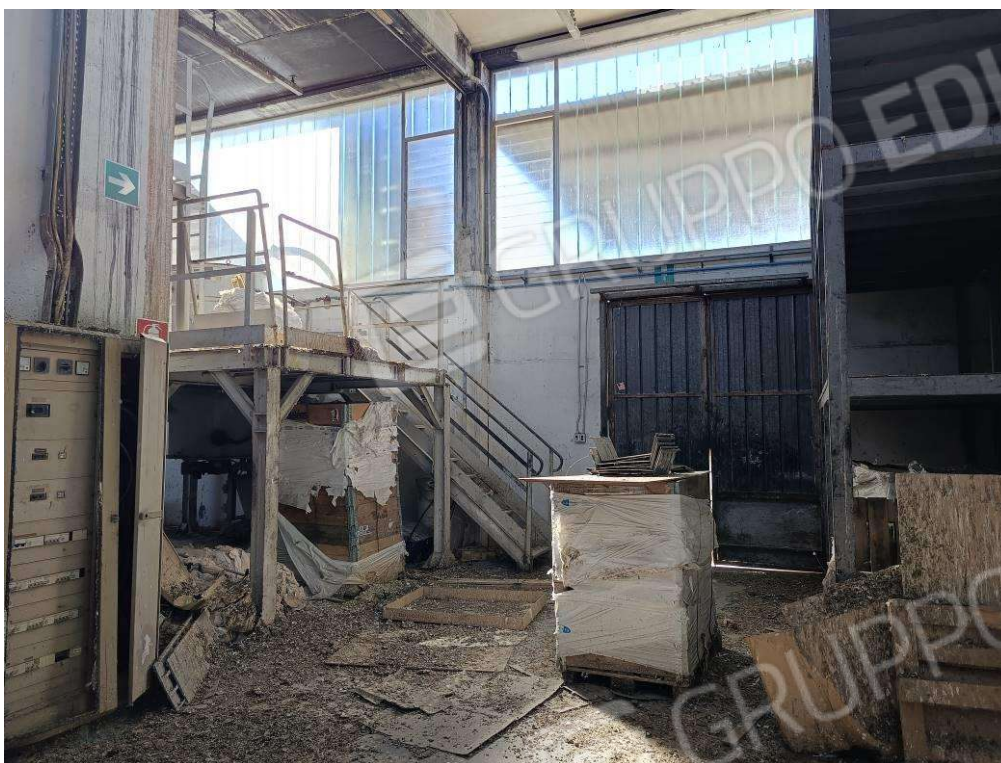
Foto 7 P.T. Sub. 6 Edif B2
