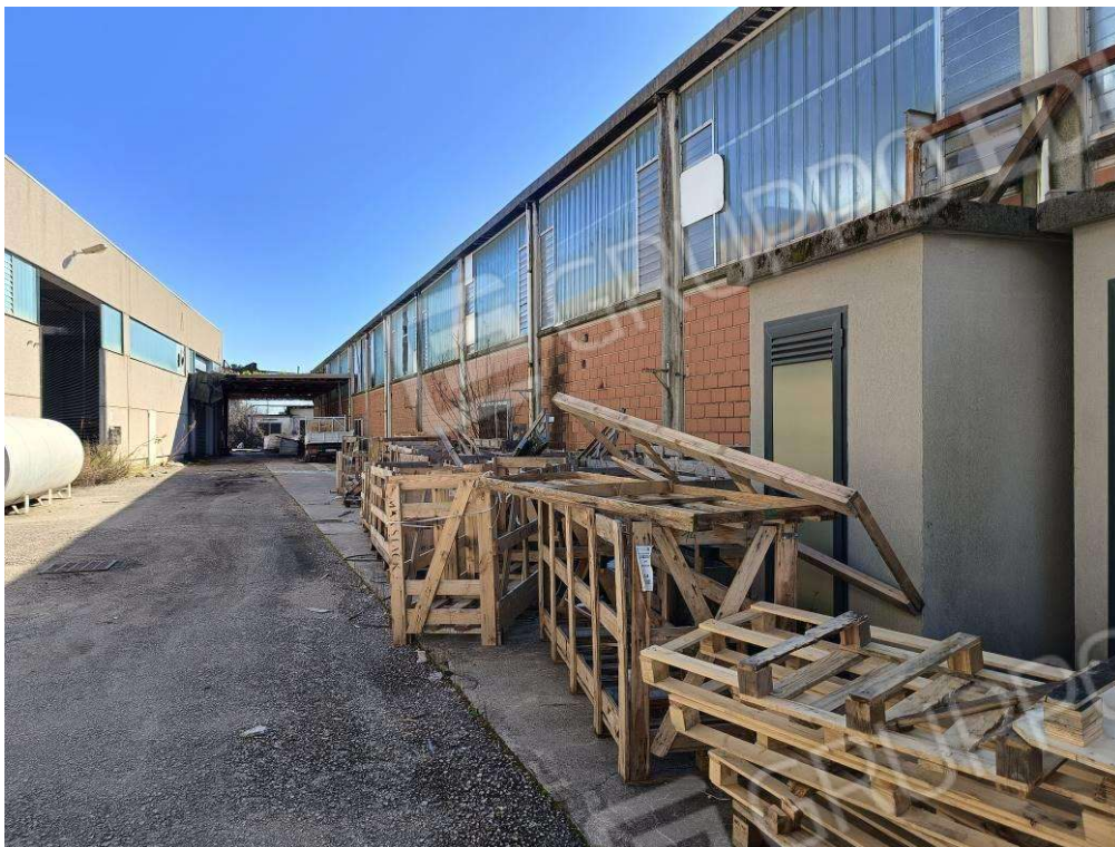
Foto 3 Sub. 6 Edif B2
