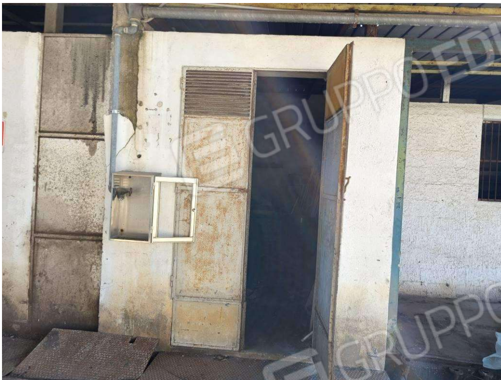
Foro 25 Sub. 6 Edif D1
