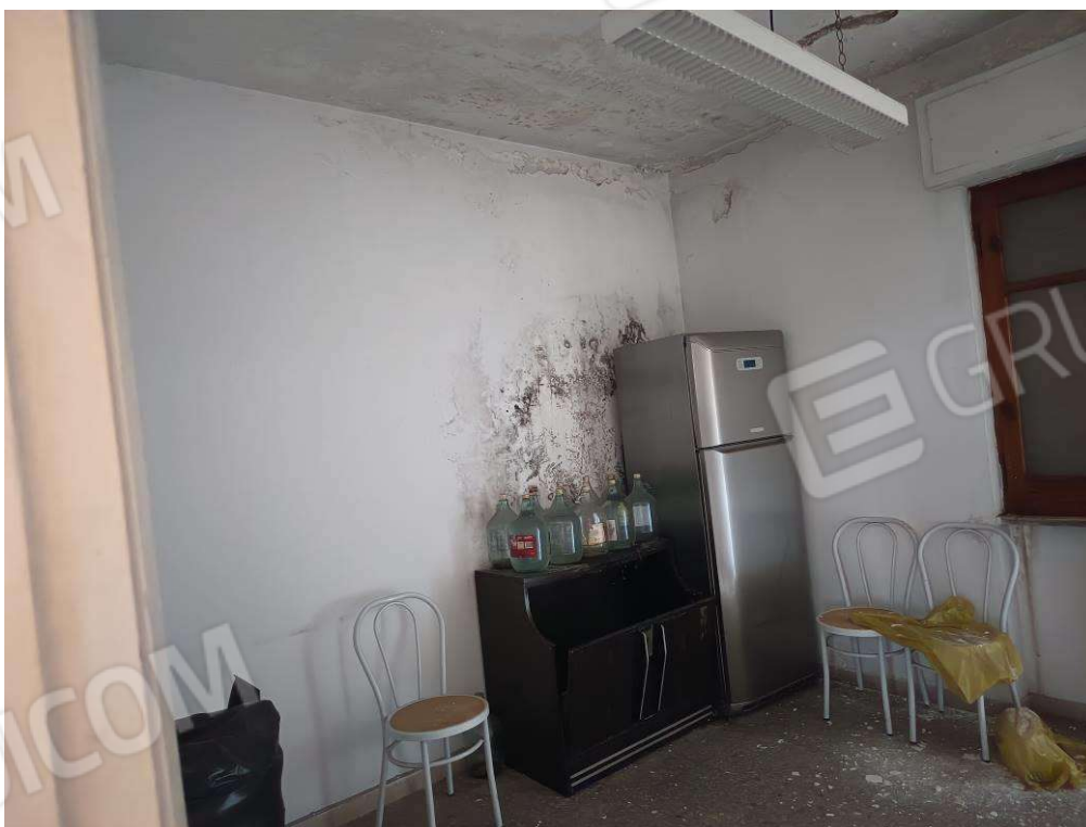
Foto 8 Sub. 5 piano primo
