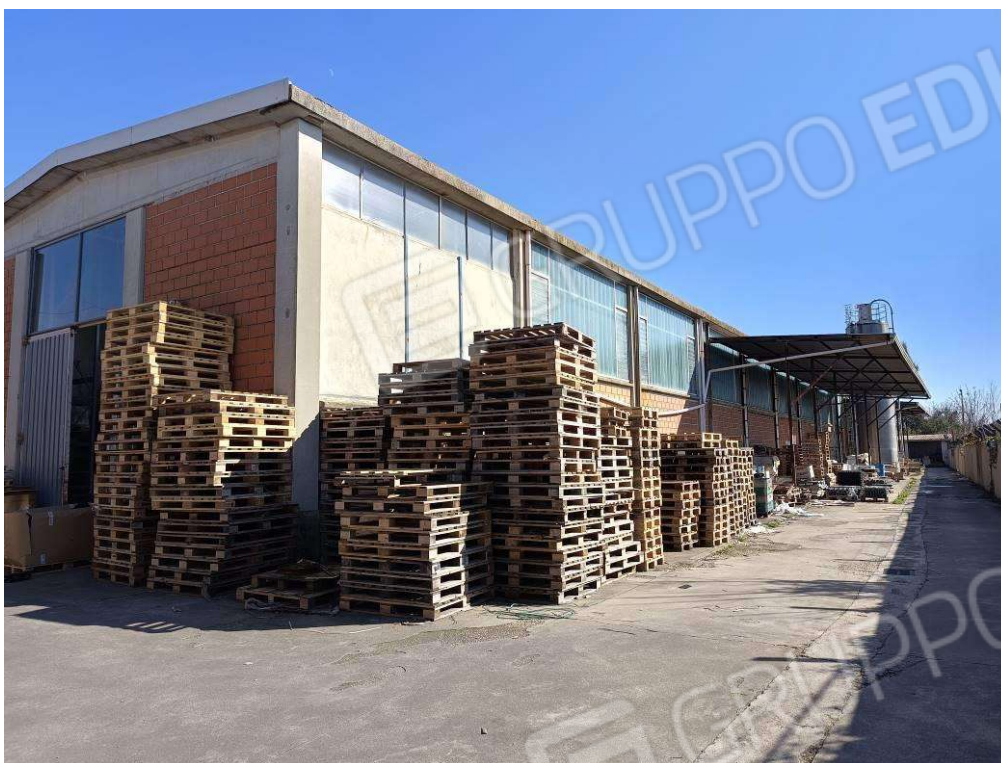
Foto 1 Sub. 6 Edif B2
