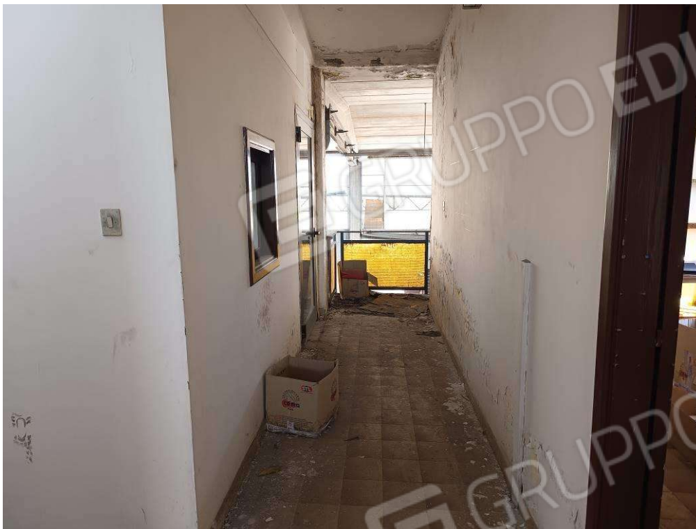
Foto 15 Sub. 6 P.1° Edif B2
