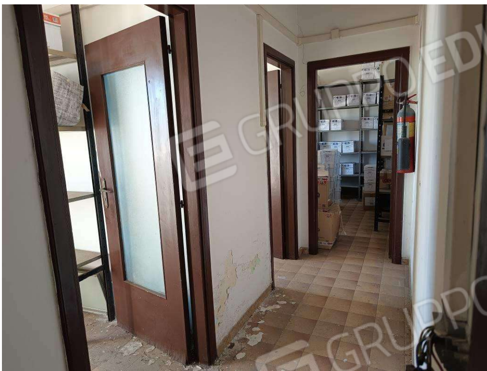
Foto 21 Sub. 6 P.1° Edif B2
