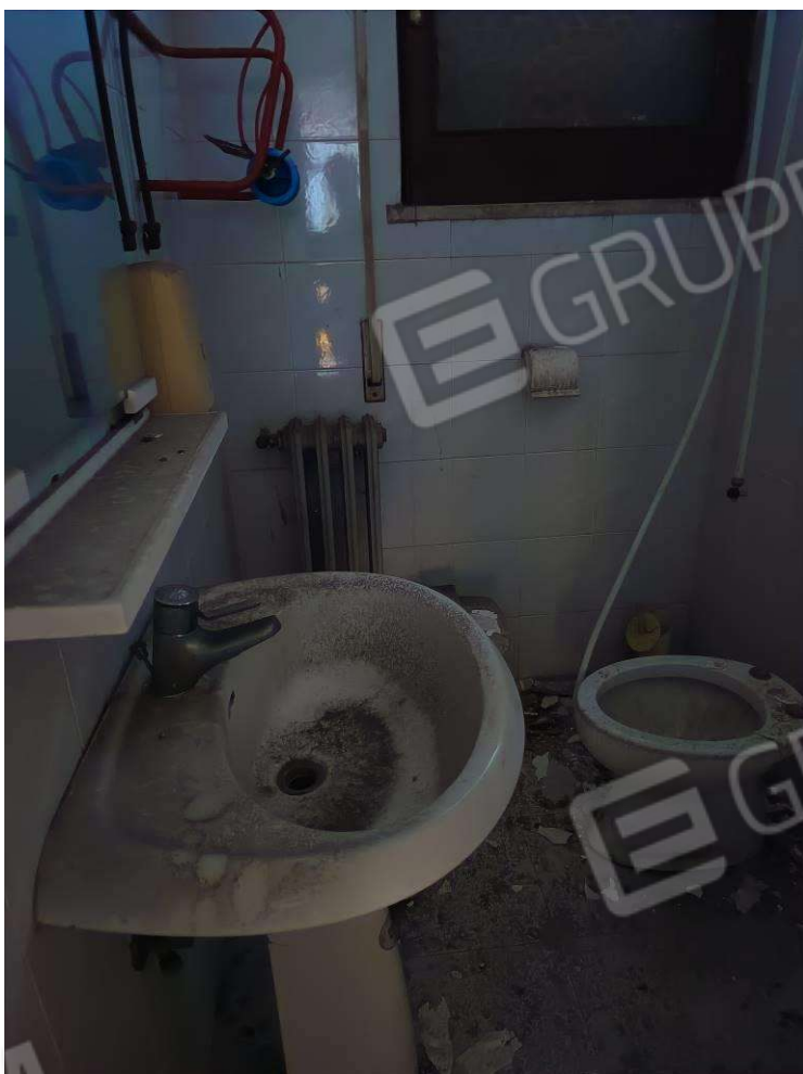
Foto 3 Sub. 5 piano terra
