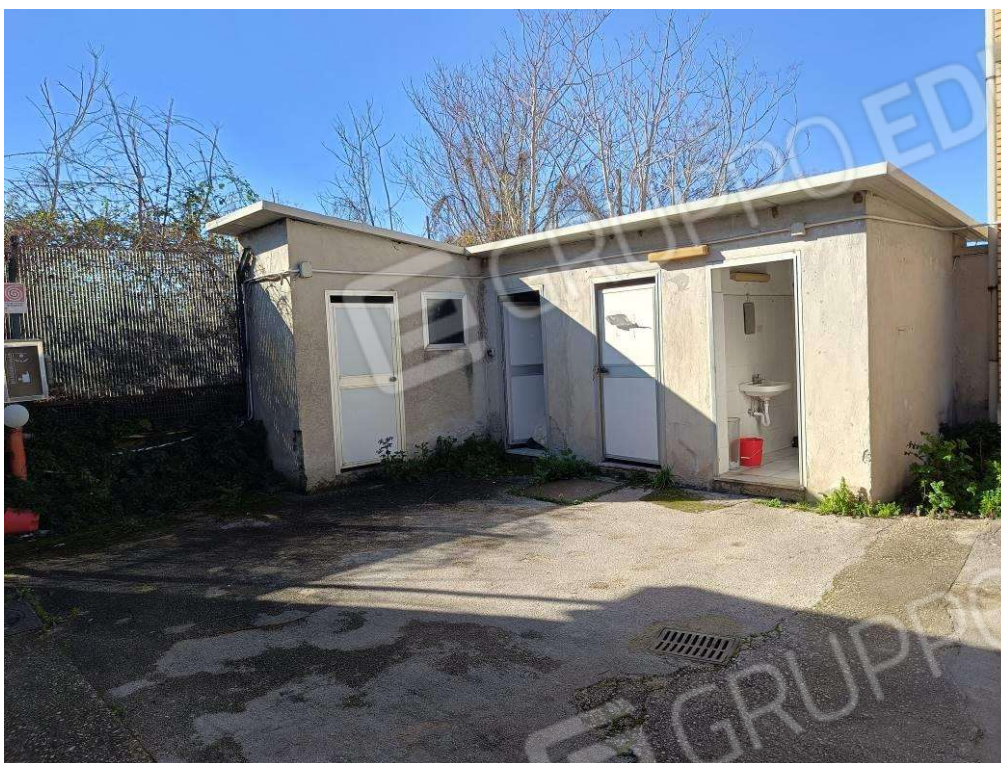
Foro 23 Sub. 6 Edif C
