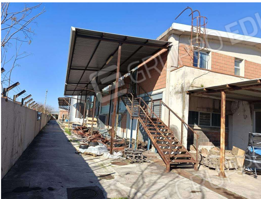
Foto 5 Sub. 6 Edif B2
