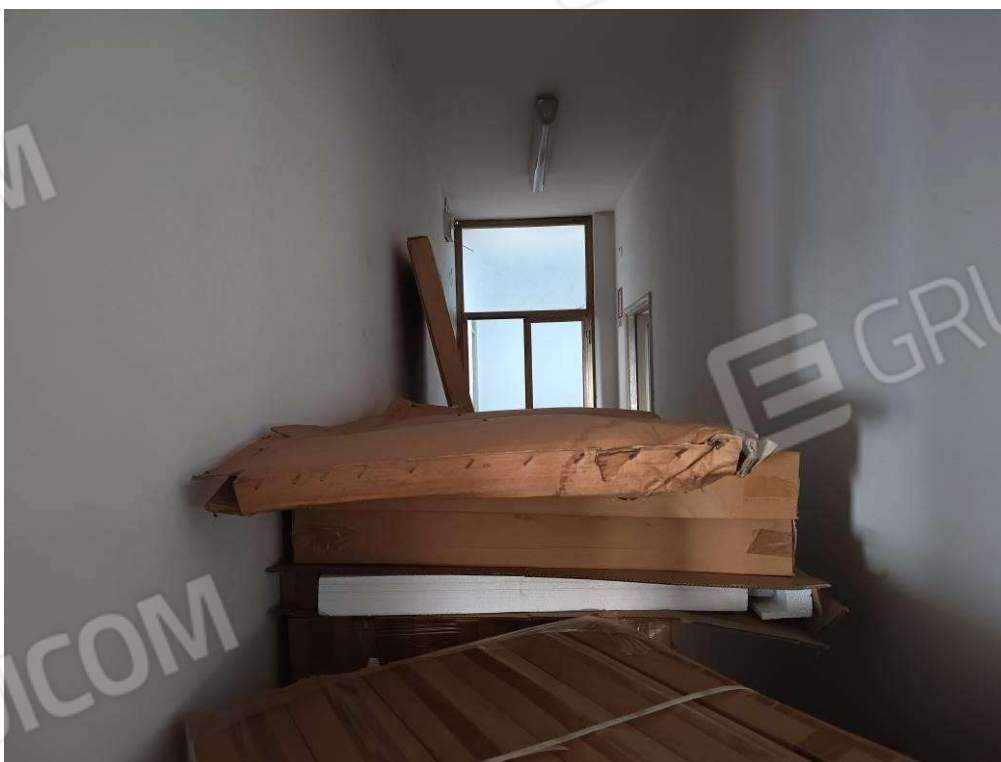
Foto 2 Sub. 5 piano terra
