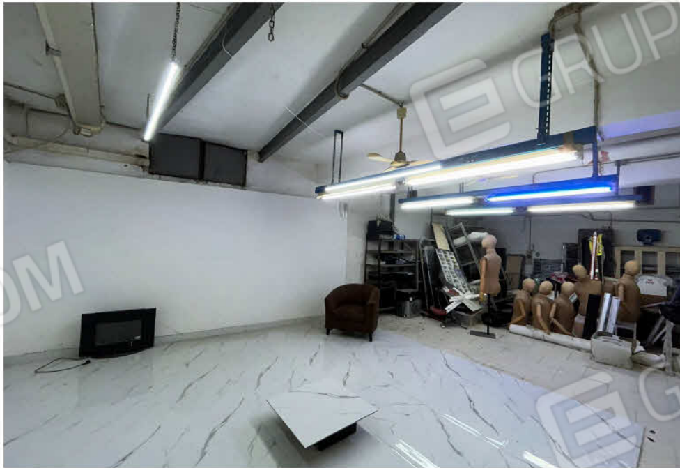
FOTO 12 Locale deposito al PS1 - SUB 101: ambiente principale
