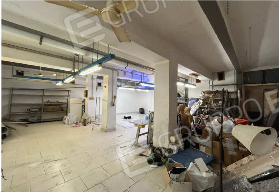
FOTO 9 Locale deposito al PS1 - SUB 101: ambiente principale
