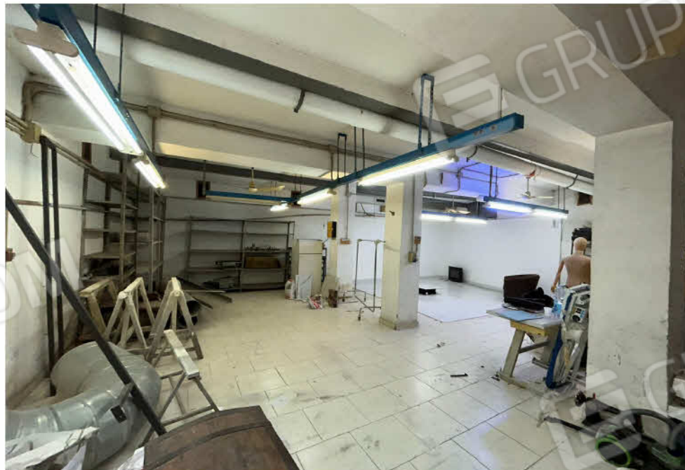
FOTO 10 Locale deposito al PS1 - SUB 101: ambiente principale
