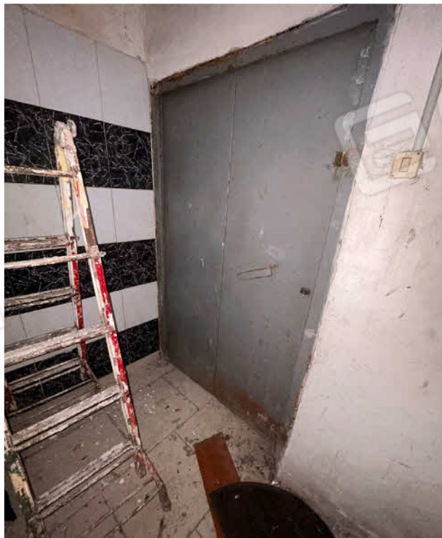
FOTO 6 Porta d'accesso all'u.i. pignorata al PS1 - SUB 101
