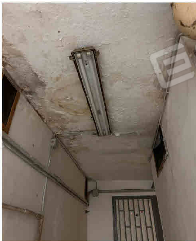
FOTO 18 Locale deposito al PSI - SUB 101: particolare dei fenomeni infiltrativi a soffitto
