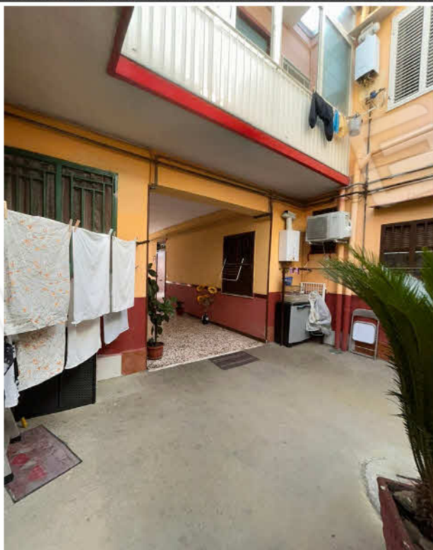
FOTO 4 Corte interna del fabbricato
