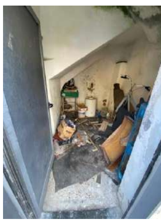
Foto n. 6: Interno del piccolo locale deposito al piano strada
