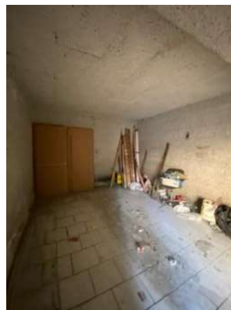
Foto n. 18: Interno del box garage interrato(sub 60)
