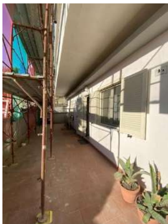
Foto n. 22: Possibilità di accesso dal terrazzo di proprietà a ovest
