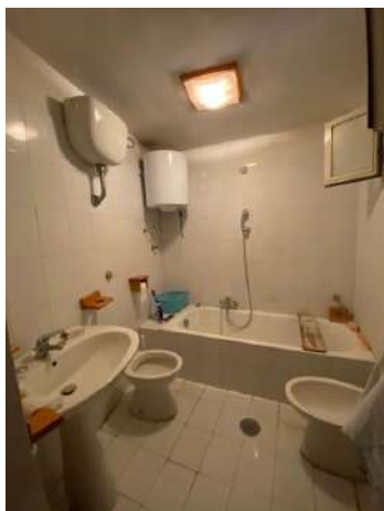
Foto n. 60: Bagno dell'app. n. 104 in II Carraia di Via Starzella
