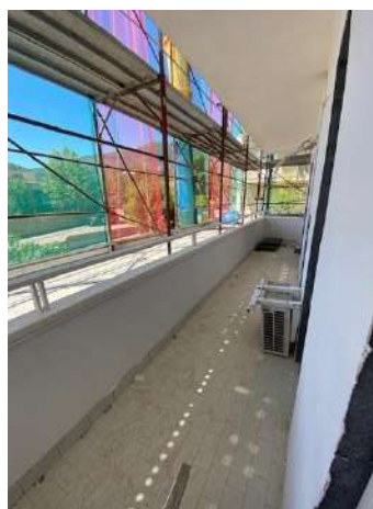
Foto n. 48: Balcone fronte ovest dell'appartamento sub 155 in I P.
