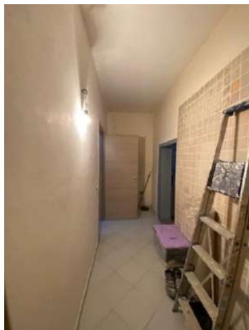
Foto n. 36: Accesso al locale cantina annesso all'appartamento sub 154
