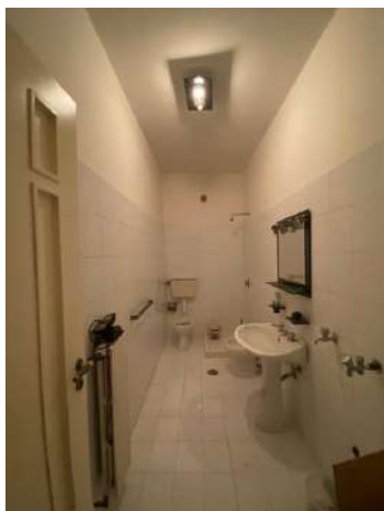
Foto n. 34: Bagno cieco dell'appartamento a P.T. (sub 154)
