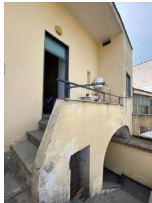
Foto n. 10: Ballatoio di accesso all'app.ento in II piano
