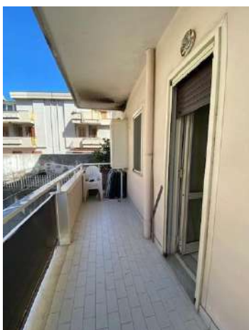
Foto n. 47: Balcone fronte nord dell'appartamento sub 155 in I P.
