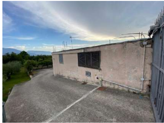
Foto n. 104: Foto dell'immobile pignorato scattata in sede di accesso ctu (17/05/2022)
