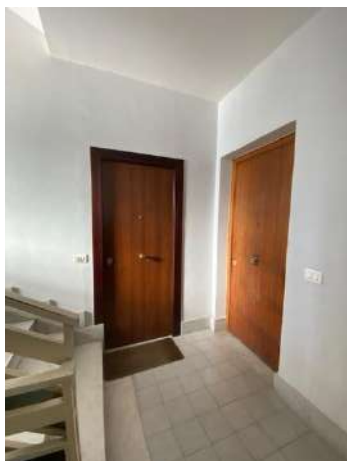
Foto n. 21: Duplice accesso al sub 154 sul pianerottolo a P.T.
