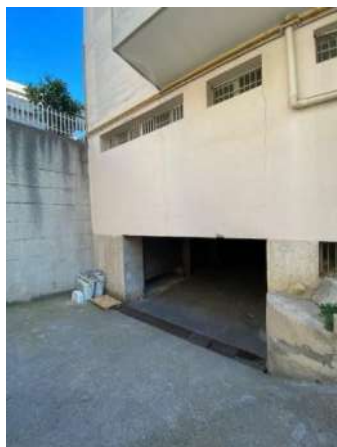
Foto n. 16: Accesso al piano garage del Cond. "Palazzo Oleandro"
