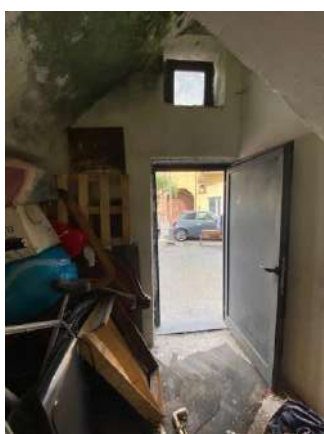
Foto n. 5: Interno del piccolo locale deposito a P.T. su corso Umberto I
