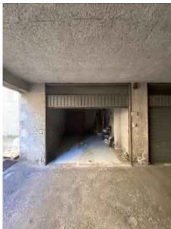
Foto n. 17: Accesso al box garage interrato (sub 60)
