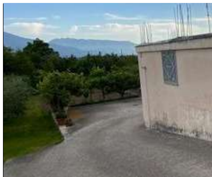
Foto n. 65: Rampa, aia di pertinenza e giardino piantumato di proprietà
