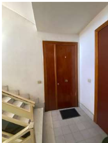
Foto n. 39: Porta di accesso all'appartamento sub 155 in I P.
