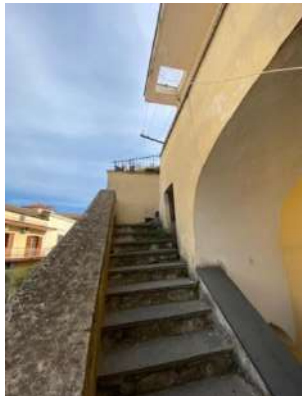
Foto n. 8: Scala esterna comune che porta all'app.ento in II P.
