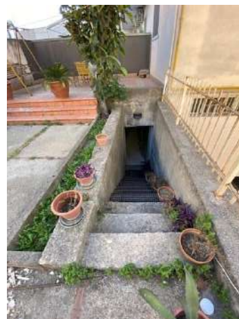
Foto n. 23: Accesso all'area esterna sopraelevata di pertinenza a est
