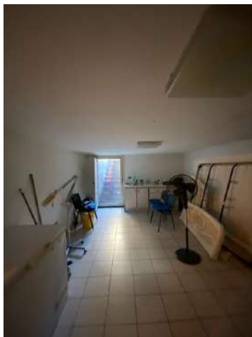
Foto n. 37: Locale cantina annesso all'appartamento sub 154
