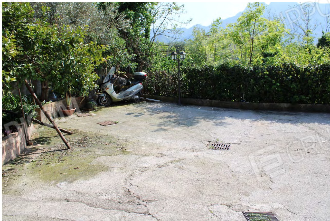
FOTO N° 06: Lotto unico – Corte
