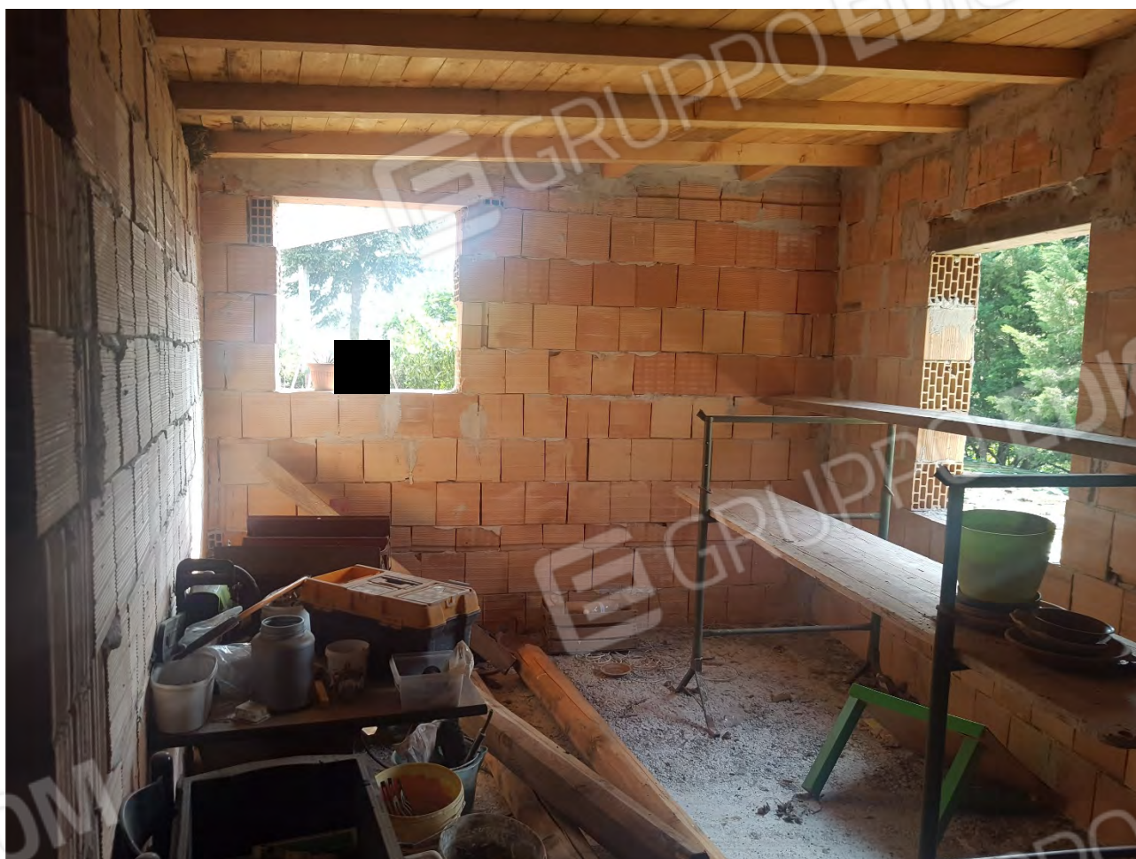
FOTO N° 19: Lotto unico – deposito, Piano terra sub 3
