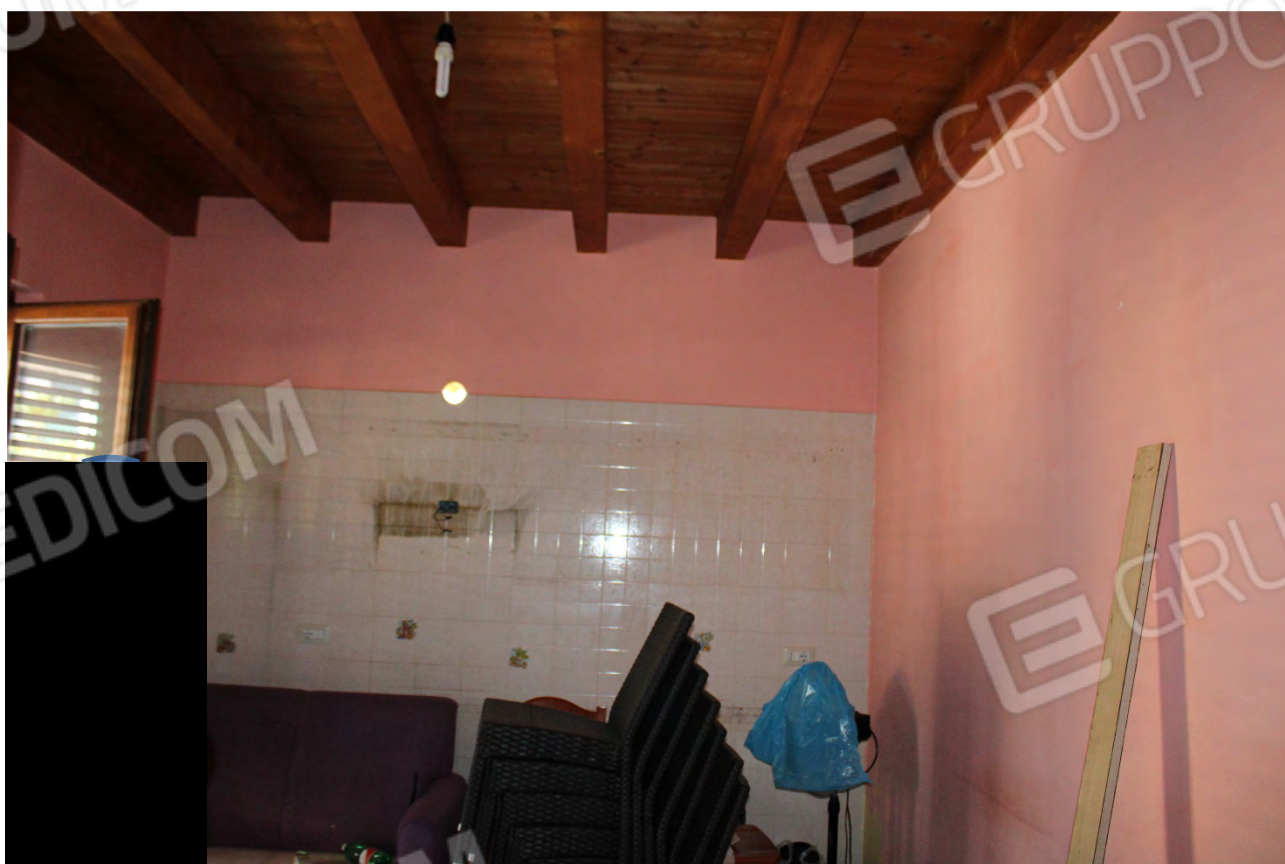
FOTO N° 28: Lotto unico – Piano primo, sub 6
