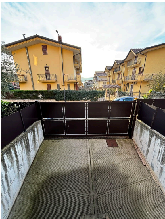
Vista rampa di accesso al garage
