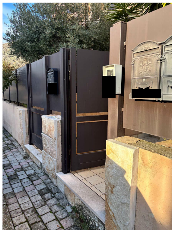
Vista cancello di accesso allo stabile
