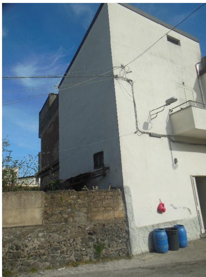
Foto 4 – Vista esterna fabbricato: dettaglio prospetto laterale
