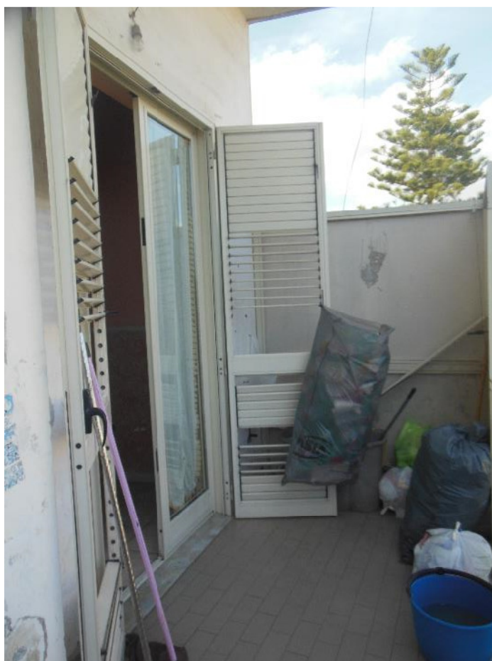
Foto 20 - Vista esterna balcone n. 2: dettaglio porta-finestra cucina
