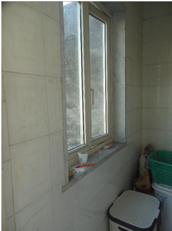
Foto 17 – Vista interna ripostiglio balcone n. 2: dettaglio finestrino
