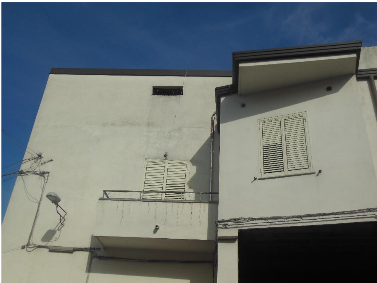
Foto 2 – Vista esterna fabbricato: dettaglio prospetto piano primo
