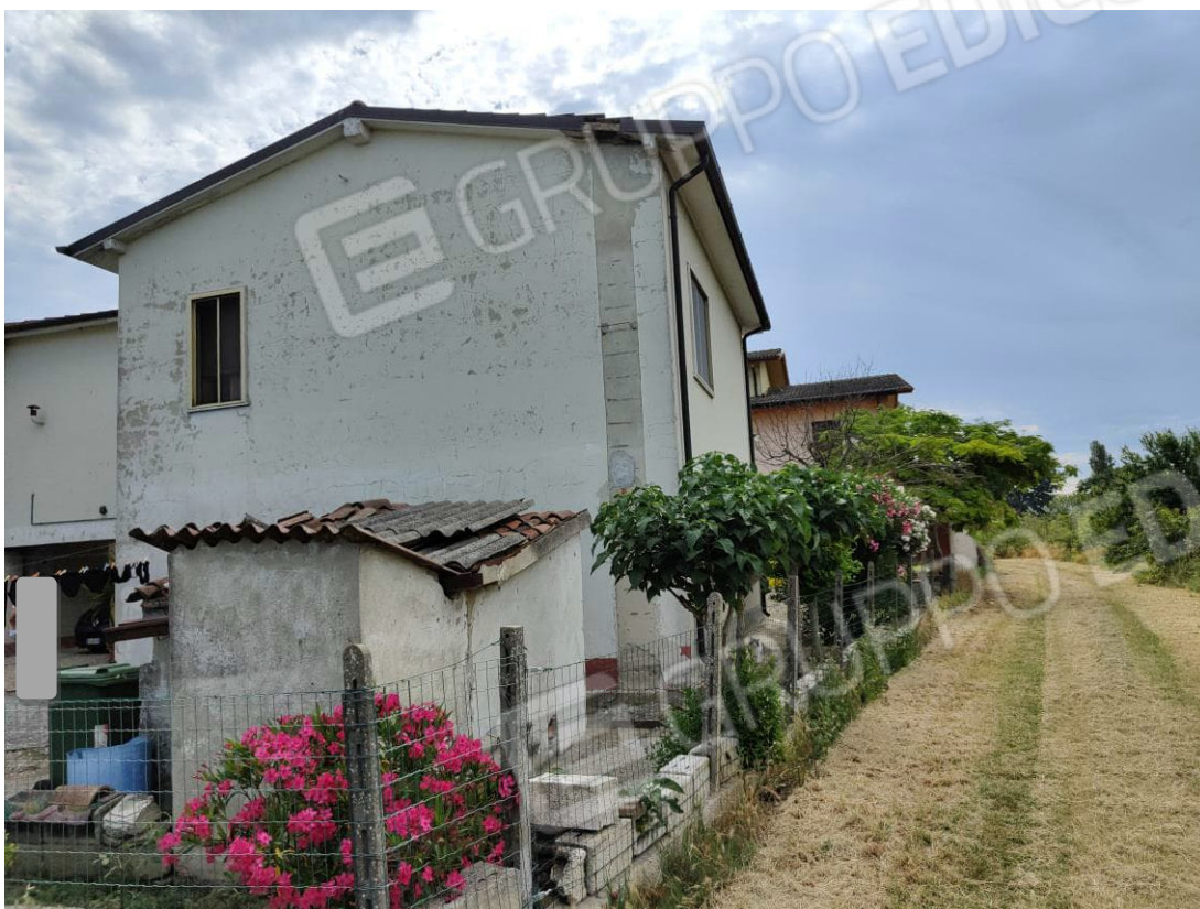
FOTO 3 – Prospetto posteriore e laterale
