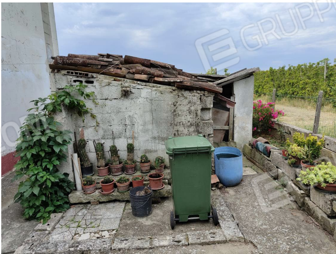
FOTO 4 – pollaio/legnaia da demolire
