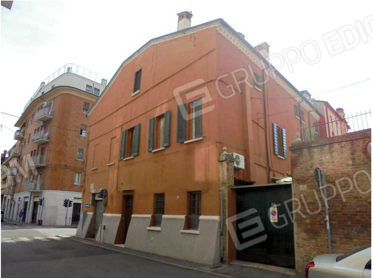
Foto 3. Prospetto nord – est . Vista da Via Bagaro.
