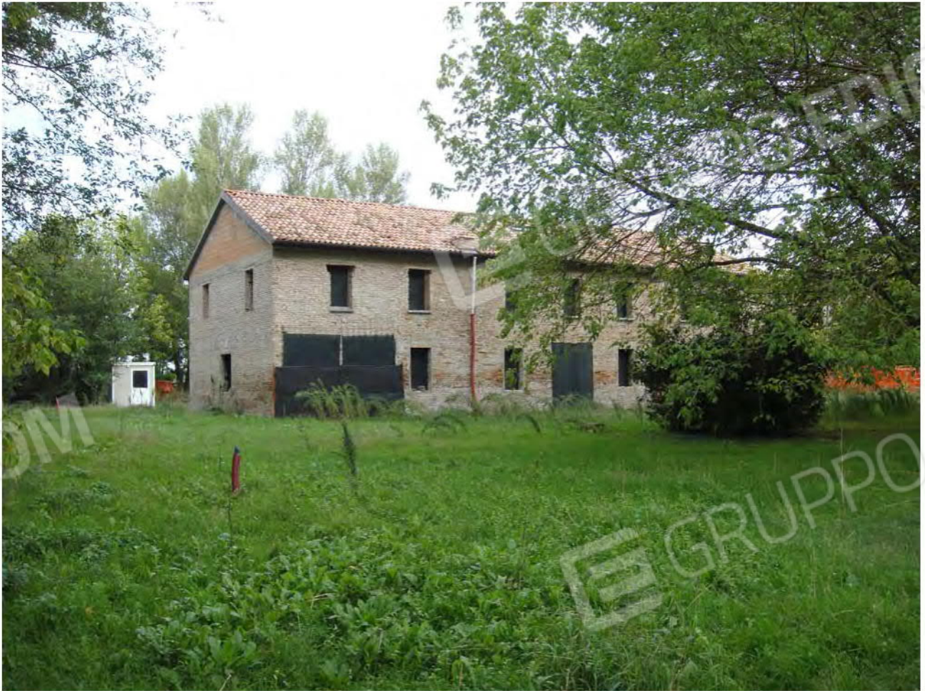
Foto 21. Mapp. 119. Prospetto Sud-Est e prospetto Sud-Ovest.
