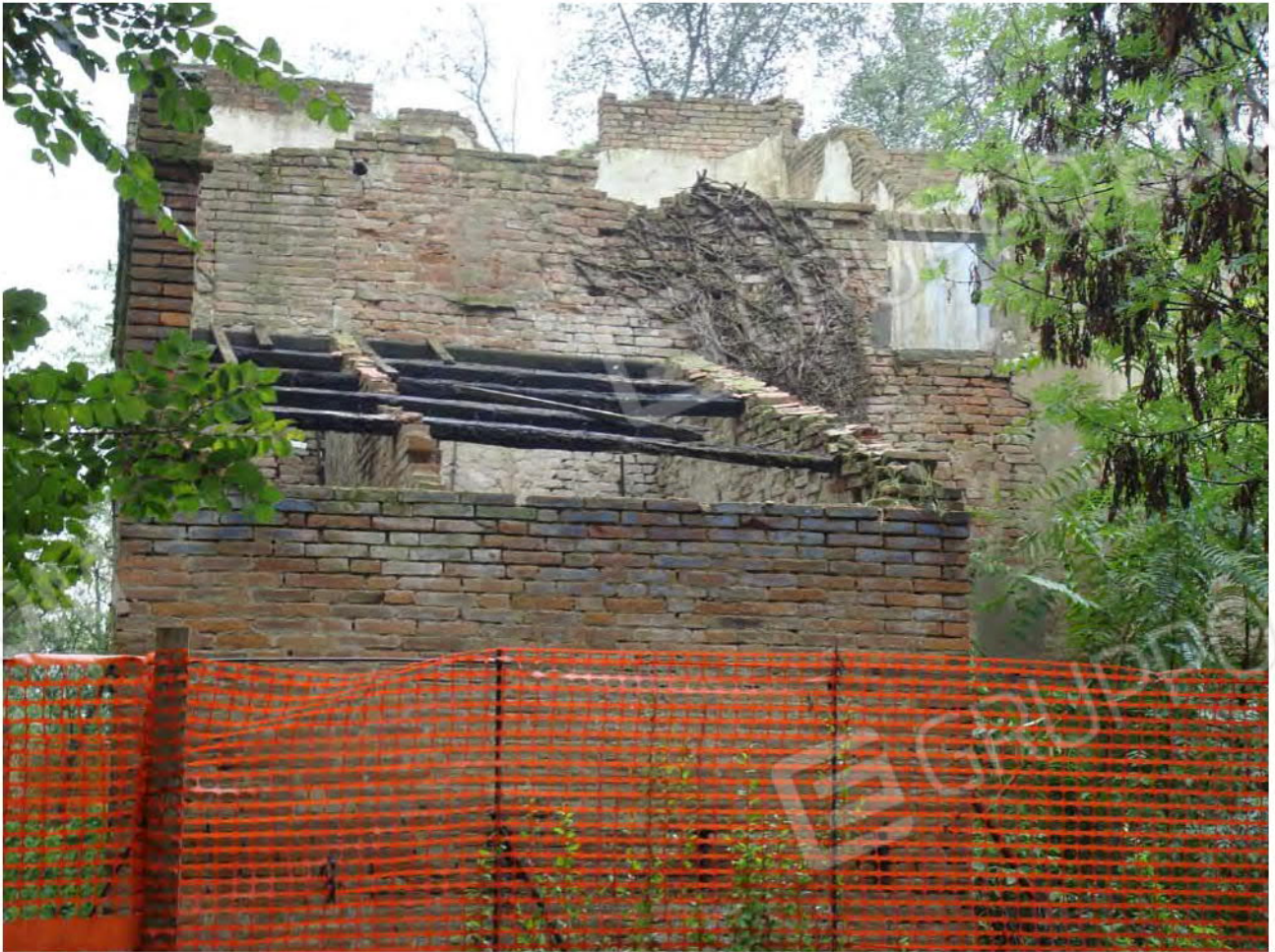
Foto 17. Mapp. 142 (ex mapp. 22). Parte del prospetto Nord-Ovest.
