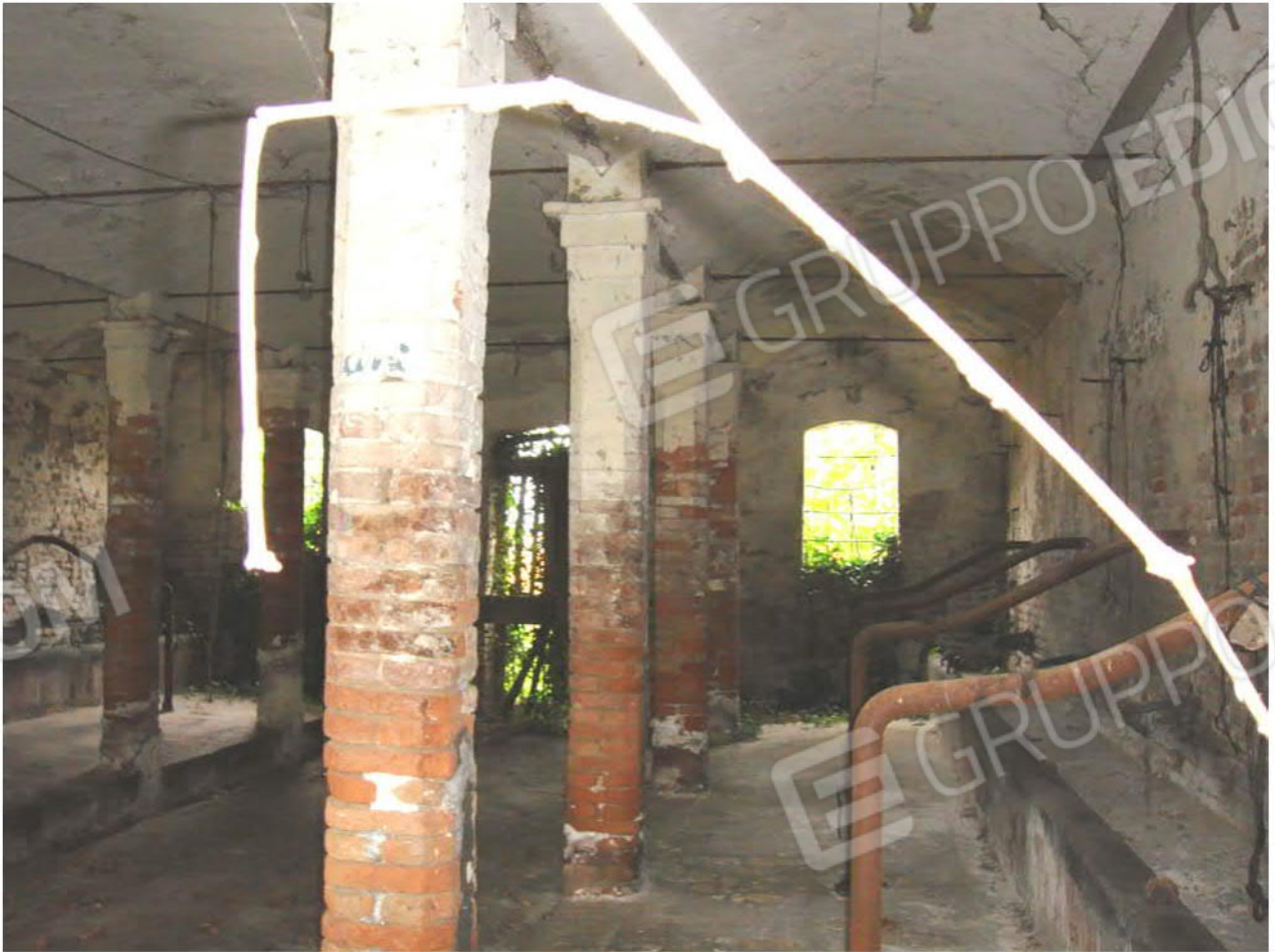
Foto 34. Mapp. 143 (ex mapp. 118). Particolare degli interni.
