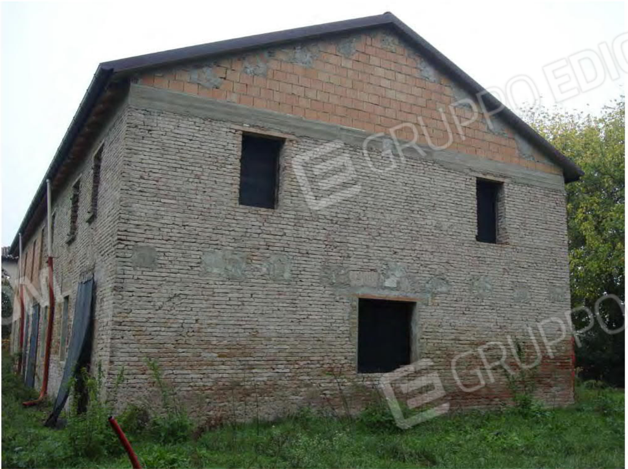
Foto 24. Mapp. 119. Prospetto Sud-Ovest.
