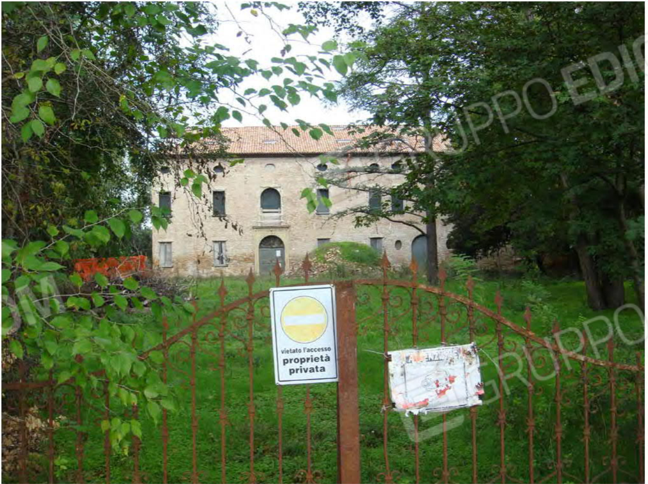
Foto 5. Mapp. 23. Prospetto Sud-Est.
