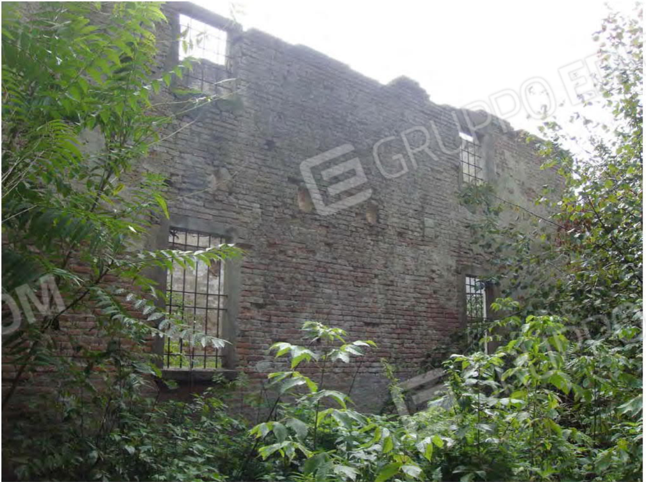
Foto 18. Mapp. 142 (ex mapp. 22). Parte del prospetto Nord-Ovest.
