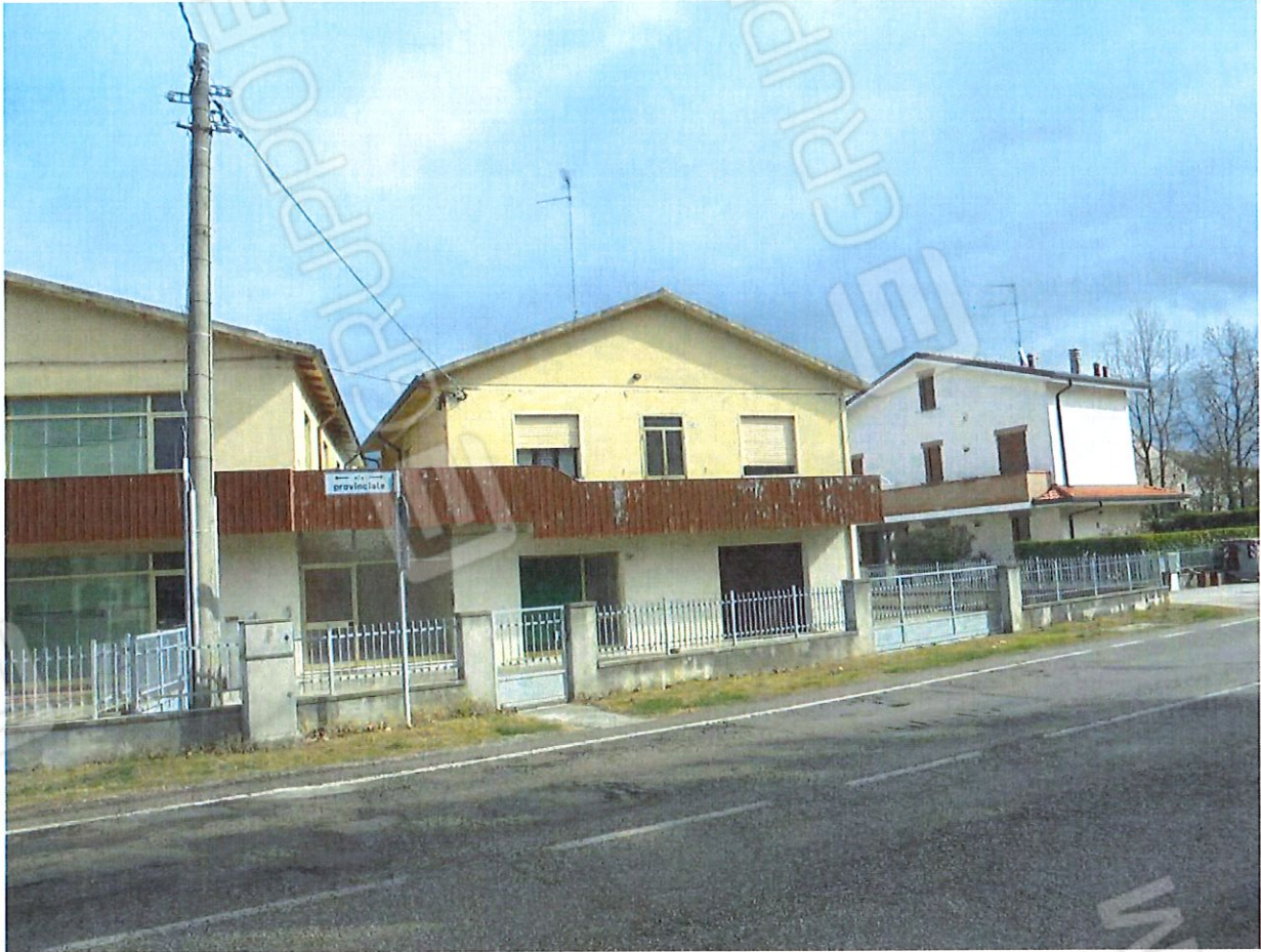
Foto 2. Prospetto Sud – Ovest. Vista da Via Provinciale.
