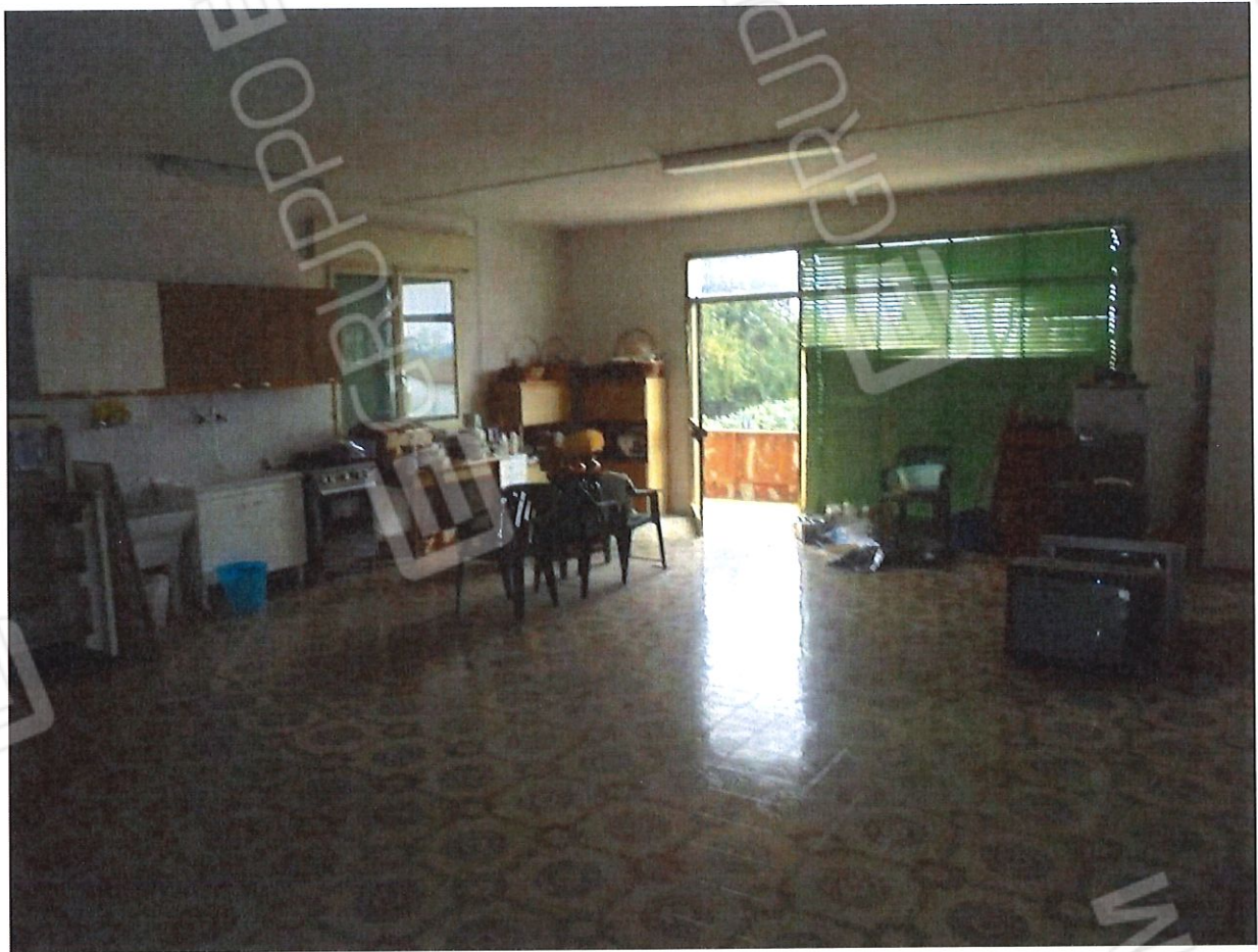
Foto 16. Magazzino – Piano primo. Particolare degli interni.
