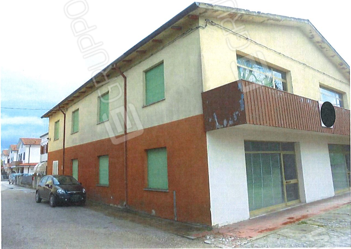
Foto 3. Prospetto Nord – Ovest. Vista da Via Provinciale.
