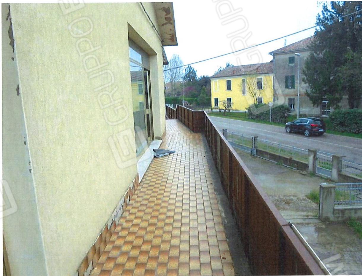
Foto 8. Prospetto Sud - Ovest. Magazzino.
