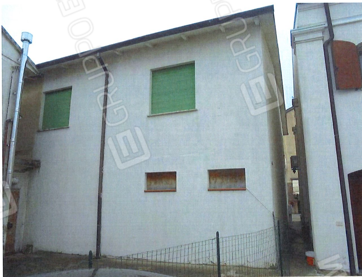
Foto 6. Prospetto Sud – Est.
