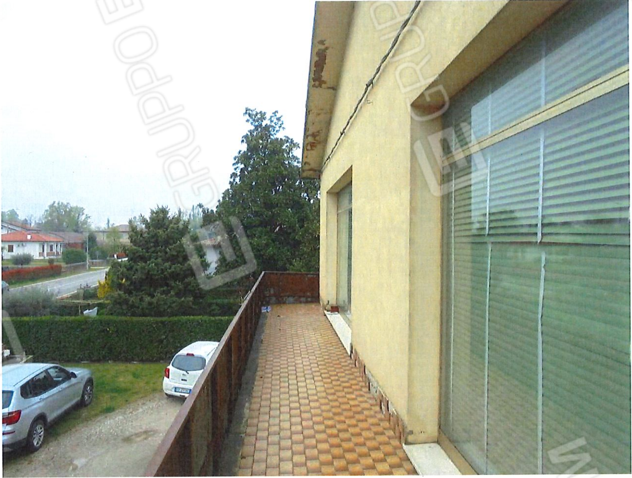
Foto 7. Prospetto Sud – Ovest. Magazzino.
