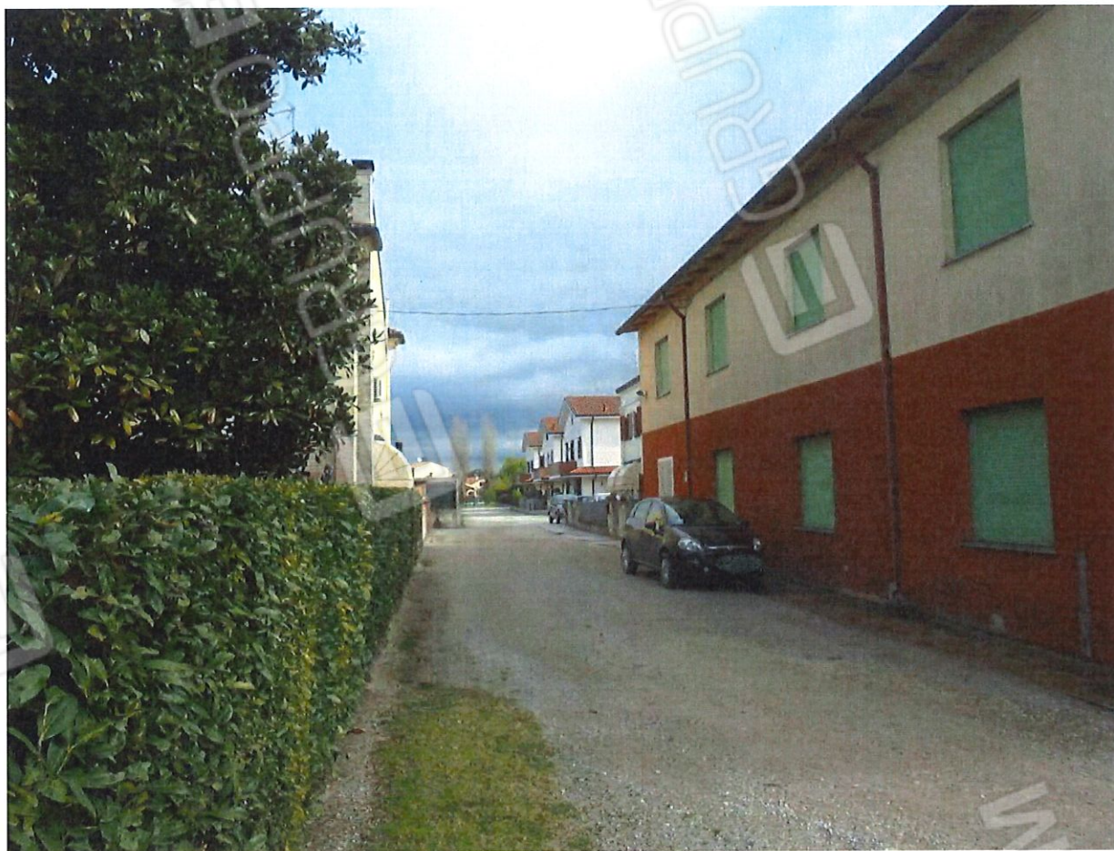
Foto 4. Prospetto Nord – Ovest. Vista da Via Provinciale.
