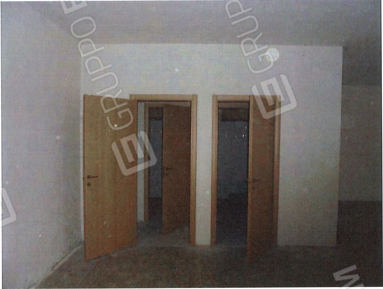
Foto 15. Magazzino – Piano terra. Particolare degli interni.
