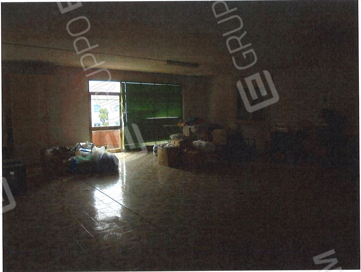
Foto 17. Magazzino – Piano primo. Particolare degli interni.
