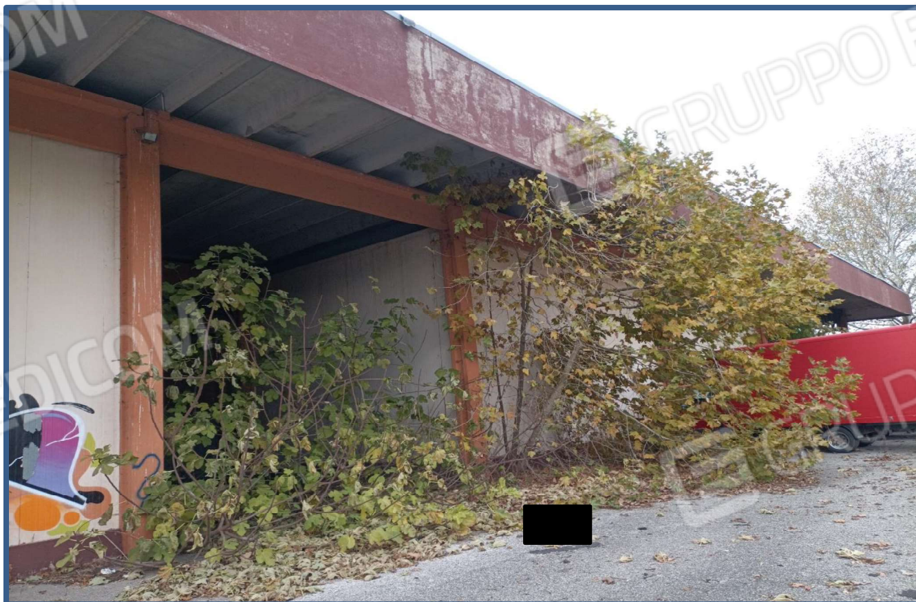
Foto 4 Tettoia celle sul lato est del fabbricato
