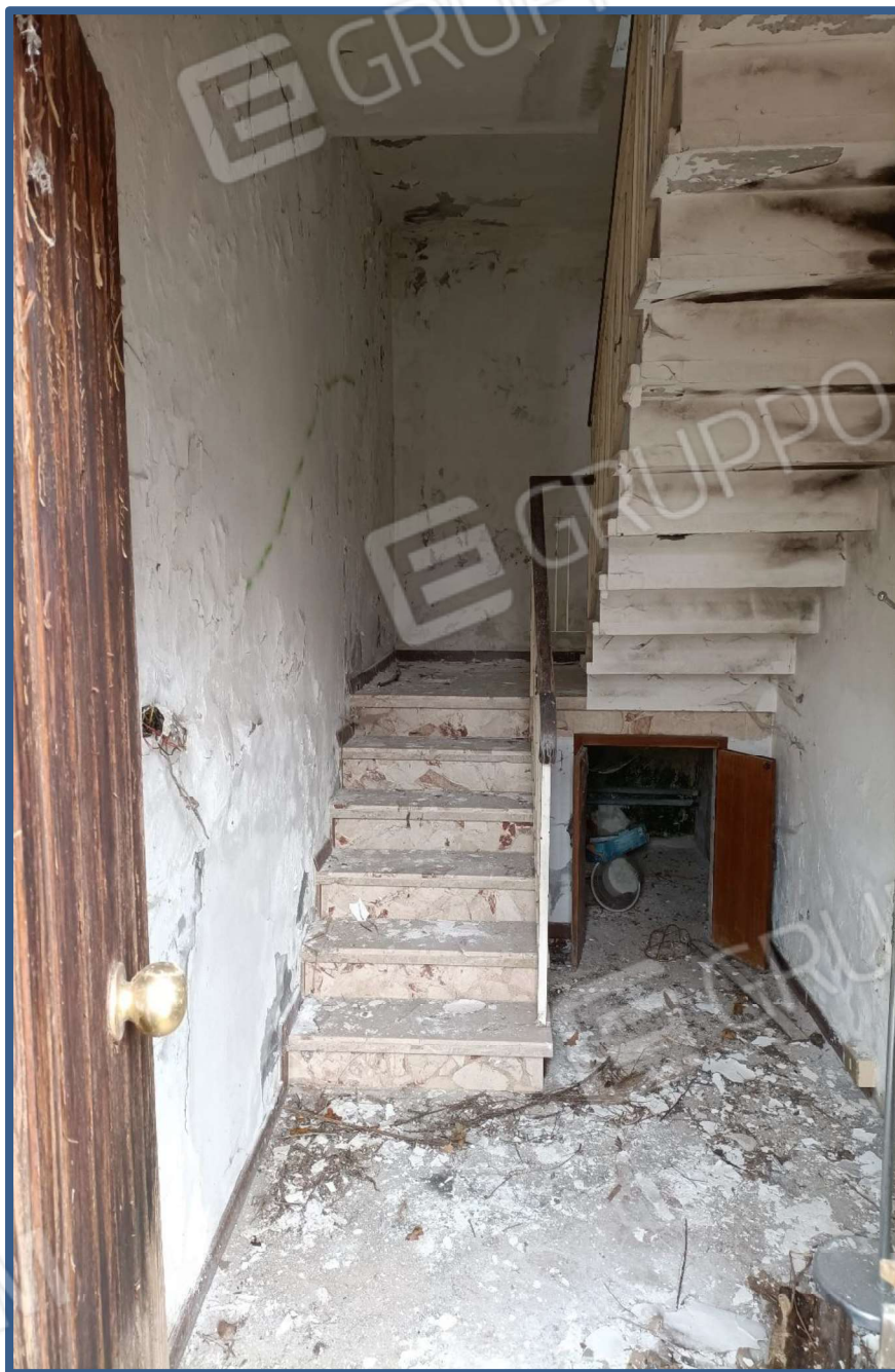
Foto 17 – ingresso al primo piano dell'unità abitativa
