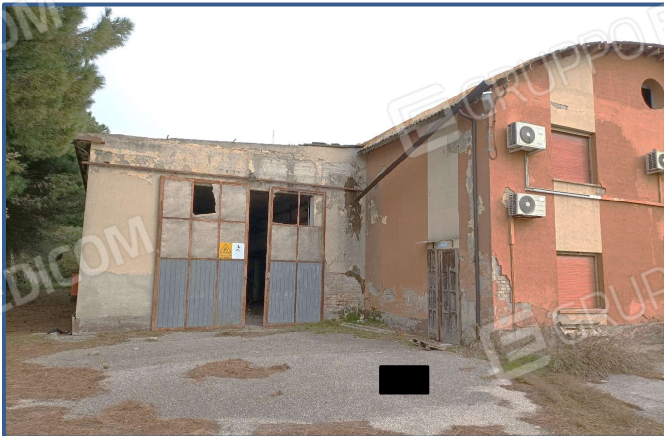
Foto 2 Vista accesso laterale
