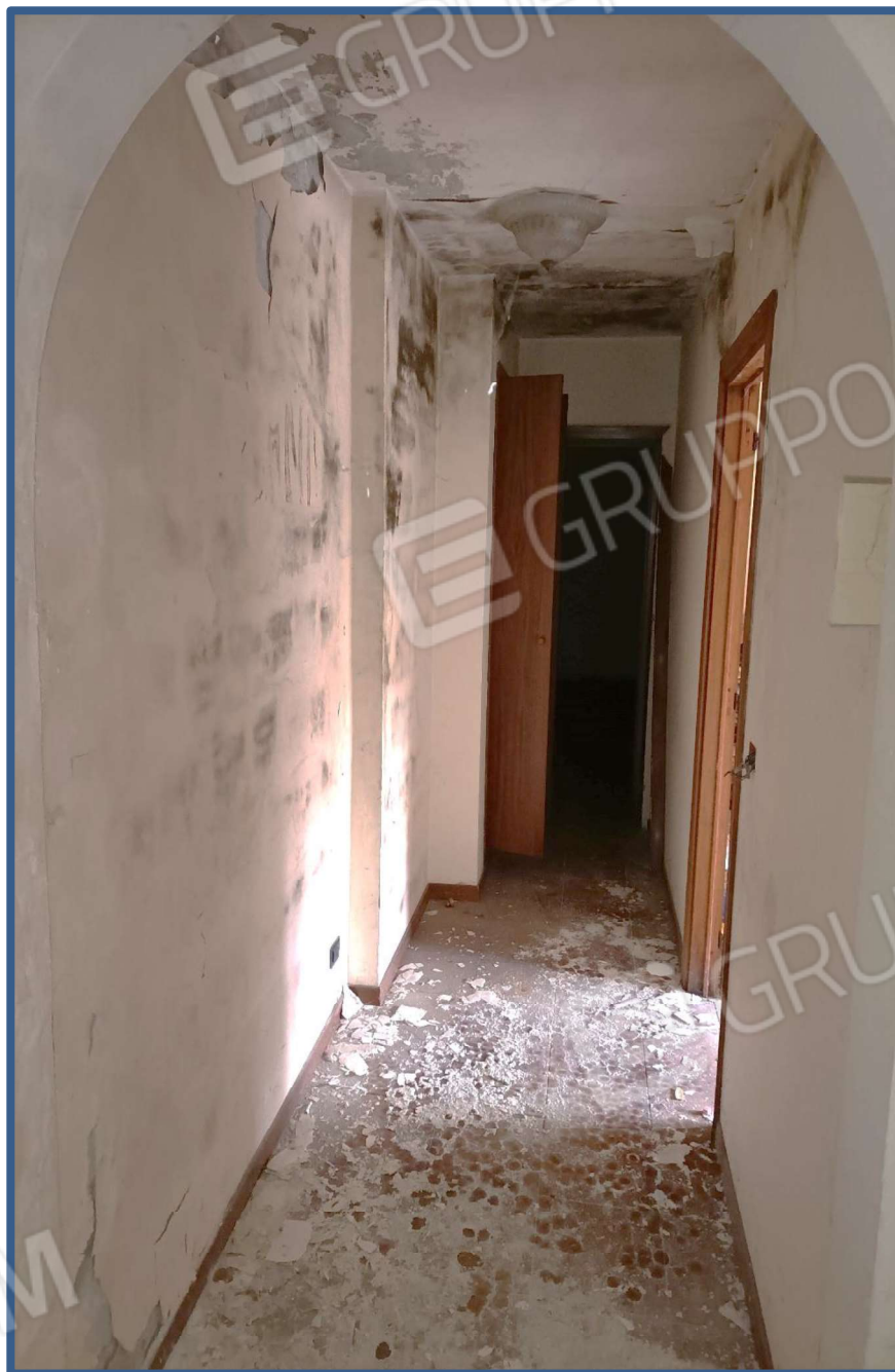
Foto 22 – corridoio appartamento piano primo
