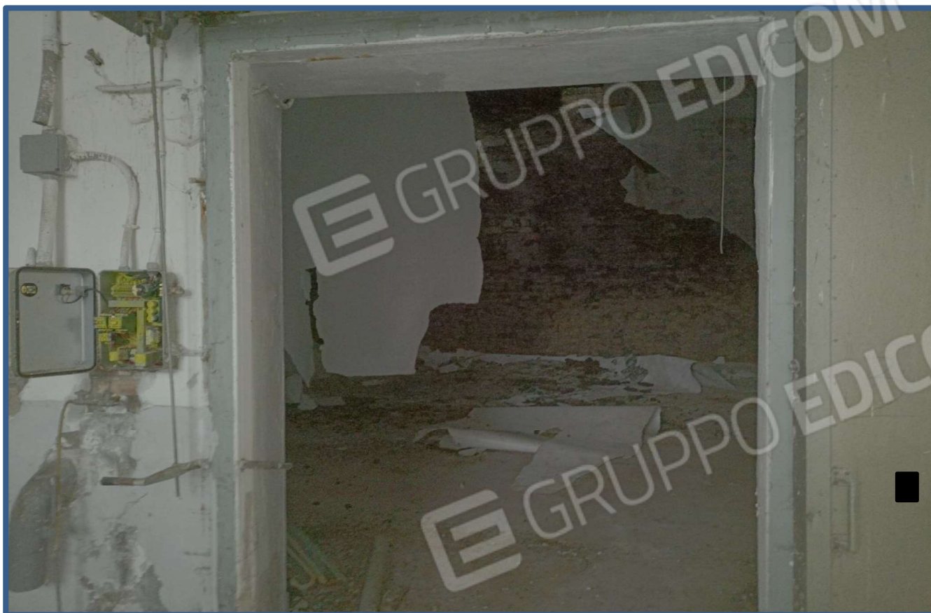
Foto 9 – celle con cedimenti al suo interno
