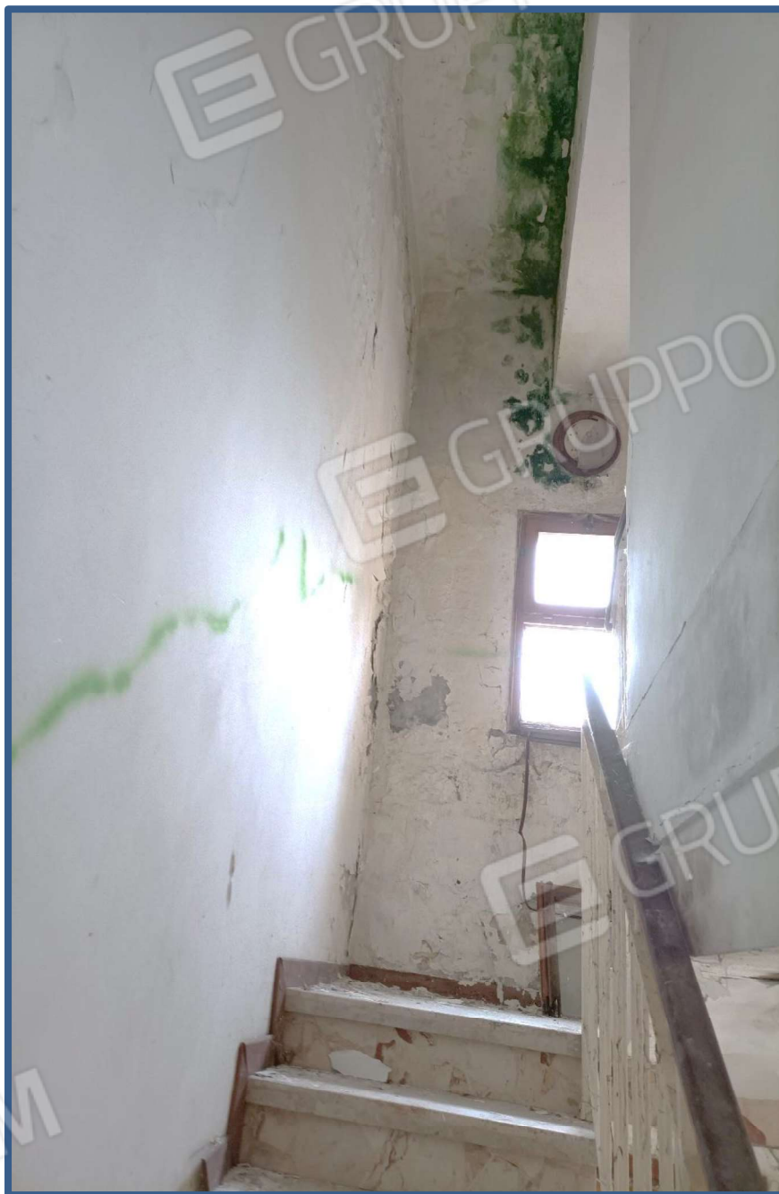
Foto 21 – Scala accesso piano primo
