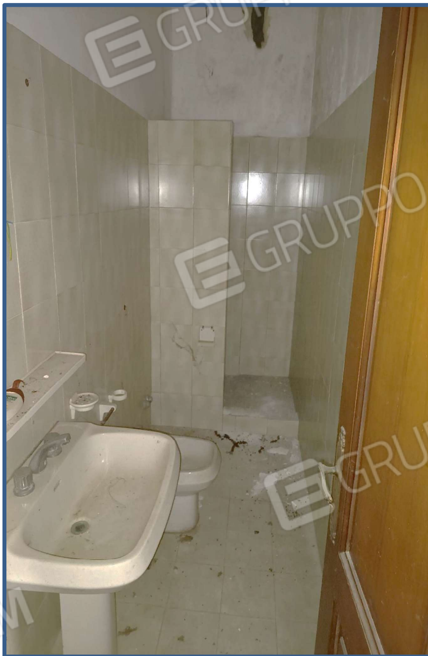
Foto 20 – bagno piano terra
