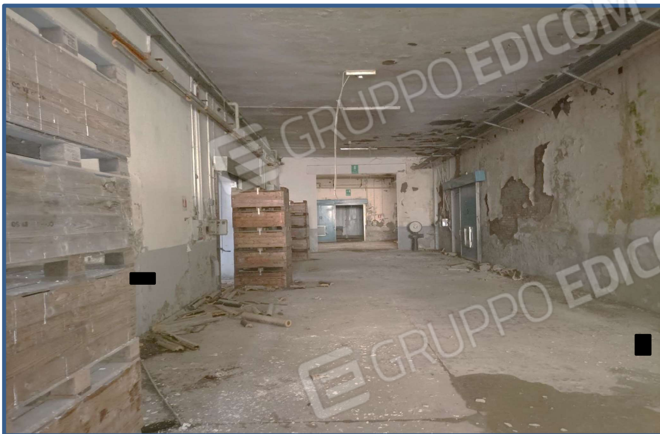
Foto 13 – Vista interna corridoio accesso celle
