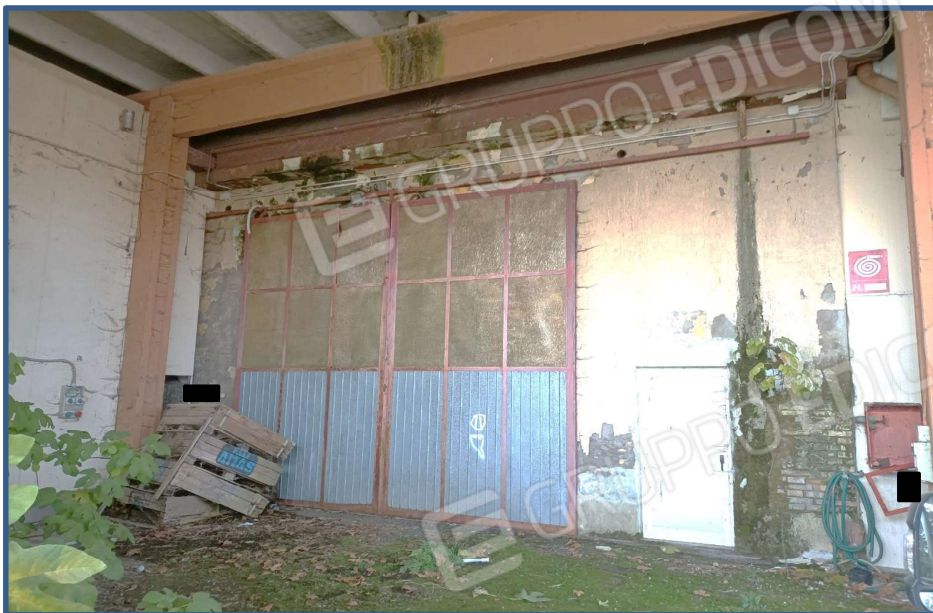
Foto 5 – Portone di accesso sotto la tettoia lato est
