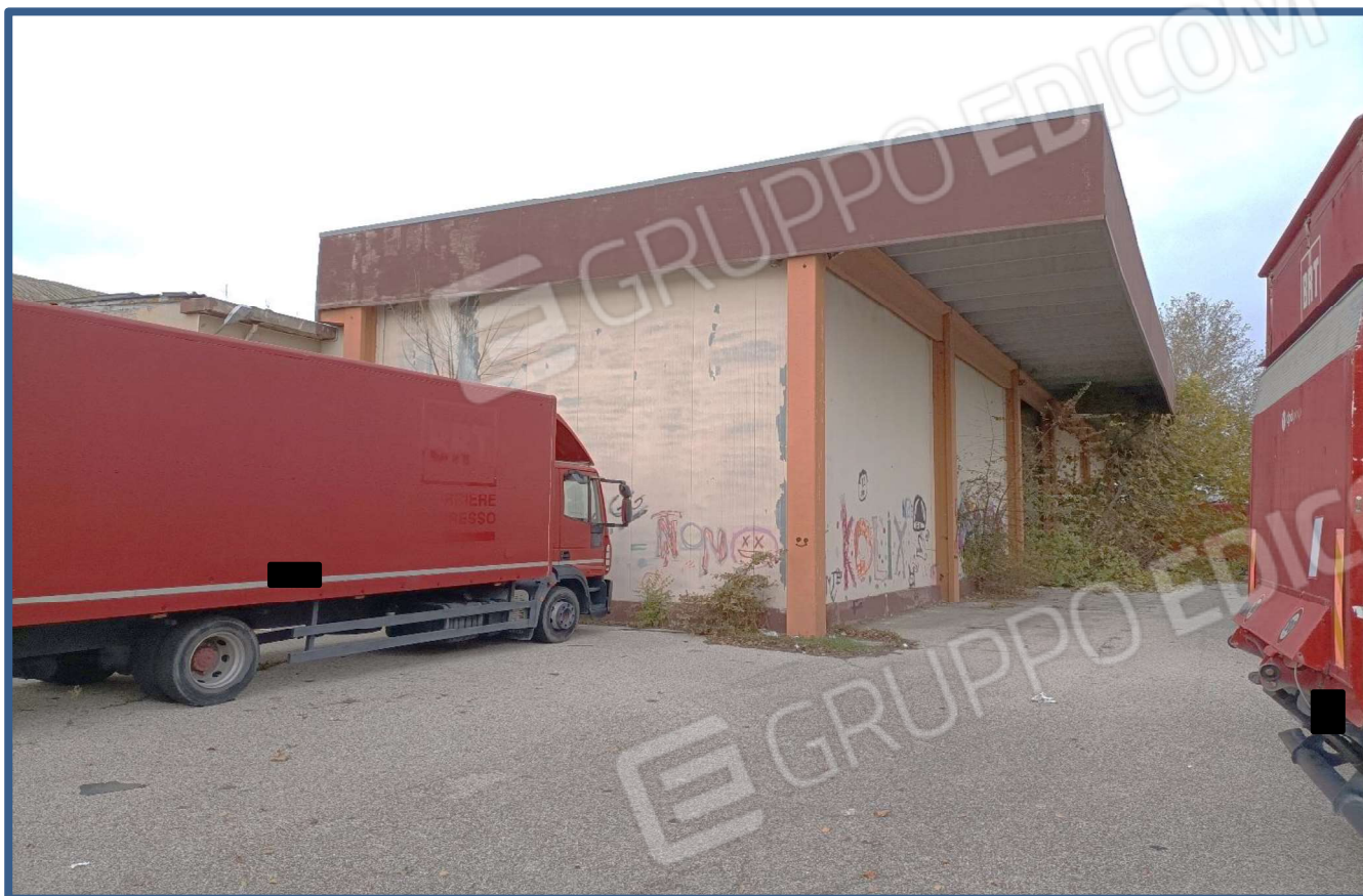
Foto 3 – Tettoia celle sul lato est del fabbricato
