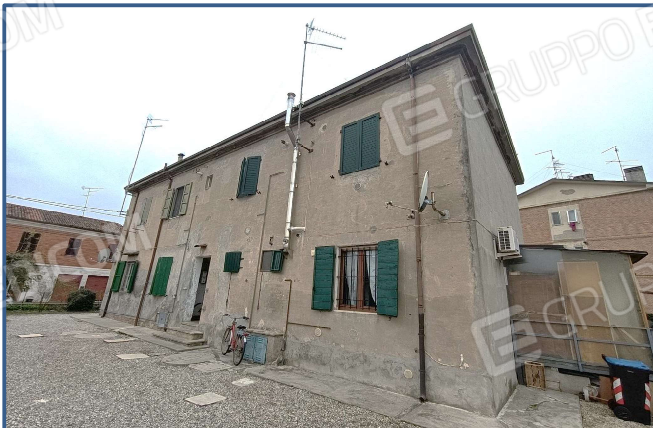
Foto 2 Vista prospetto principale
