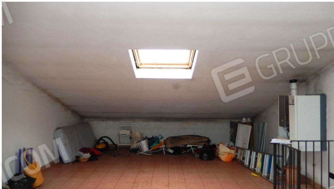
Ripostiglio sottotetto (falda nord)
