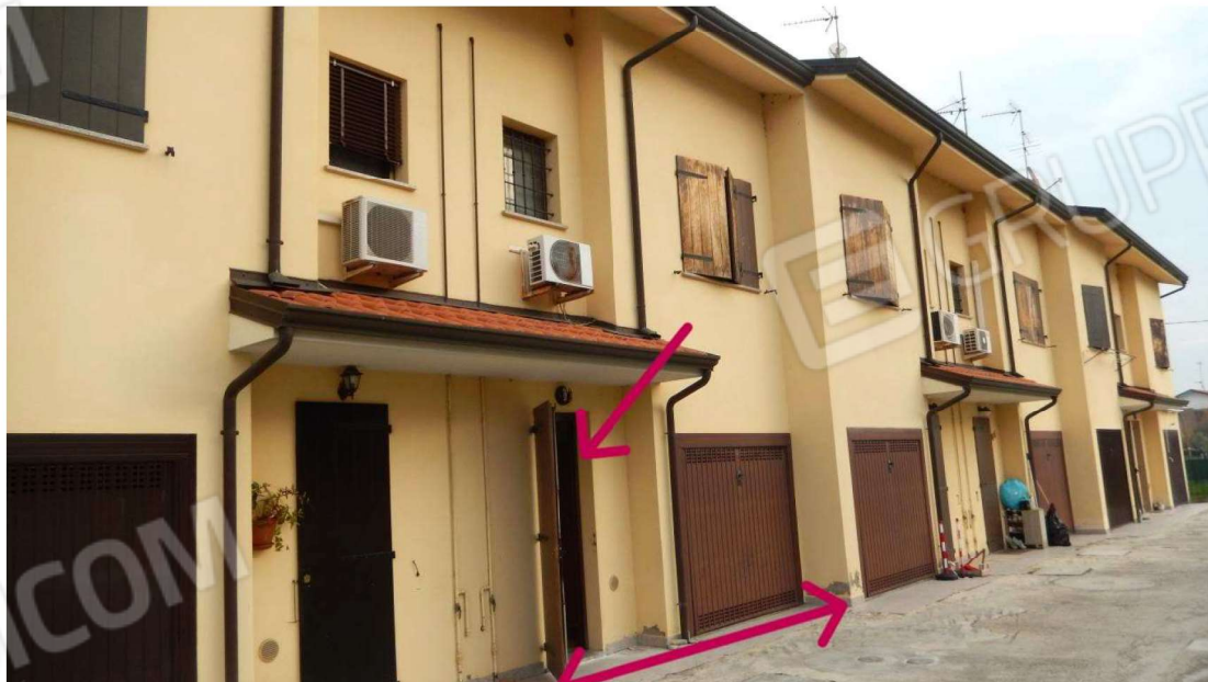
Prospetto sud – porzione in oggetto e accesso alla cucina
