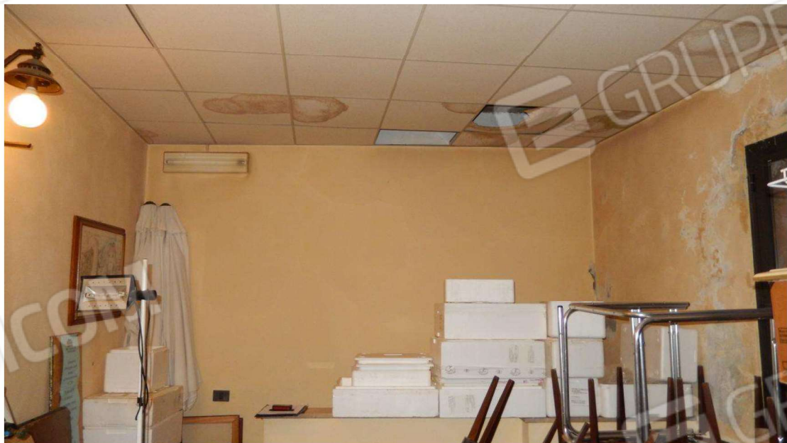
Zona ufficio / deposito al piano primo
