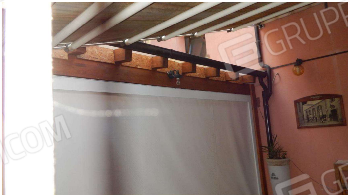
Particolare copertura in policarbonato della tettoia su parte della corte di via Capo Volte
