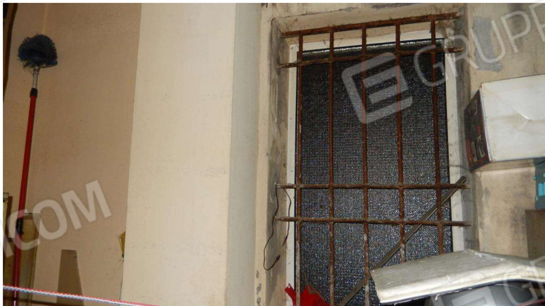
Particolare affaccio di terzi su pozzo luce
