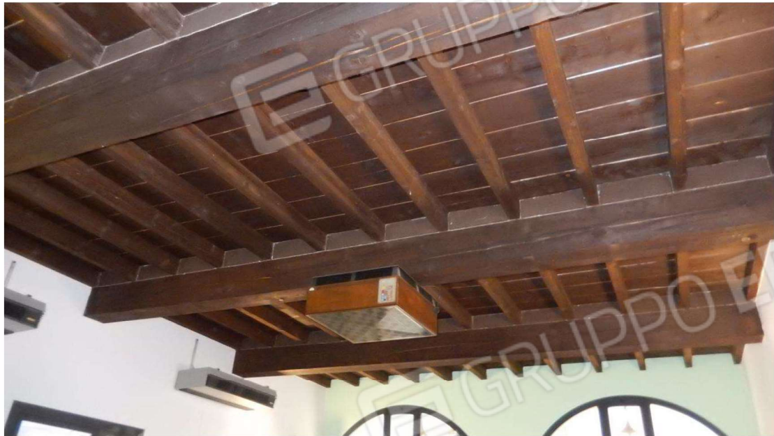
Particolare solaio e impianto riscaldamento
