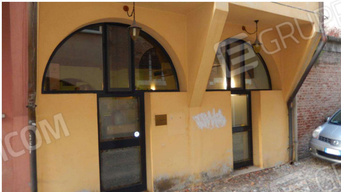
Particolare prospetto con accesso sala ristorante, da via Capo delle Volte
