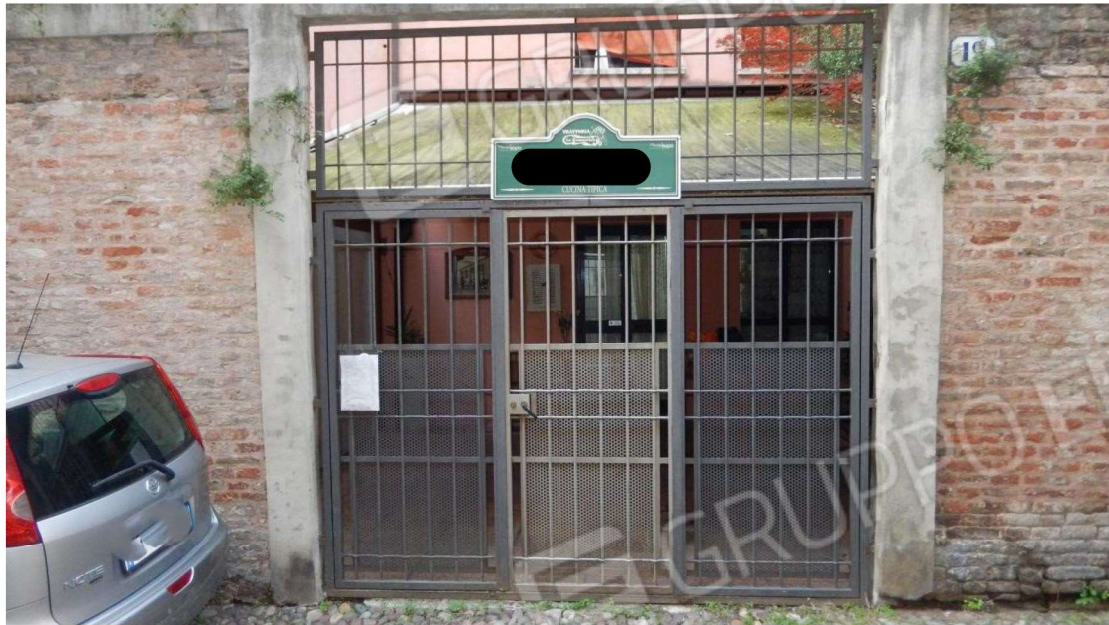
Particolare cancellata su via Capo delle Volte
