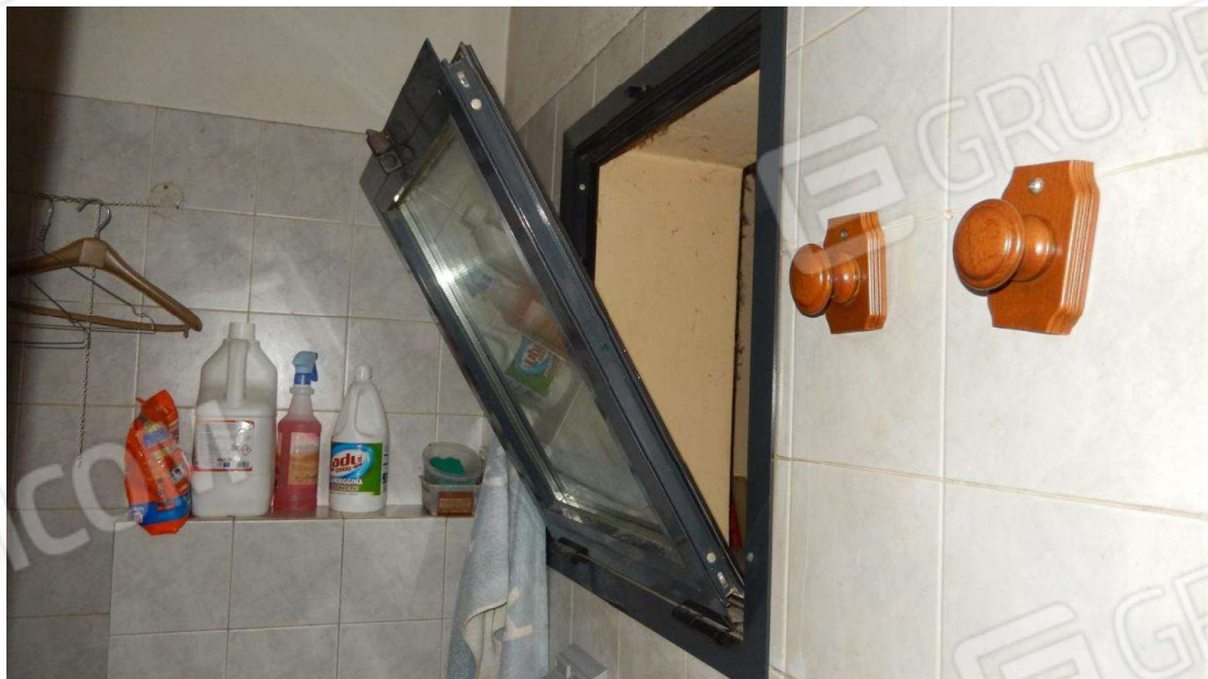
Particolare infissi esterni in alluminio
