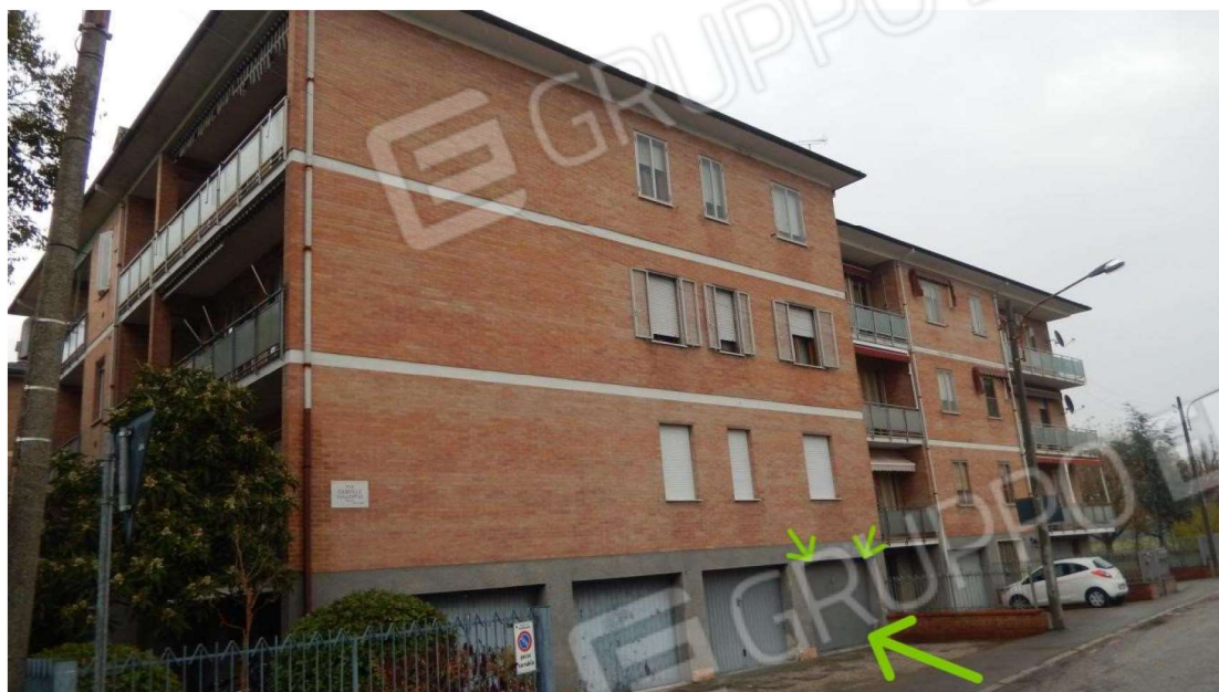
Prospetto sud verso ferrovia (via Falloppio) e accesso autorimessa
