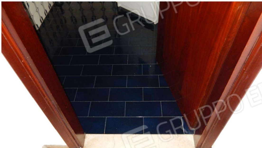
Particolare ceramiche bagni e infissi interni (vetusti)
