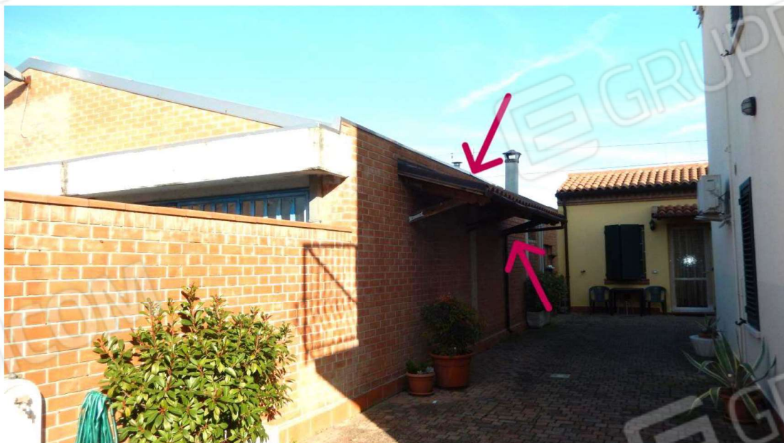
Confine est con terzi (Particolare tettoia installata su muro perimetrale)
