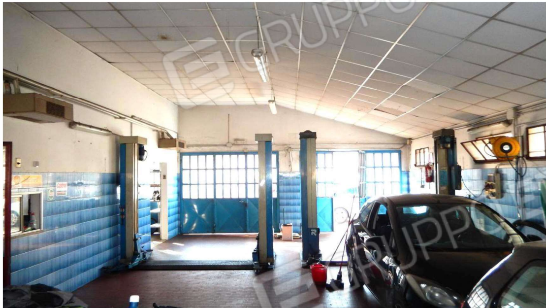
Interno officina verso ingresso e corte antistante
