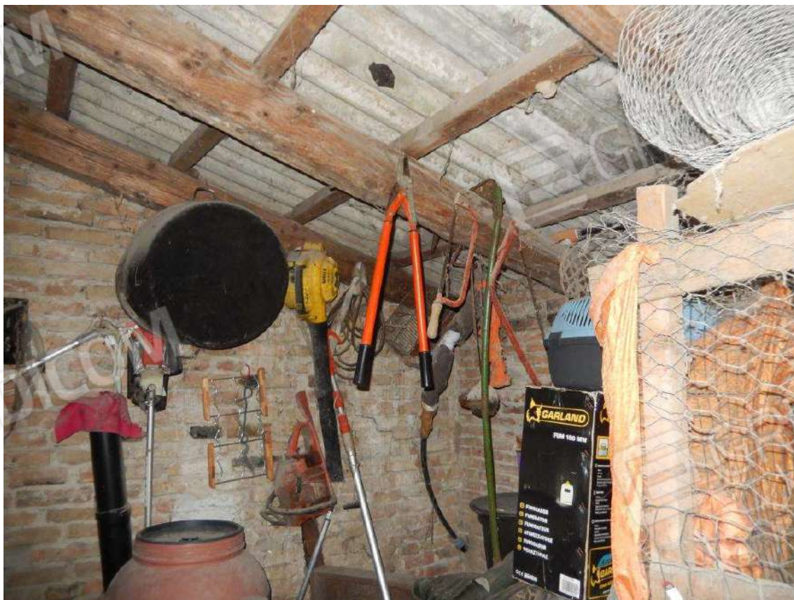
INTERNO CANTINA DEL PROSERVIZIO DISCOSTO
