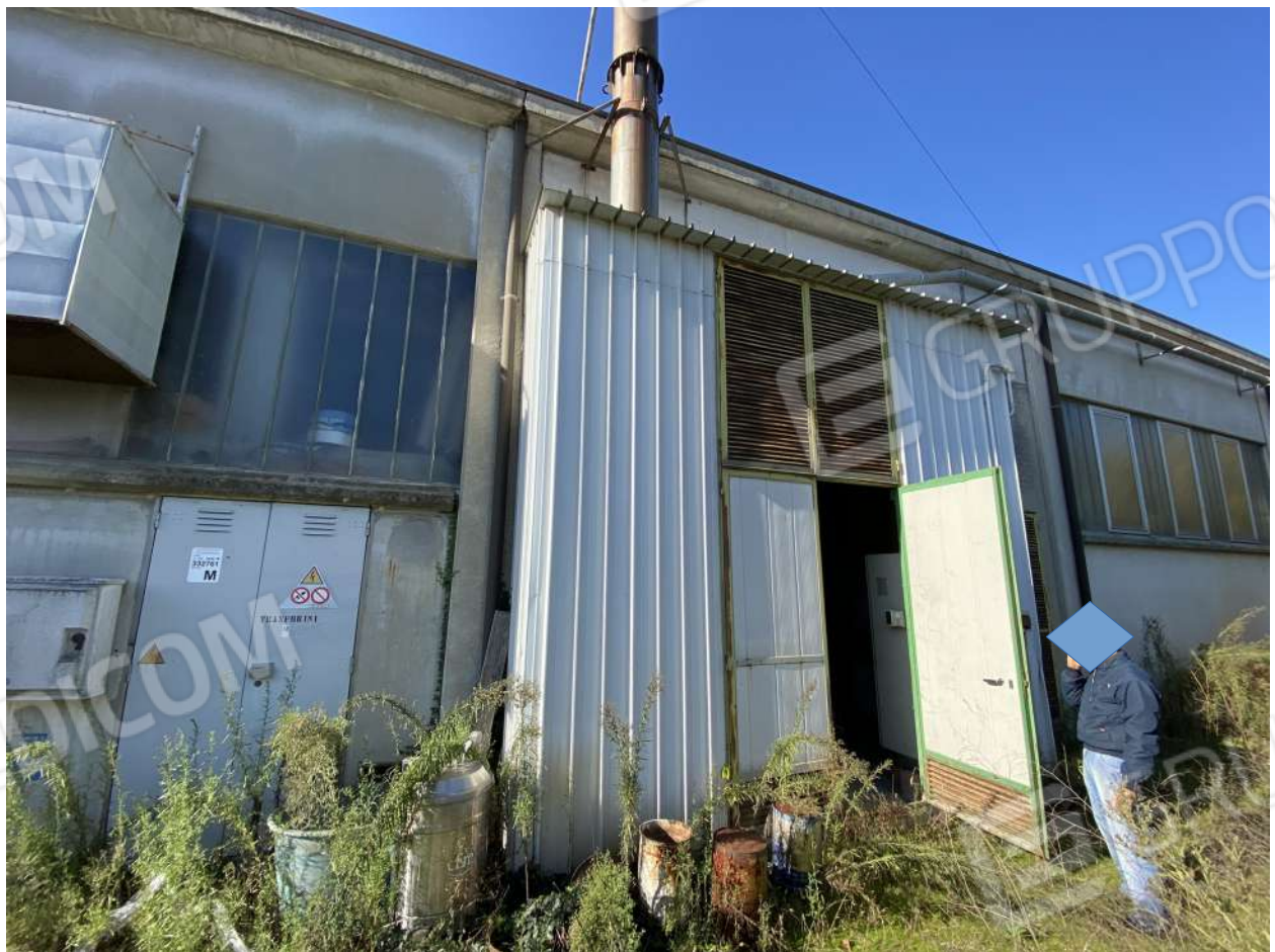
ingresso centrale termica dal prospetto laterale
