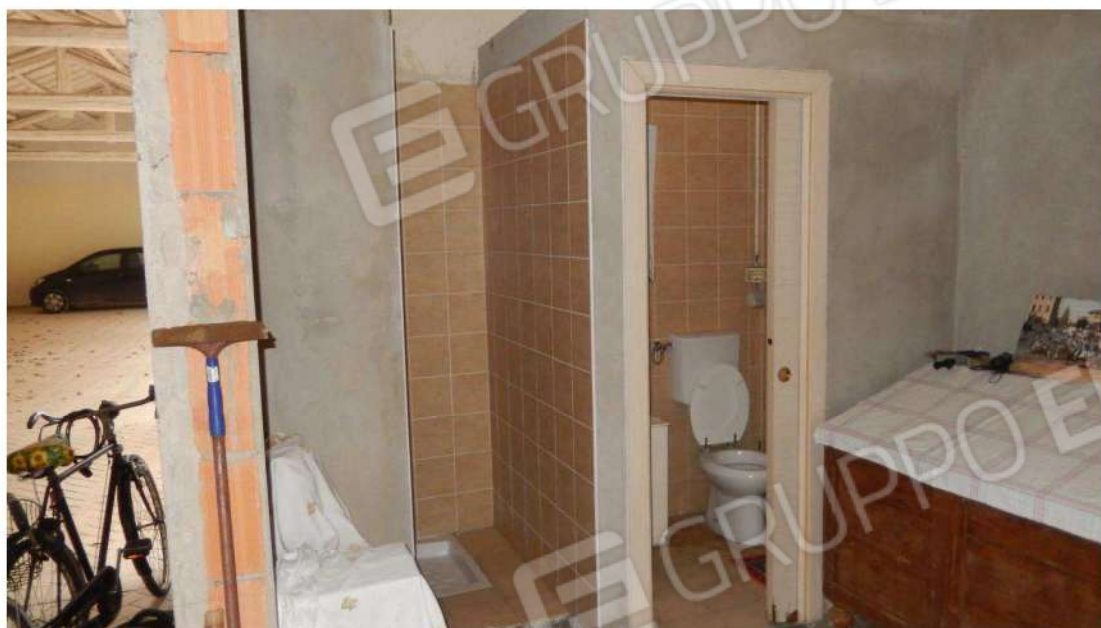
Bagno e doccia da demolire
