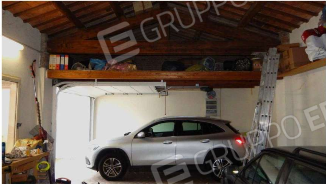
Interno autorimessa verso portone carrabile
