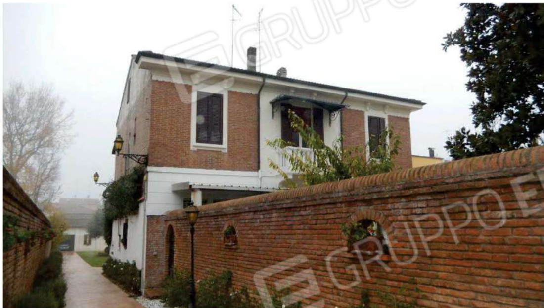
Prospetto principale (nord) verso via Piangipane del corpo villa e corsello carrabile verso autorimessa
