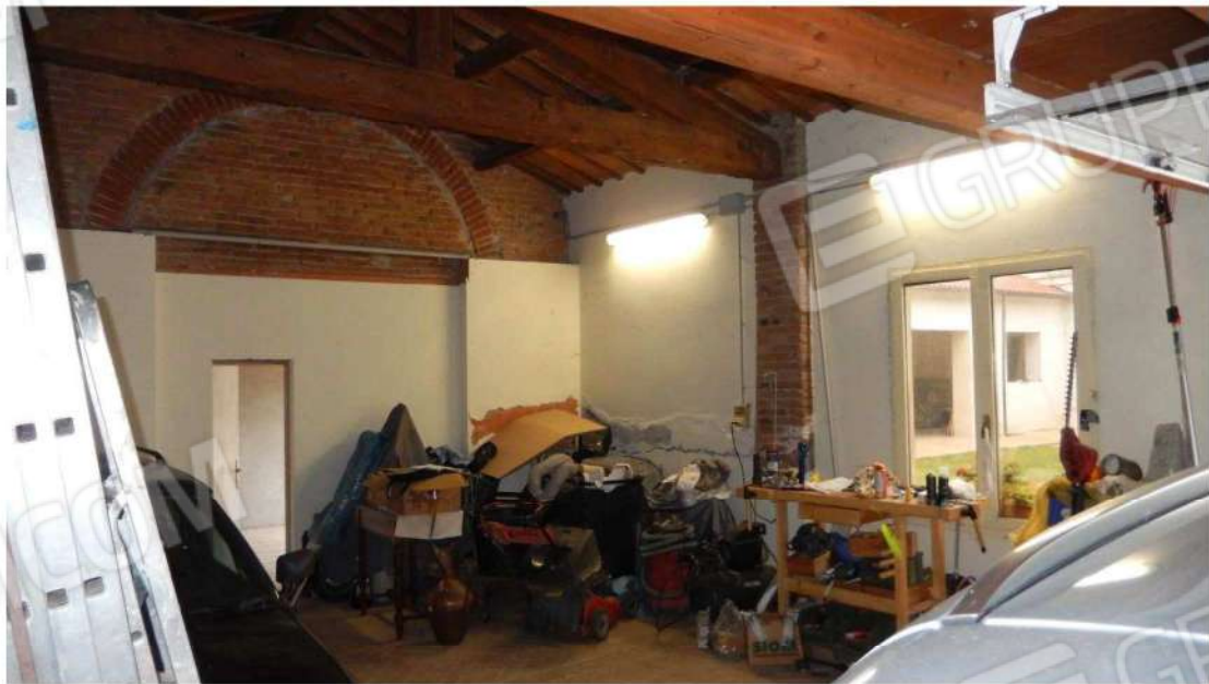
Particolare Interno autorimessa
