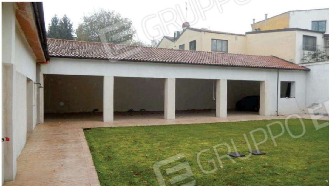
Prospetto est, affaccio su corte interna
