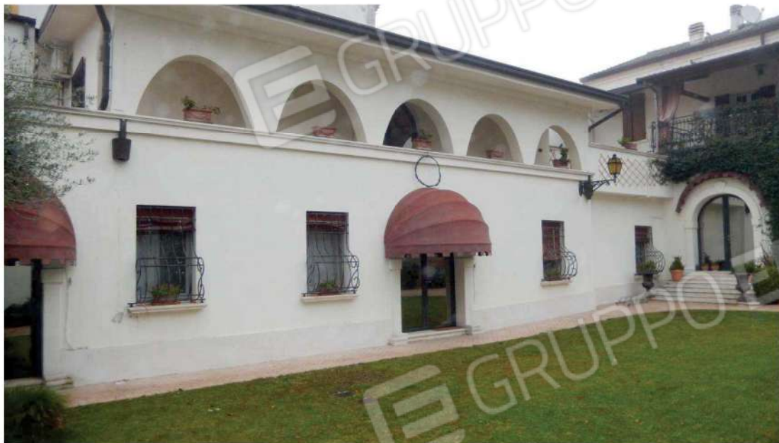
Prospetto est, del corpo dependance P.T e P.1, su corte interna Sopraelevata
