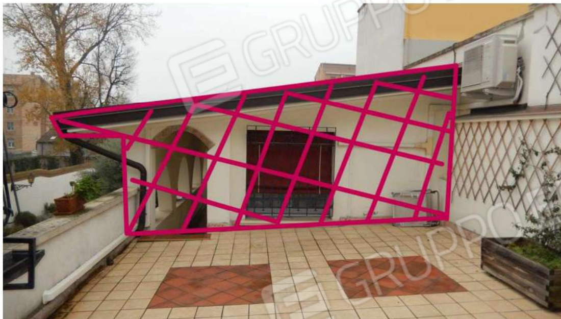
Particolare su prospetto sud della demolizione
