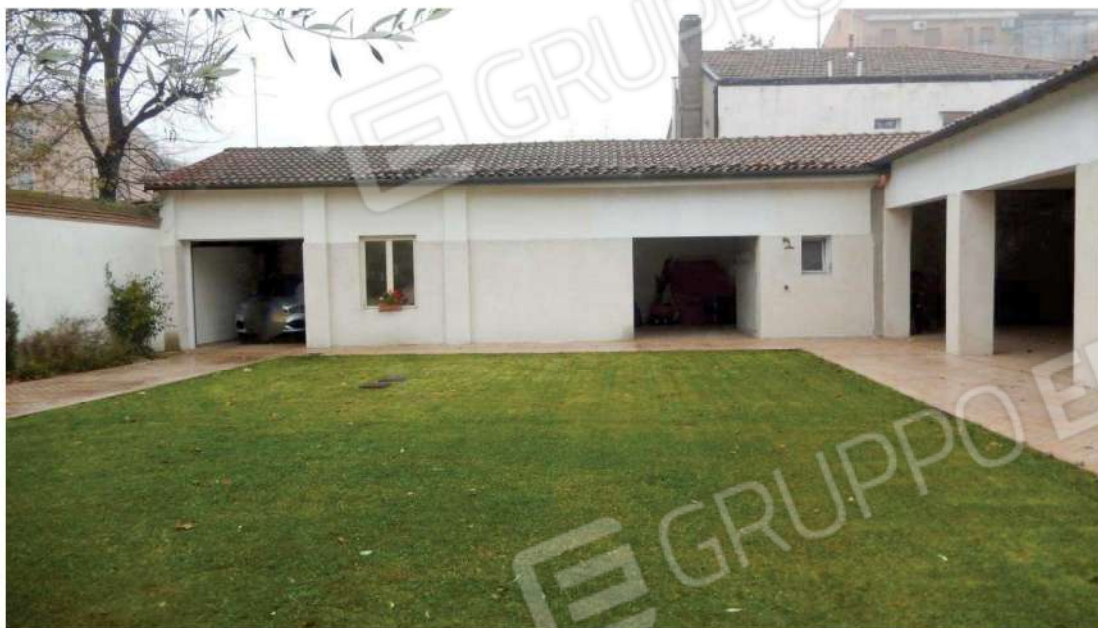
Corte interna verso autorimessa e magazzino / deposito / chiostro
