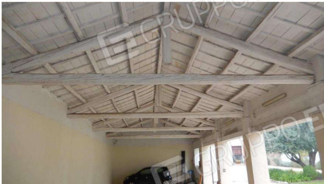
Particolare capriate originarie di primo impianto
