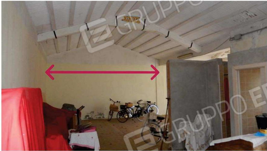
Porzione da demolire
