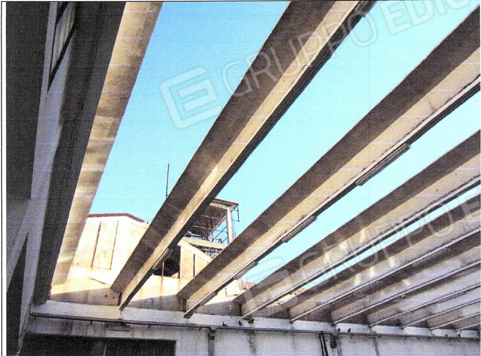
INTERNO CORPO DI FABBRICA LATO STRADA - RIMOSSA COPERTURA IN FIBROCEMENTO
