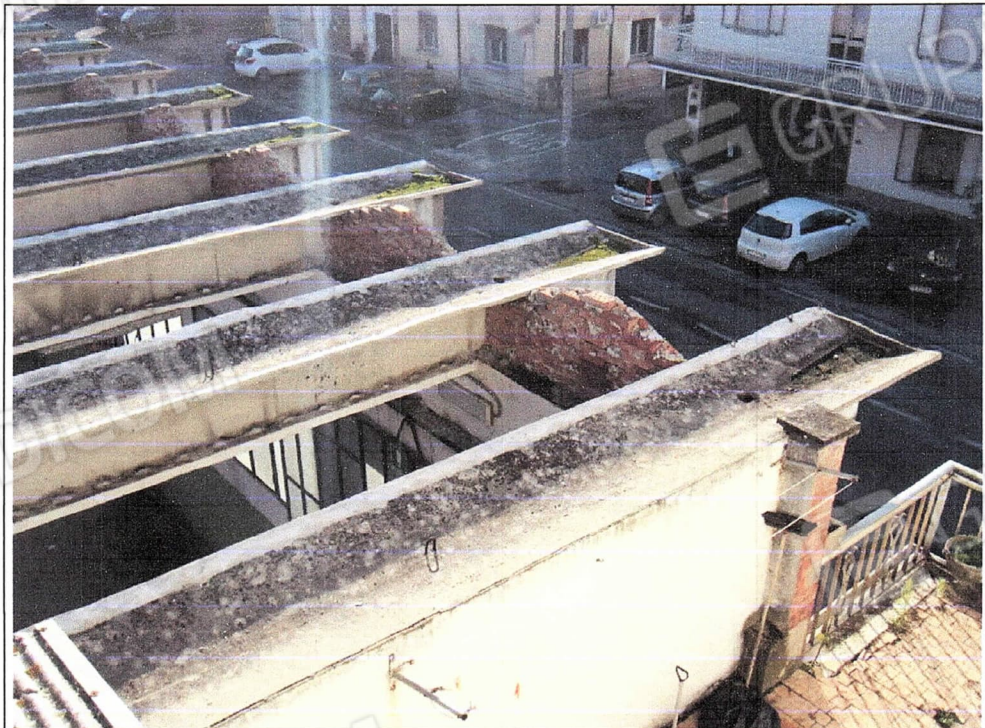
VEDUTA DALL'ALTO - RIMOSSA COPERTURA IN FIBROCEMENTO
