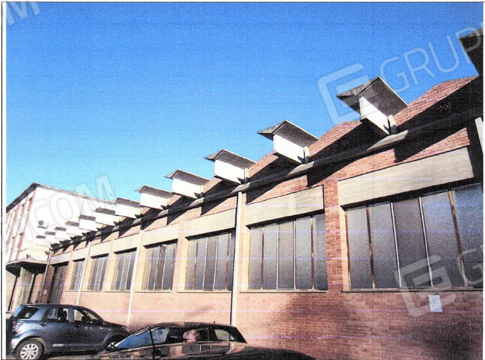
FACCIATA SU VIA DODICI MORELLI (RIMOSSA COPERTURA IN FIBROCEMENTO)
