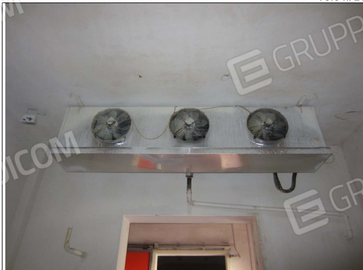
INTERNO MAGAZZINO-FRIGO-LAVORAZIONE MAPP. 239 SUB 5
