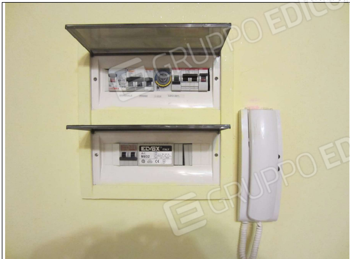
INTERNO UNITA' ABITATIVA MAPP. 239 SUB 6 – 35 SUB 28
