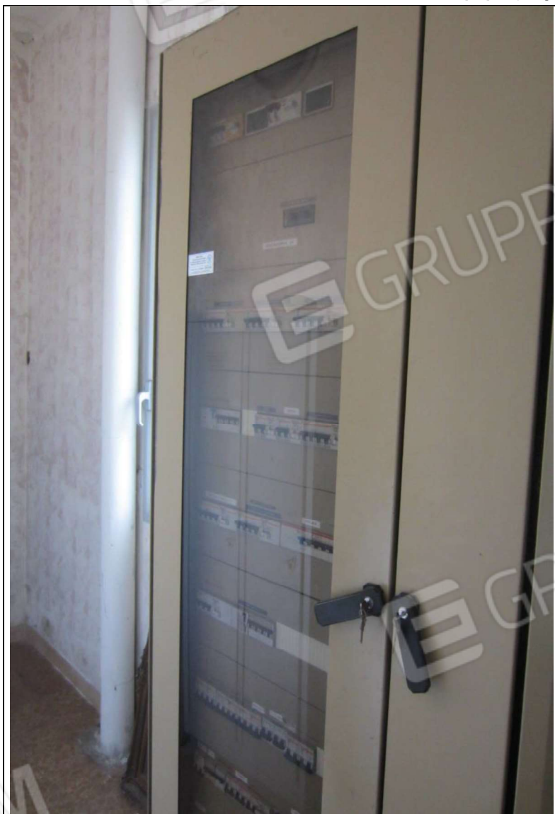
INTERNO MAGAZZINO-FRIGO-LAVORAZIONE MAPP. 239 SUB 5
