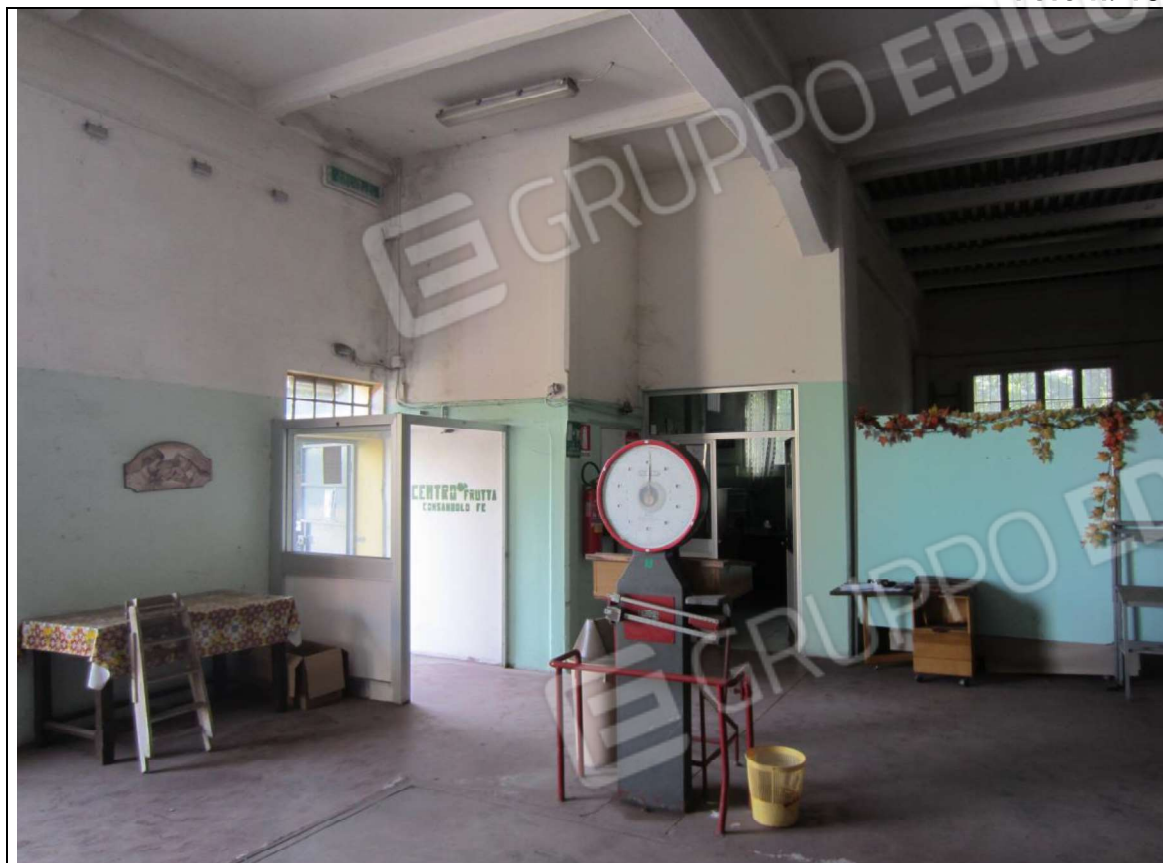
INTERNO MAGAZZINO-FRIGO-LAVORAZIONE MAPP. 239 SUB 5
