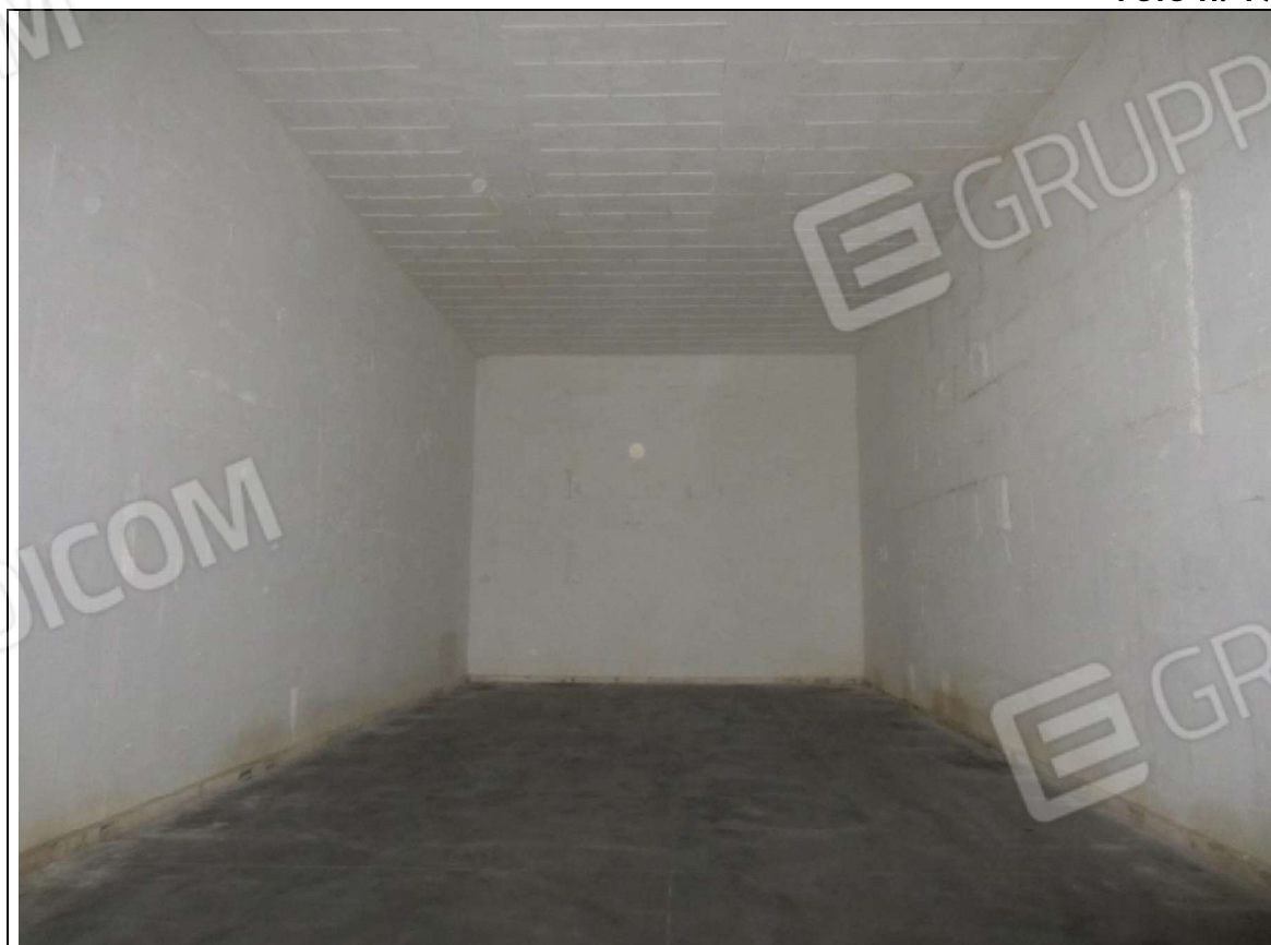
INTERNO MAGAZZINO-FRIGO-LAVORAZIONE MAPP. 239 SUB 5
