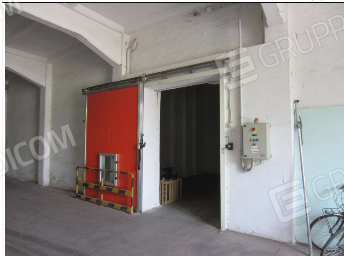
INTERNO MAGAZZINO-FRIGO-LAVORAZIONE MAPP. 239 SUB 5
