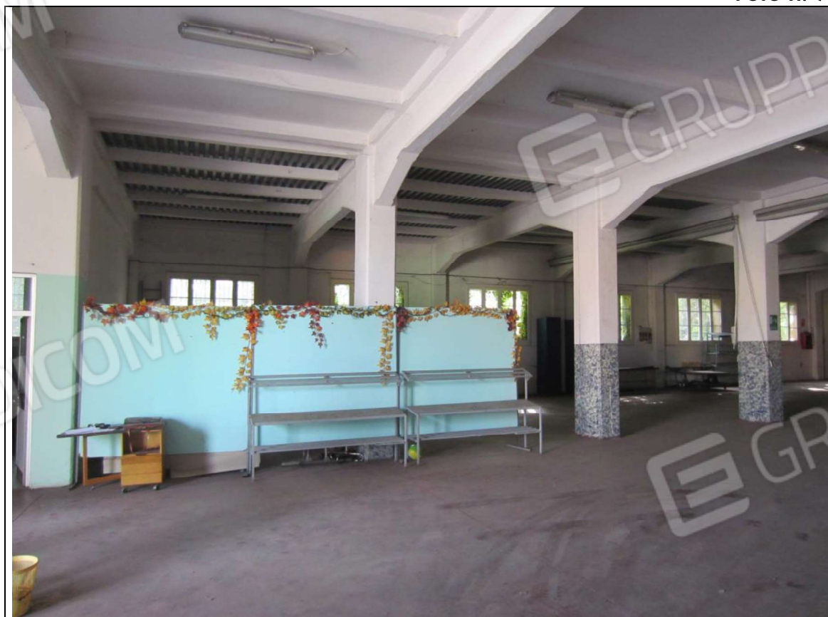
INTERNO MAGAZZINO-FRIGO-LAVORAZIONE MAPP. 239 SUB 5
