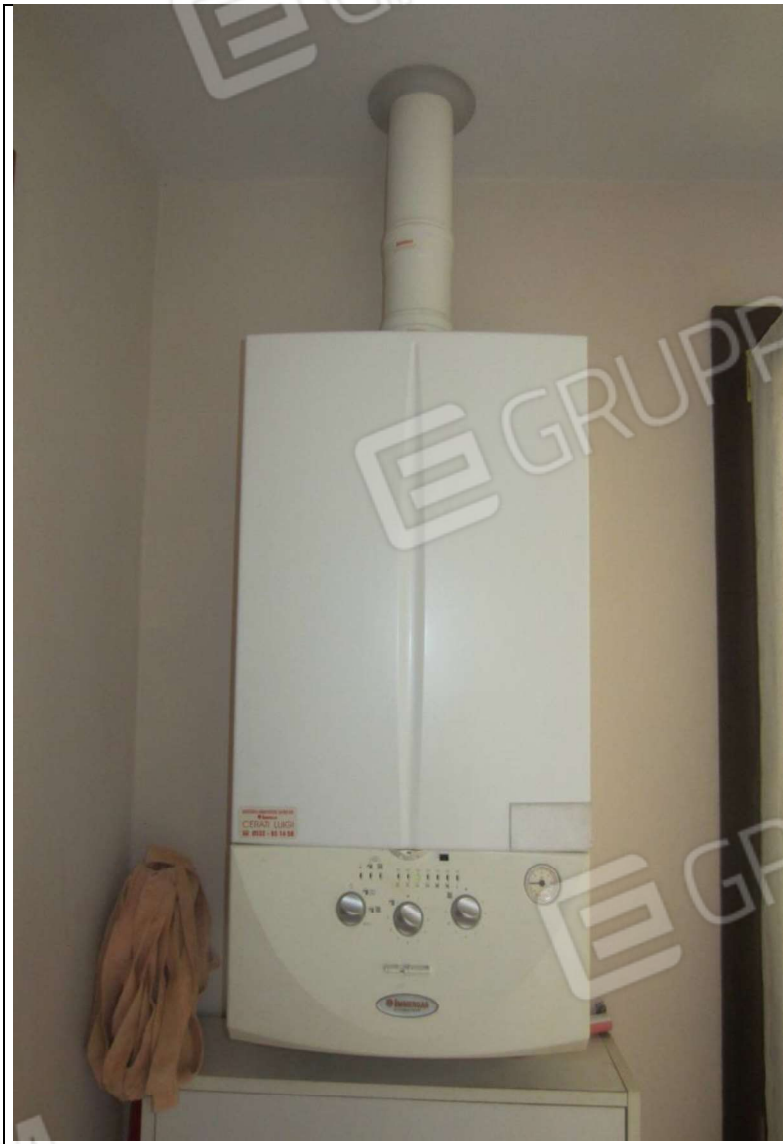
INTERNO UNITA' ABITATIVA MAPP. 239 SUB 6 - 35 SUB 28
