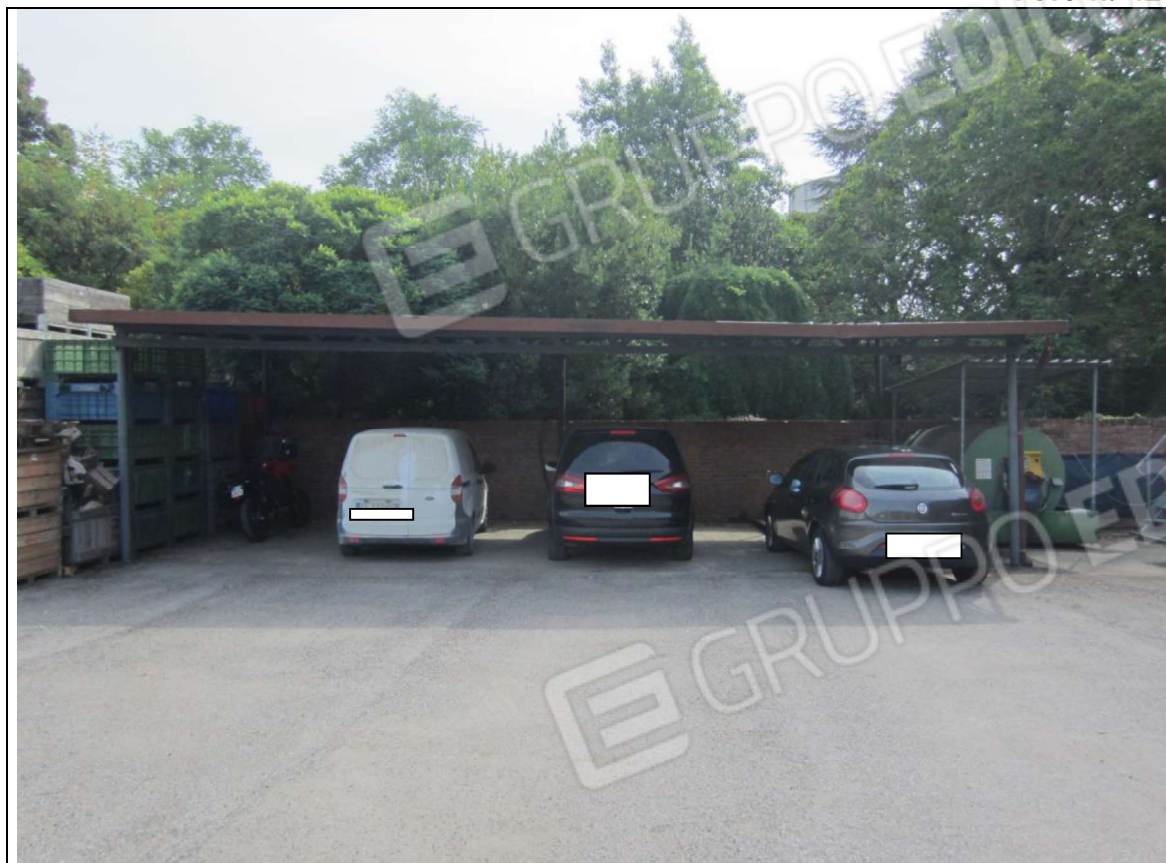
TETTOIA METALLICA MAPP. 239 SUB 9
