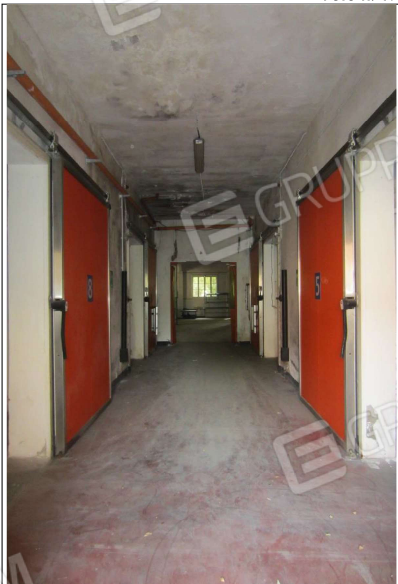
INTERNO MAGAZZINO-FRIGO-LAVORAZIONE MAPP. 239 SUB 5
