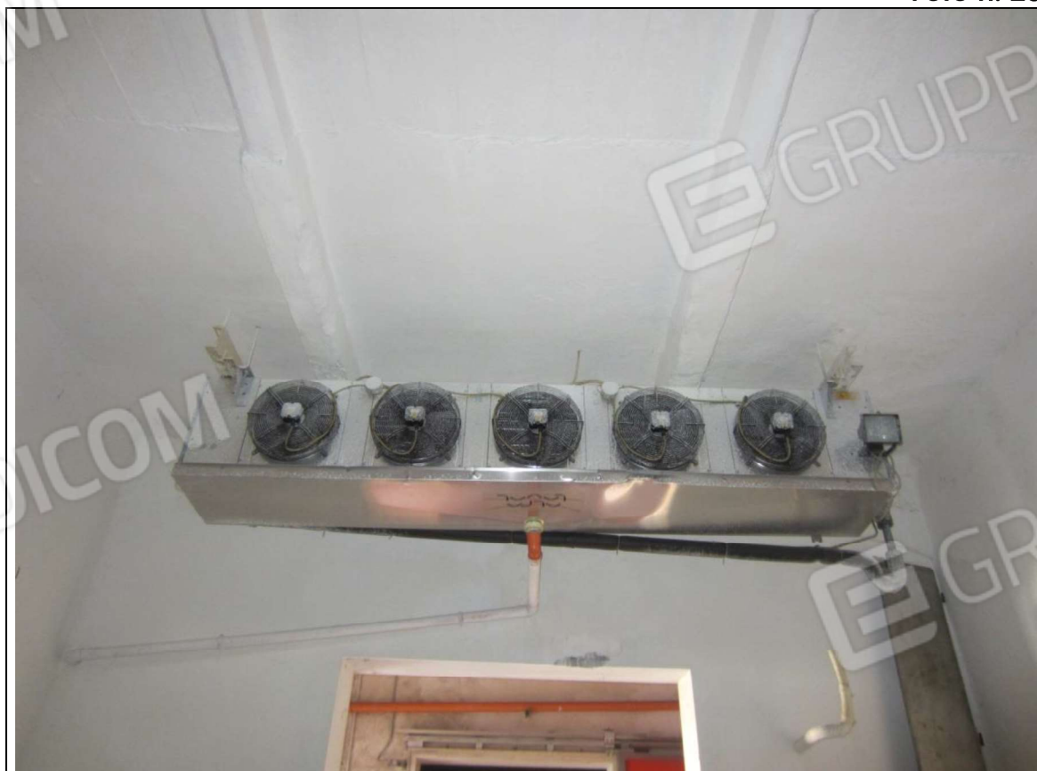
INTERNO MAGAZZINO-FRIGO-LAVORAZIONE MAPP. 239 SUB 5
