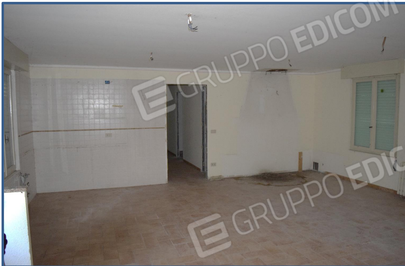
Foto 9 – Vista interna fabbricato
