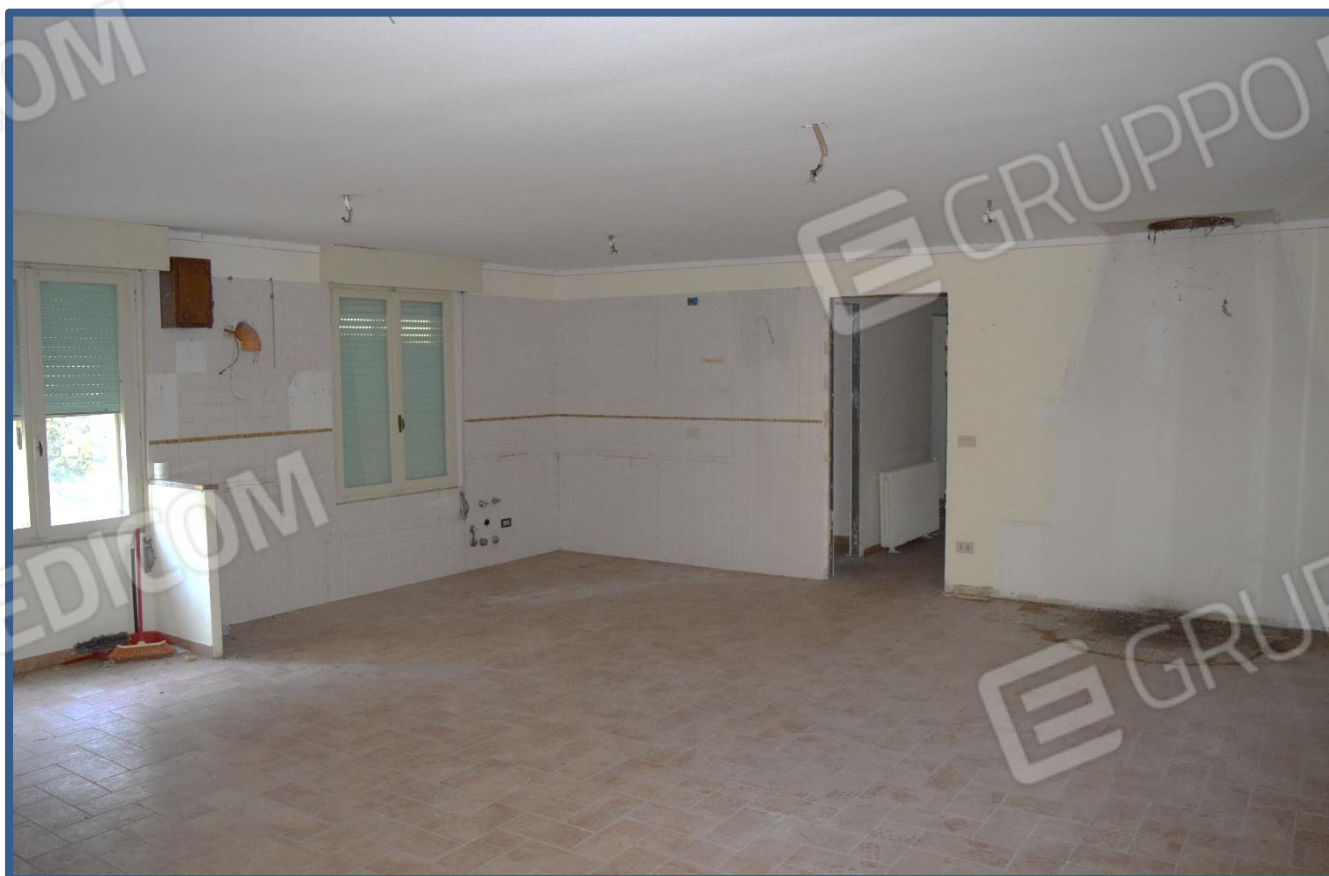
Foto 10 – Vista interna fabbricato
