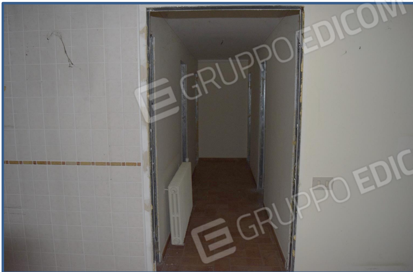
Foto 11 – Corridoio accesso alle camera
