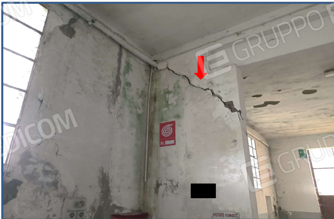
Foto 10 – fessurazione importante della struttura
