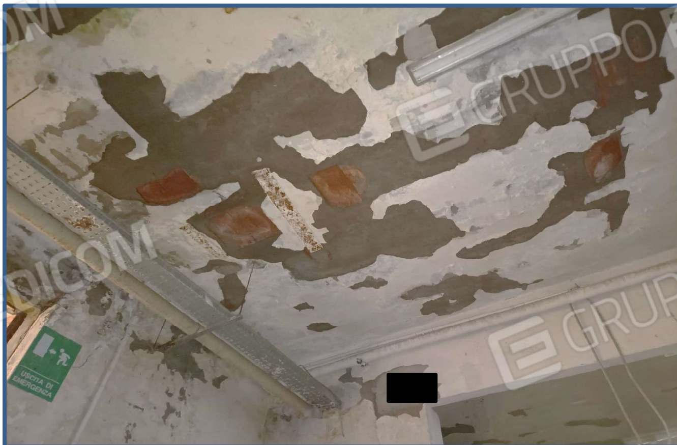
Foto 12 – infiltrazioni importati nel soffitto provenienti dalla copertura
