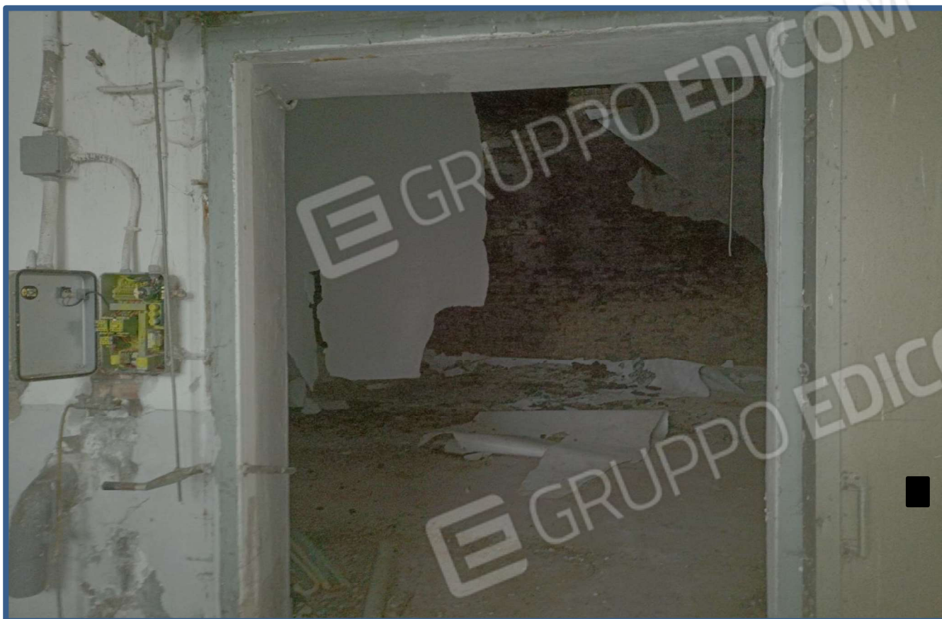
Foto 9 – celle con cedimenti al suo interno
