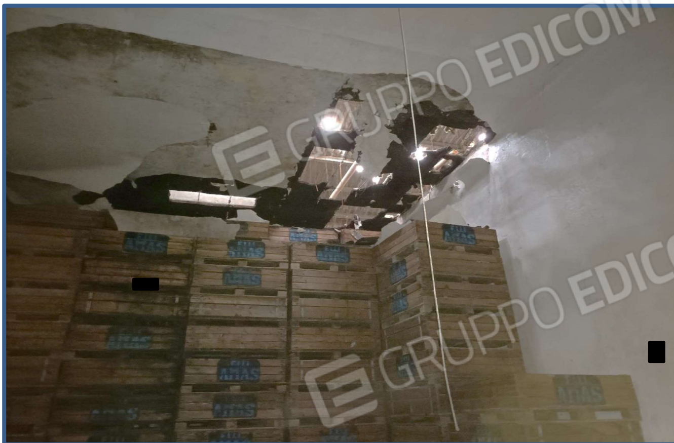
Foto 11 – cedimento del soffitto all'interno delle celle
