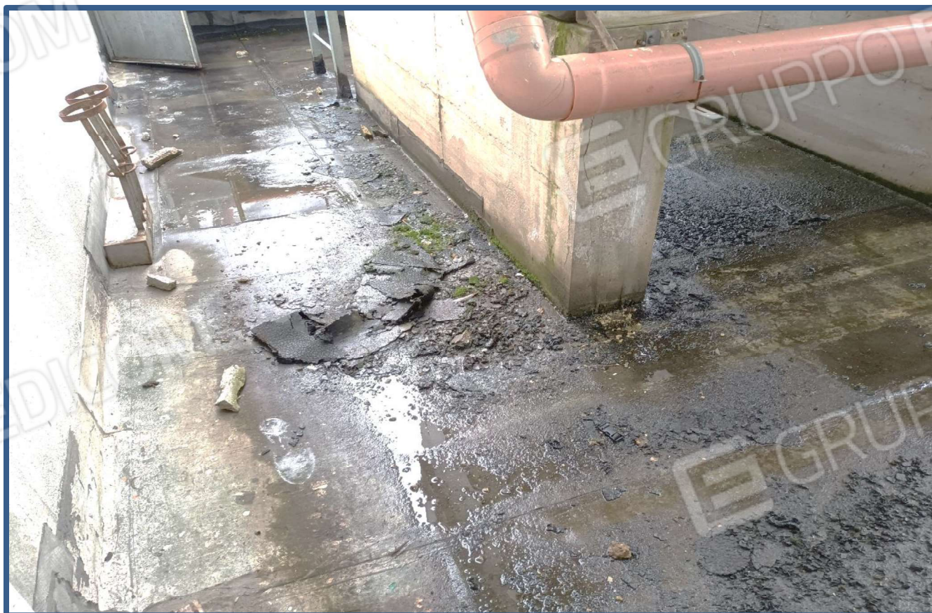
Foto 33 stato delle guaine di impermeabilizzazione
