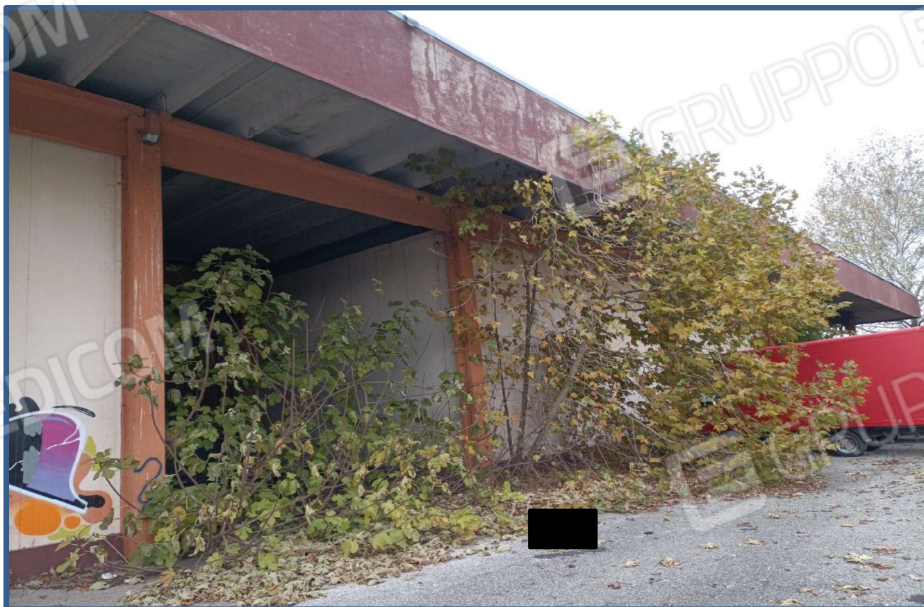
Foto 4 Tettoia celle sul lato est del fabbricato
