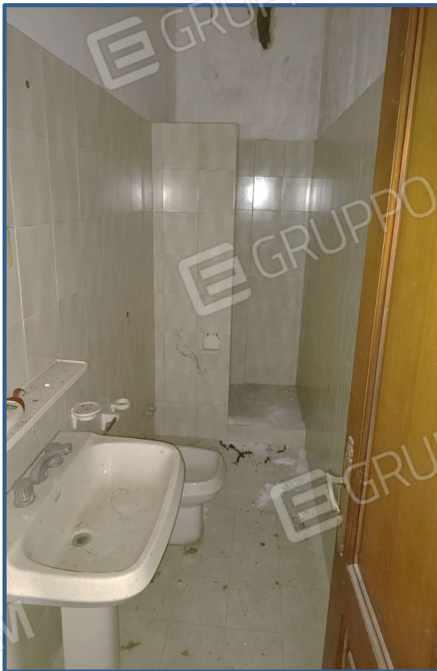
Foto 20 – bagno piano terra
