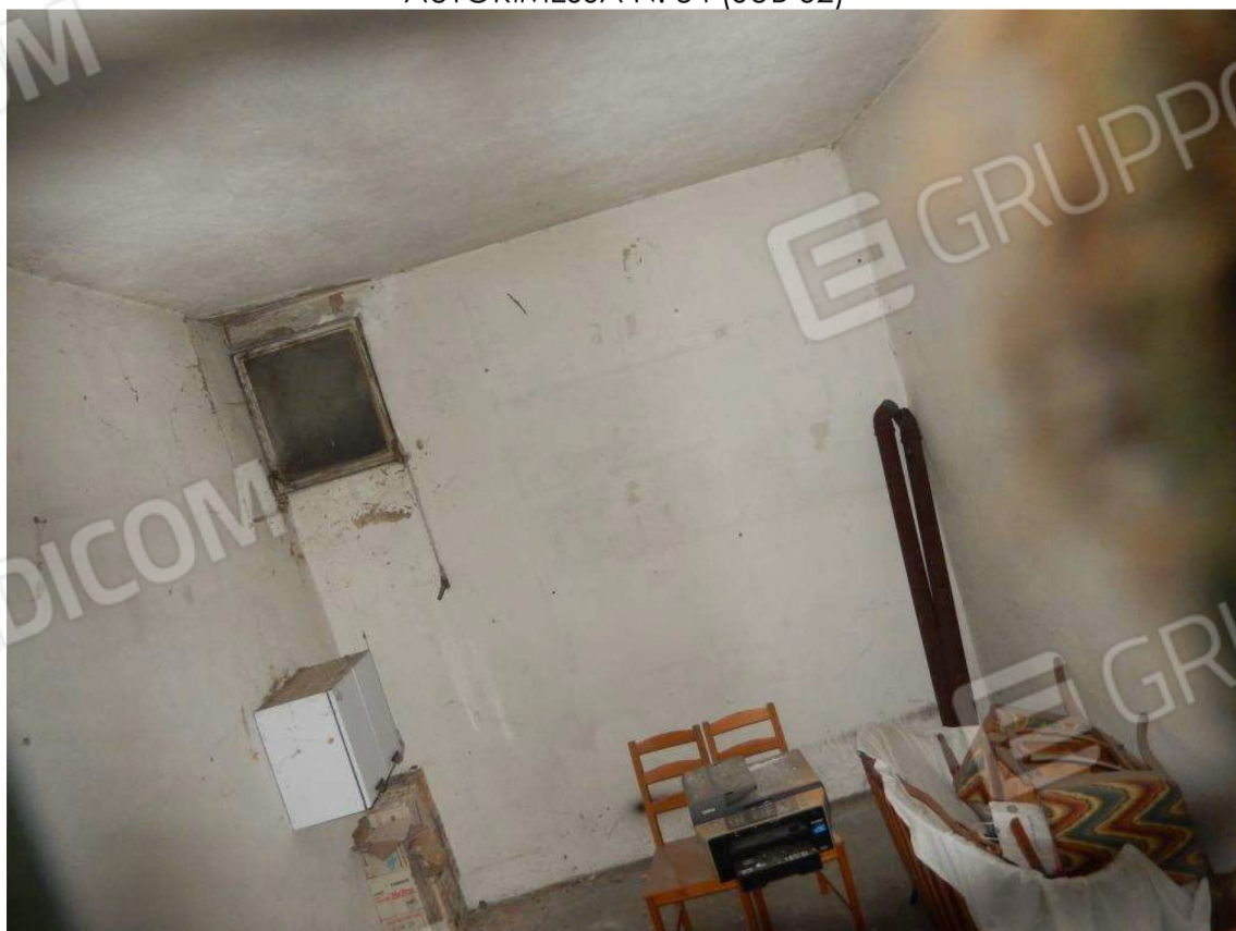
PARTICOLARE INTERNO AUTORIMESSA (MOMENTANEAMENTE INACCESSIBILE)
