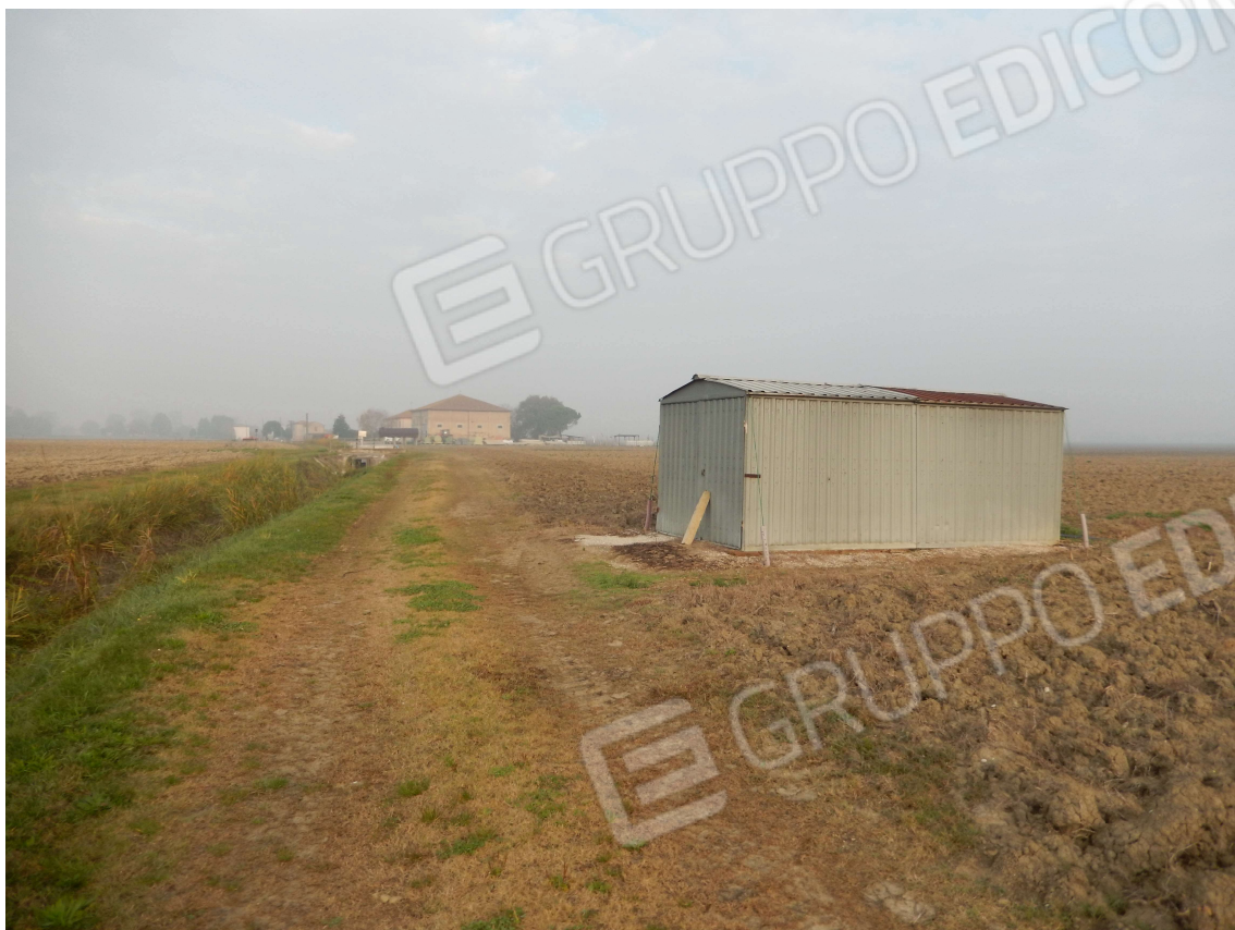
PARTICOLARE BARACCA METALLO- EX STAZ IRRIGUA – DA RIMUOVERE
