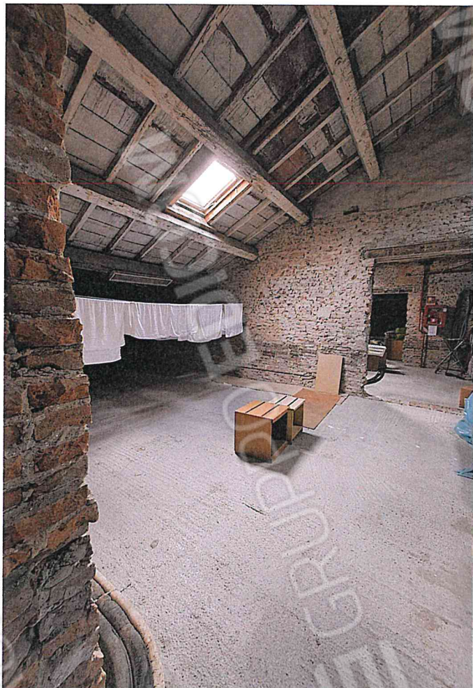
Locali di servizio, piano terzo o sottotetto
