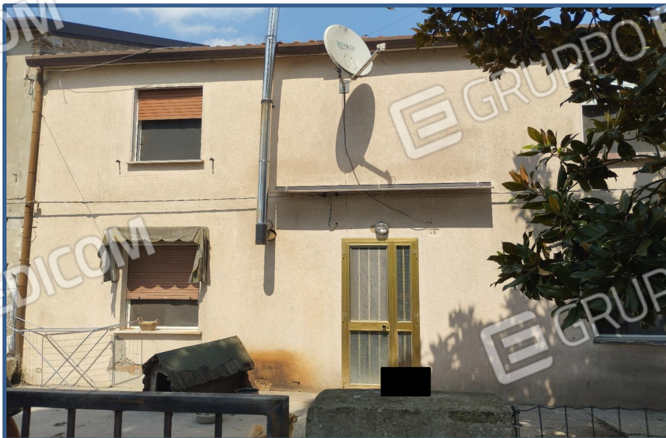
Foto 2 Prospetto sud abitazione
