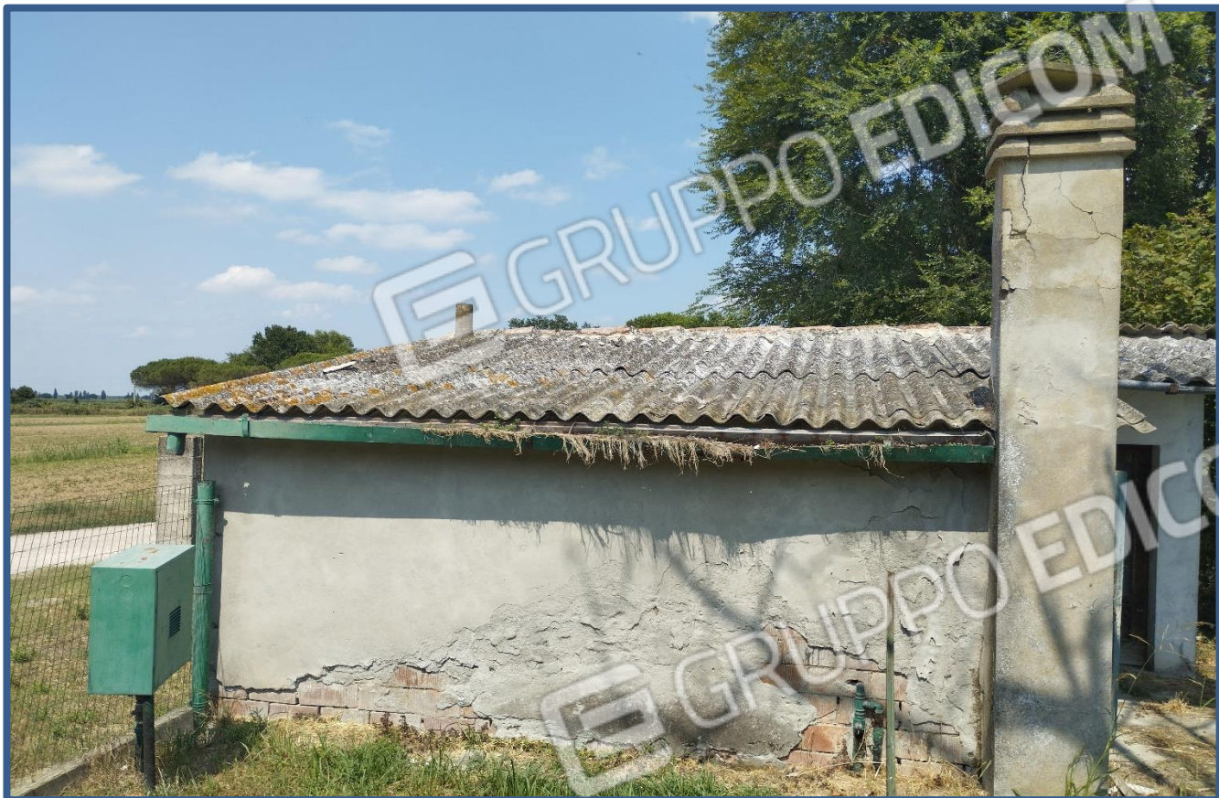
Foto 15 – proservizio al centro della corte comune
