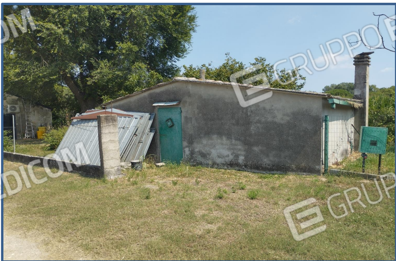
Foto 16 – proservizio al centro della corte comune
