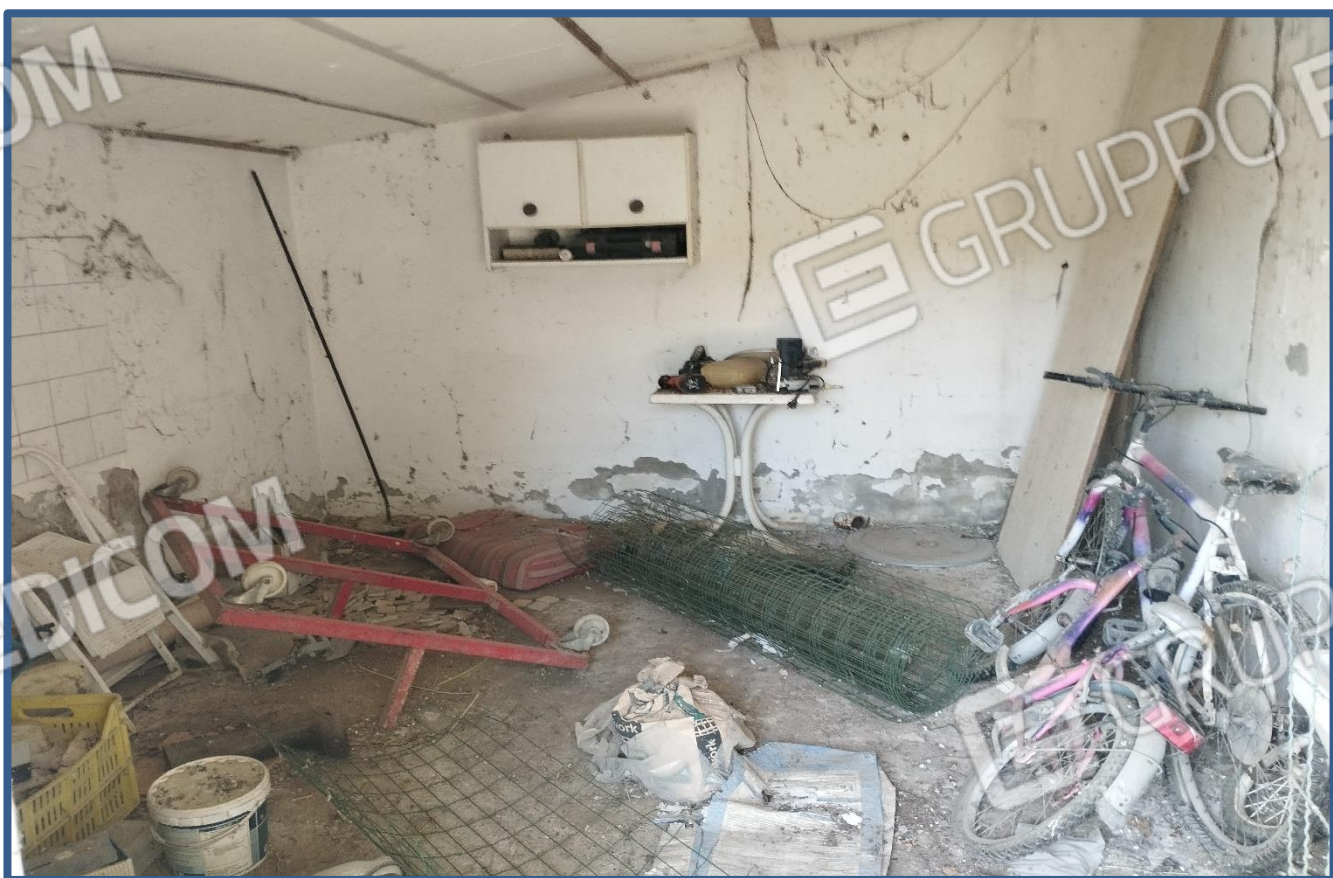
Foto 18 – proservizio al centro della corte comune
