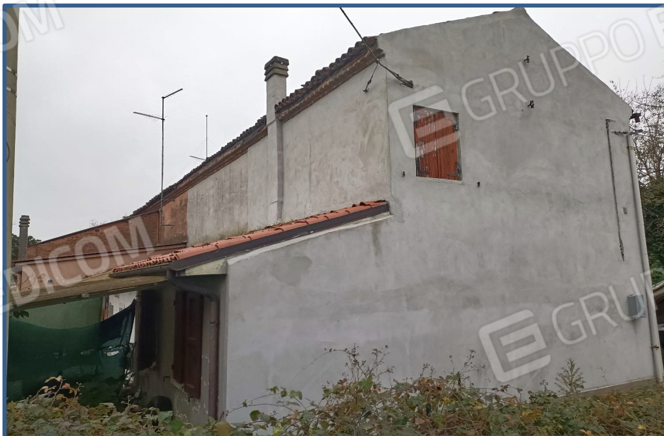
Foto 2 Vista prospetto laterale
