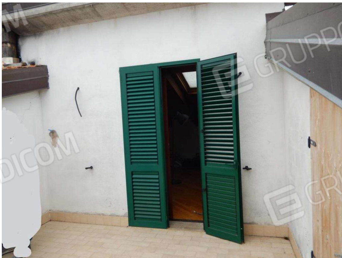
USCITA SU TERRAZZA DEL PIANO SOTTOTETTO
