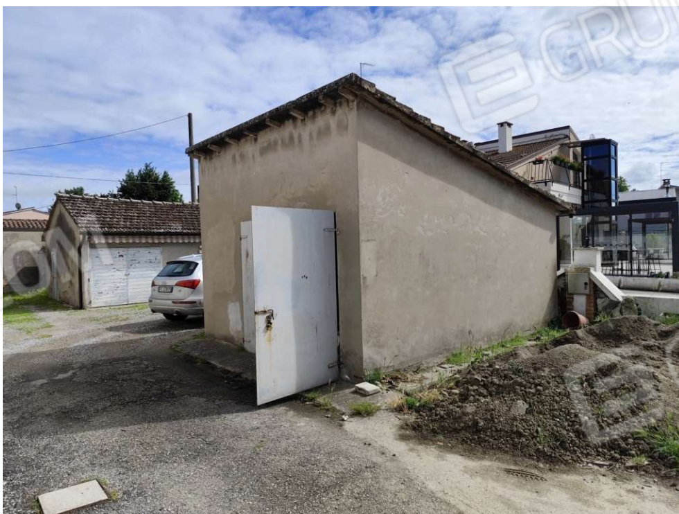
0.2 – vista da via Pozze Androna (da nord) - unità in oggetto
