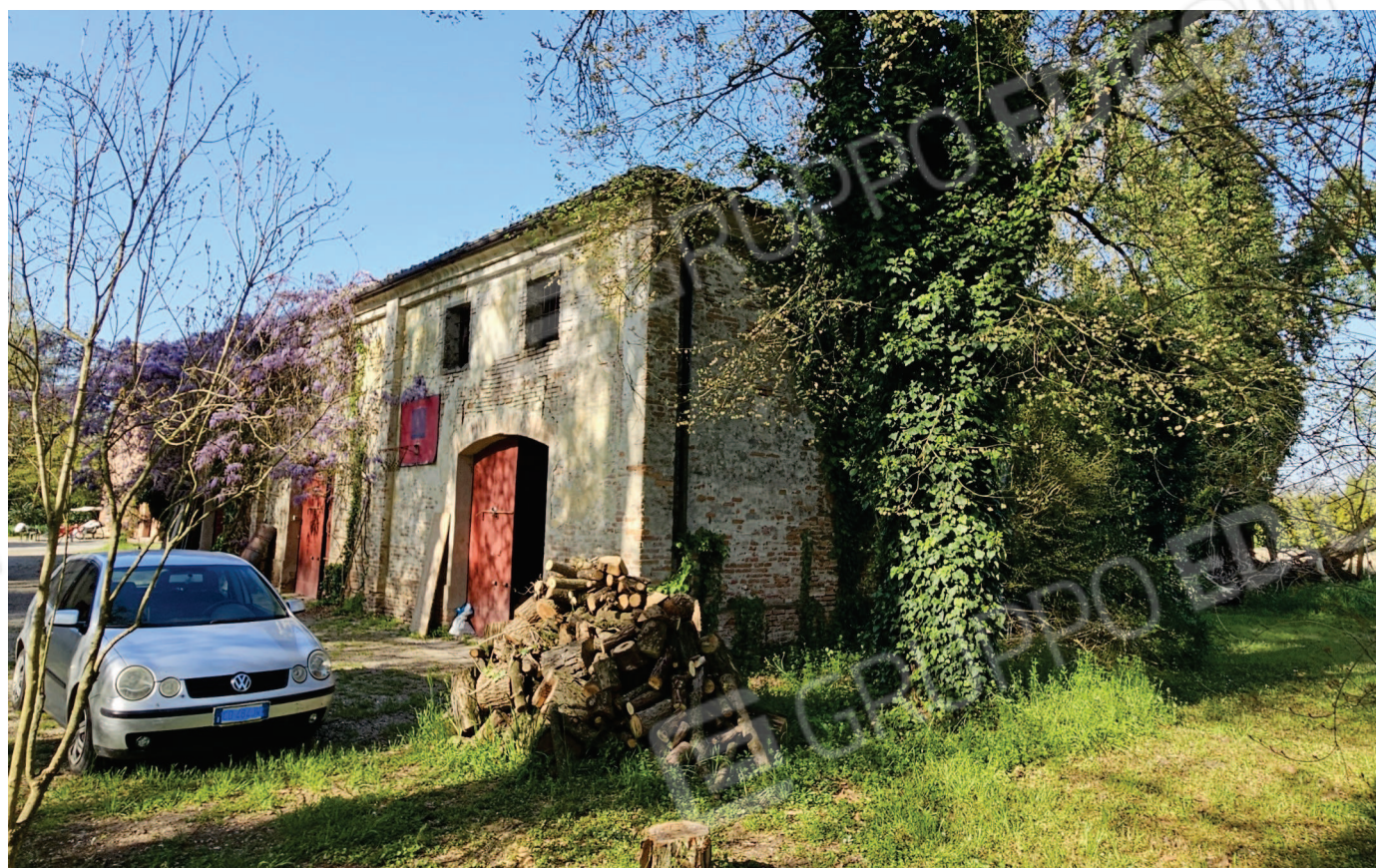
Esterno - Fronte/ Fianco
