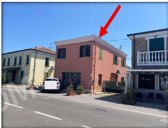
Fabbricato abitativo con due garages e corte
