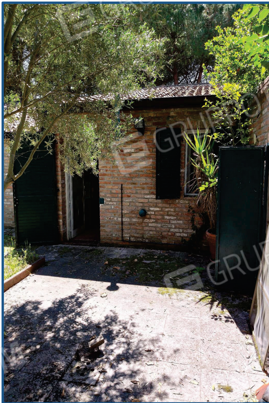
Foto 14 – corpo accessorio lavanderia
