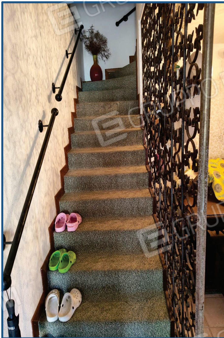
Foto 3 – scala accesso piano primo
