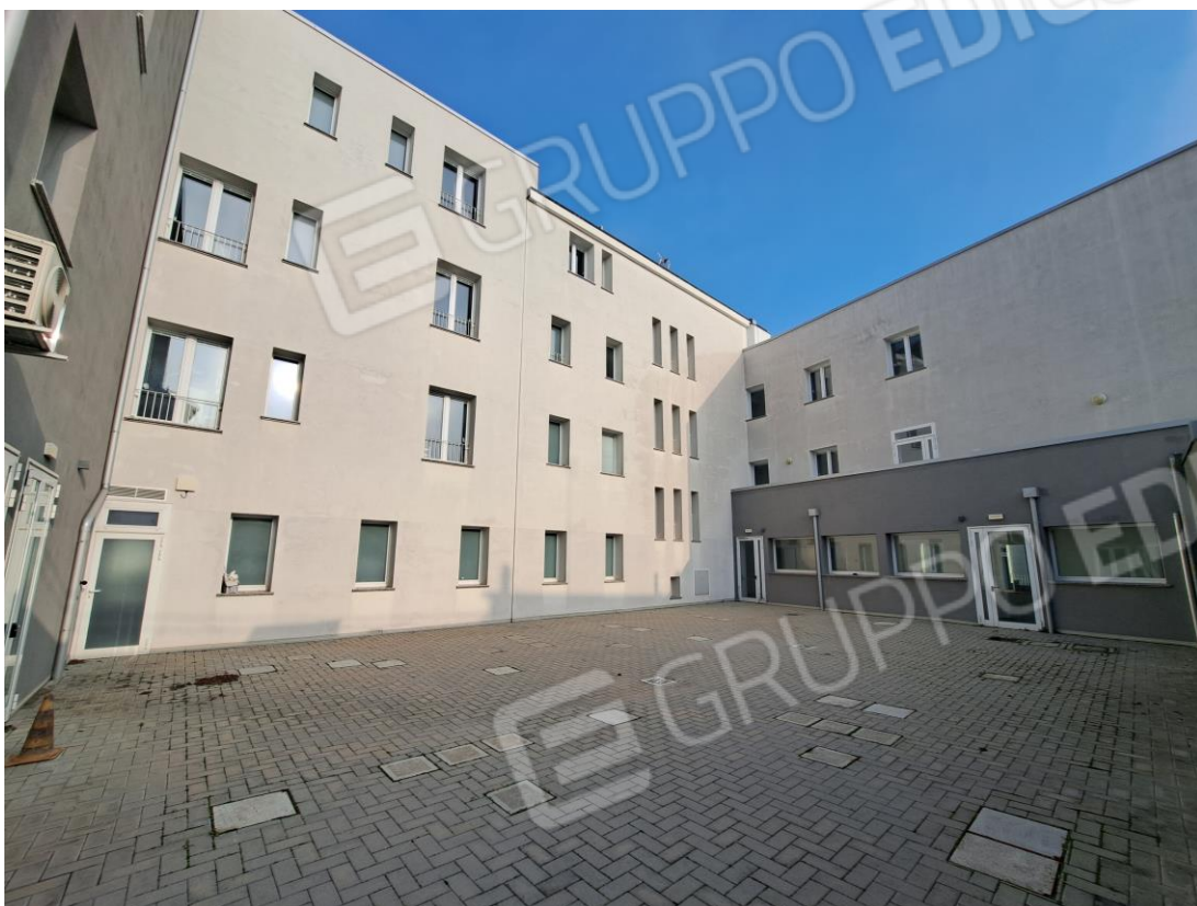
FOTO 7 – Facciata posteriore su cortile
