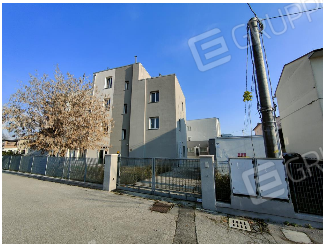
FOTO 6 – Facciata laterale su Via G.Mazzini
