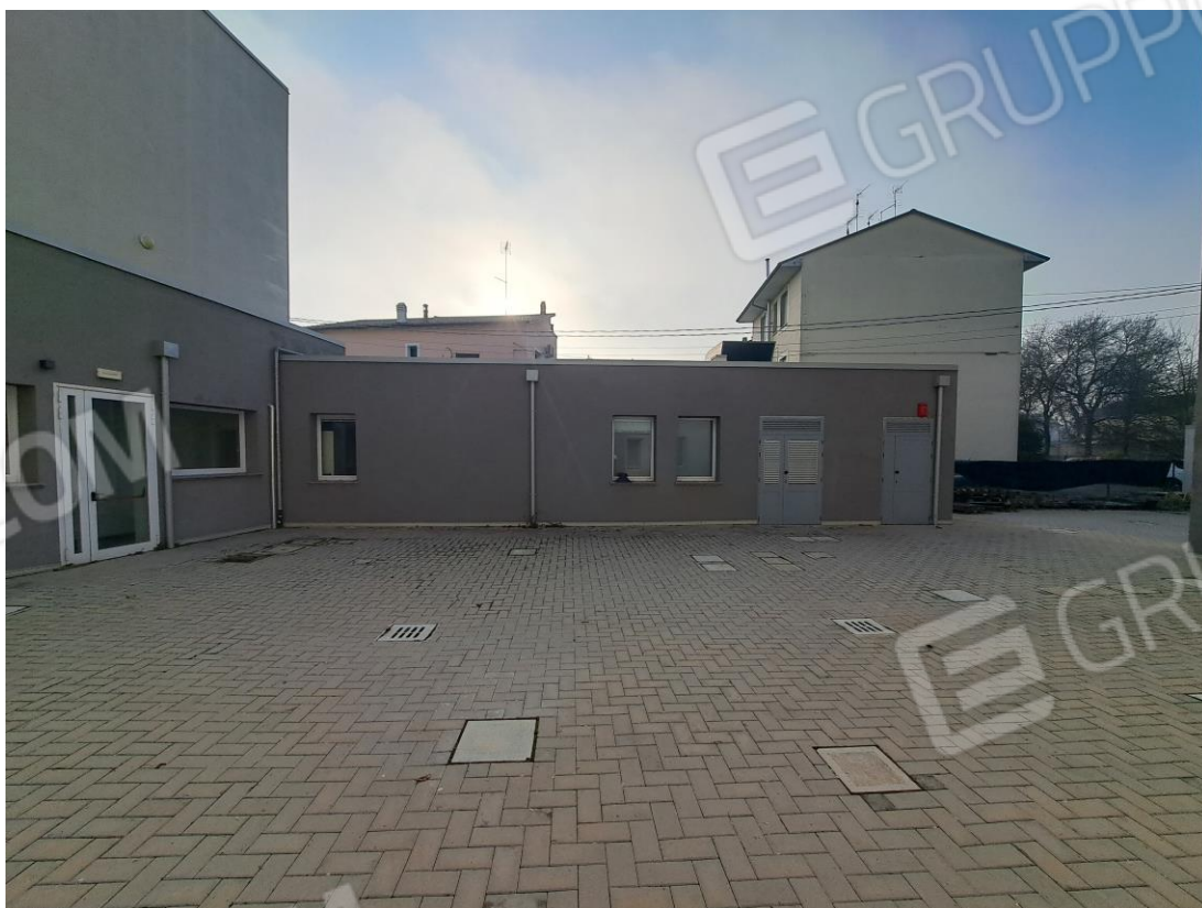
FOTO 8 – Facciata posteriore su cortile
