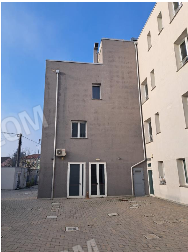
FOTO 10 – Facciata posteriore su cortile
