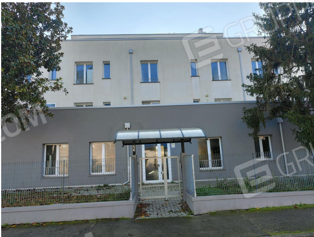
FOTO 2 – Ingresso principale da Via G.Garibaldi
