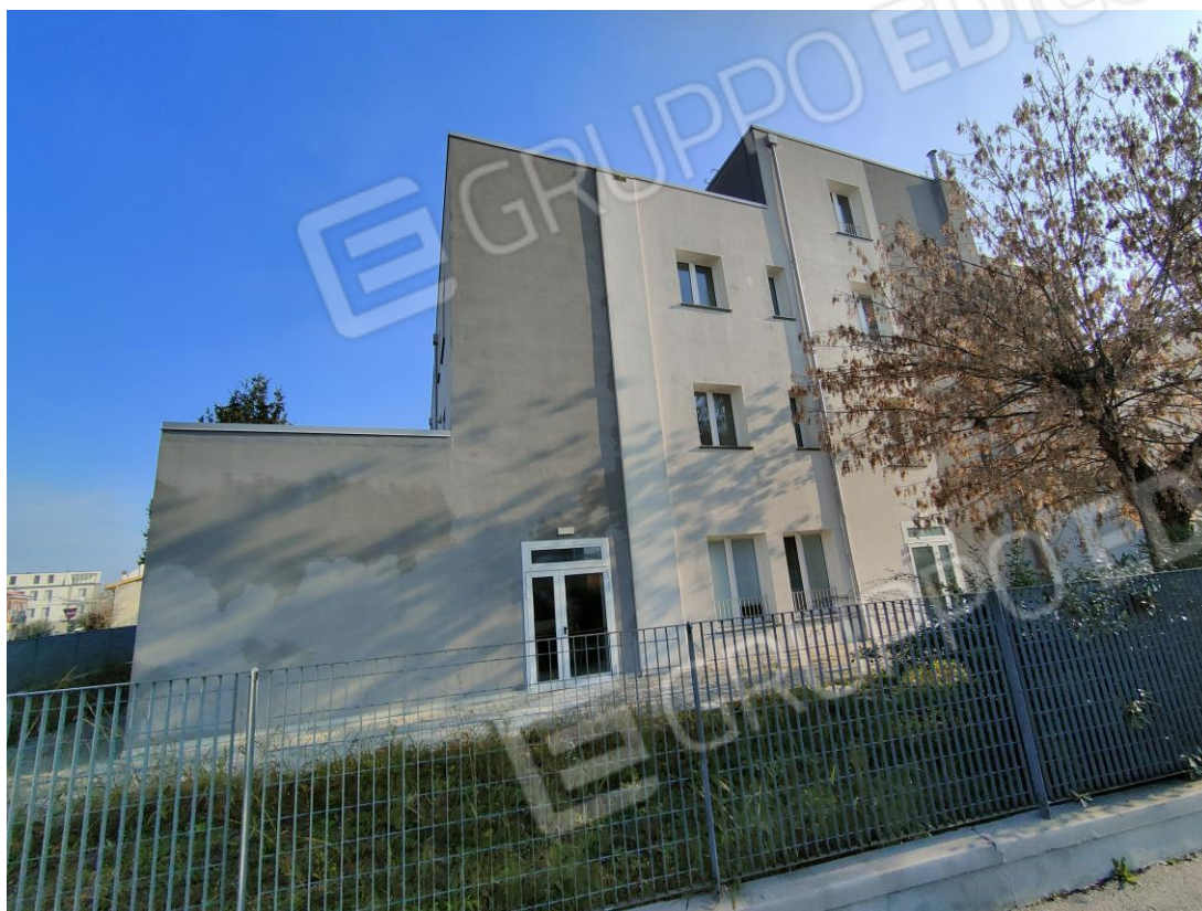
FOTO 5 – Facciata laterale su Via G.Mazzini
