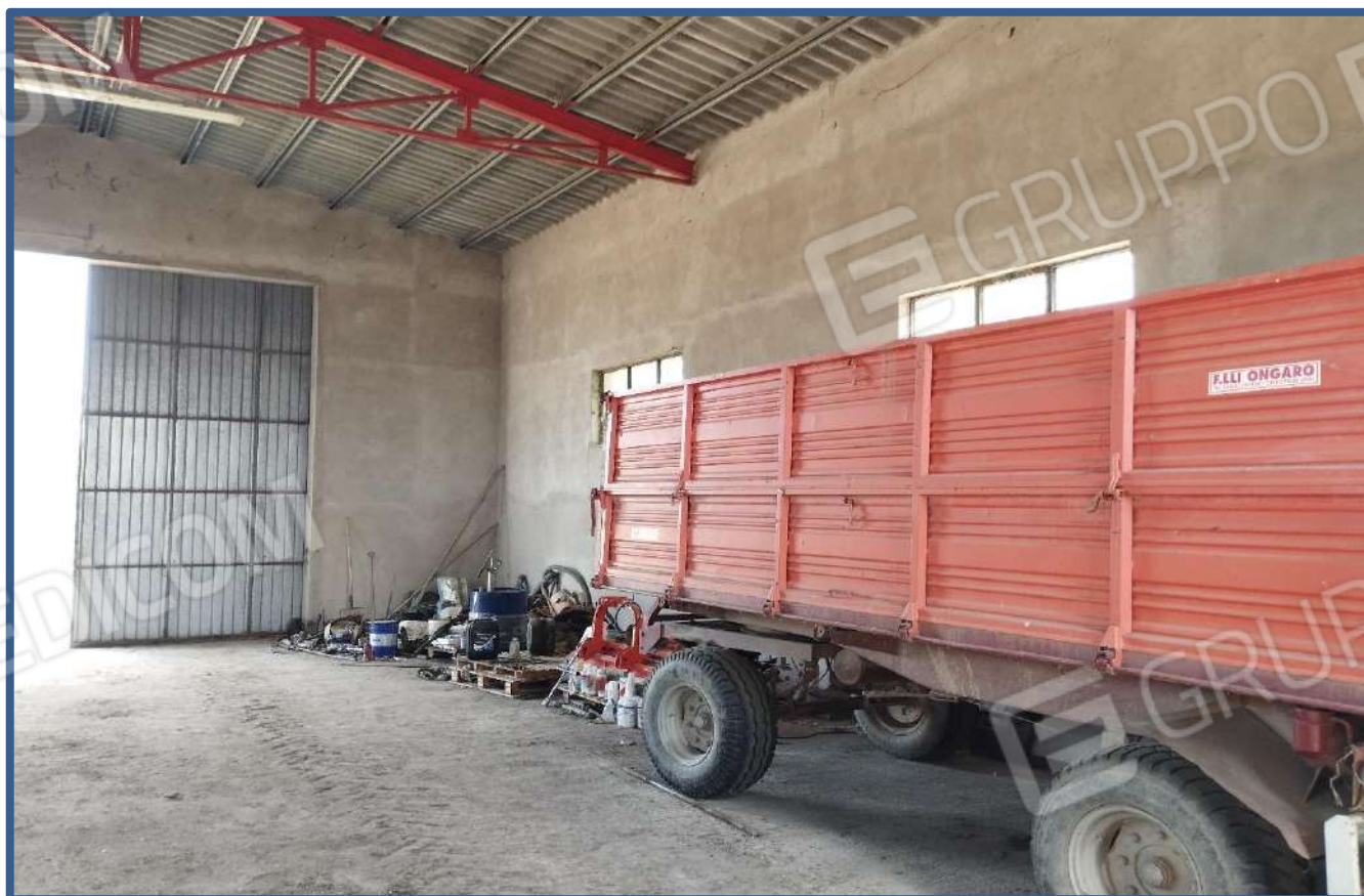
Foto 20 – fabbricato magazzino agricolo
