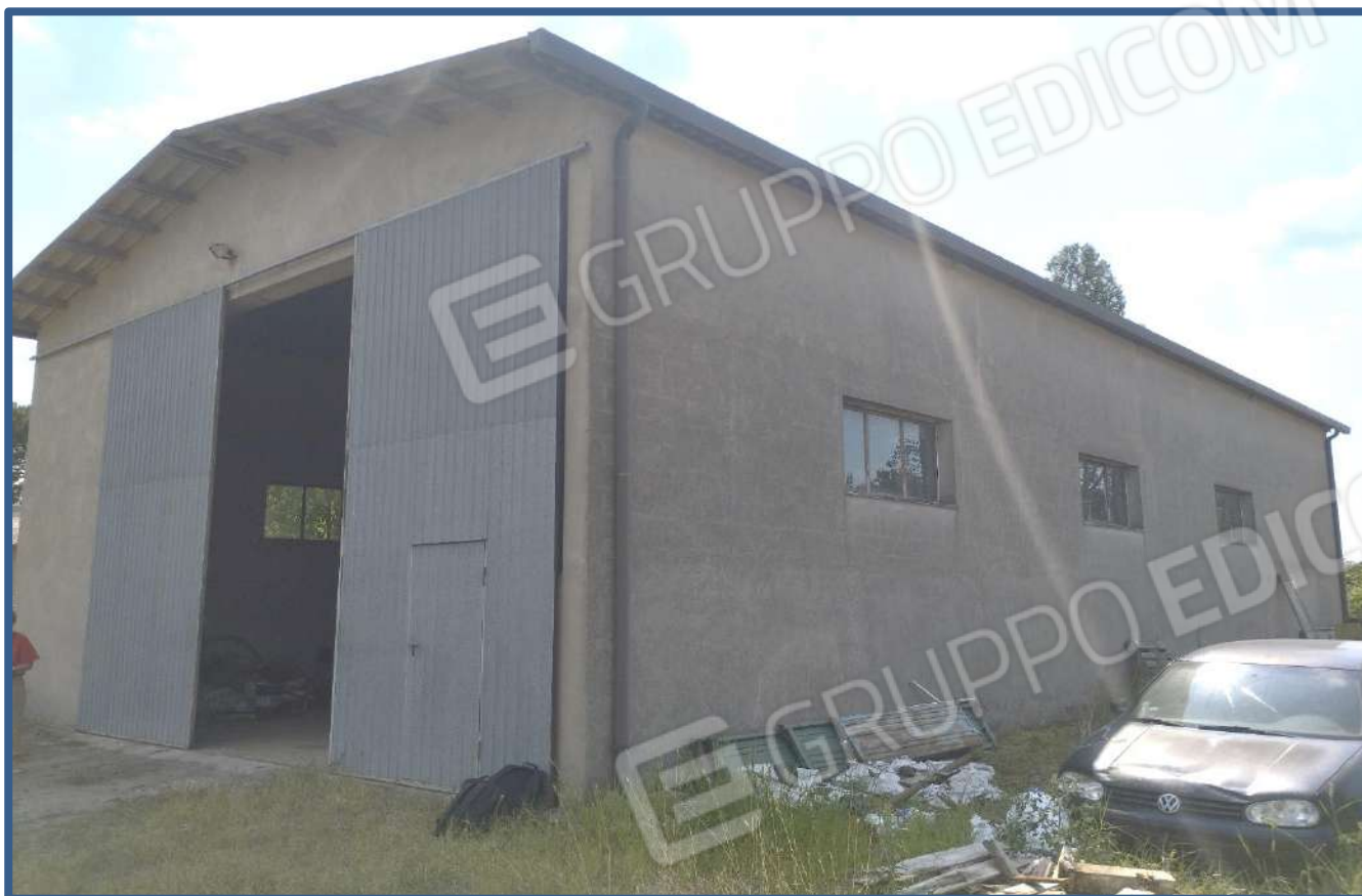
Foto 18 – fabbricato magazzino agricolo
