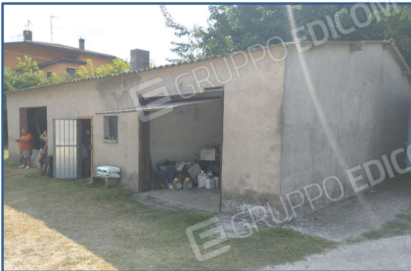
Foto 14 – fabbricato proservizi con garage
