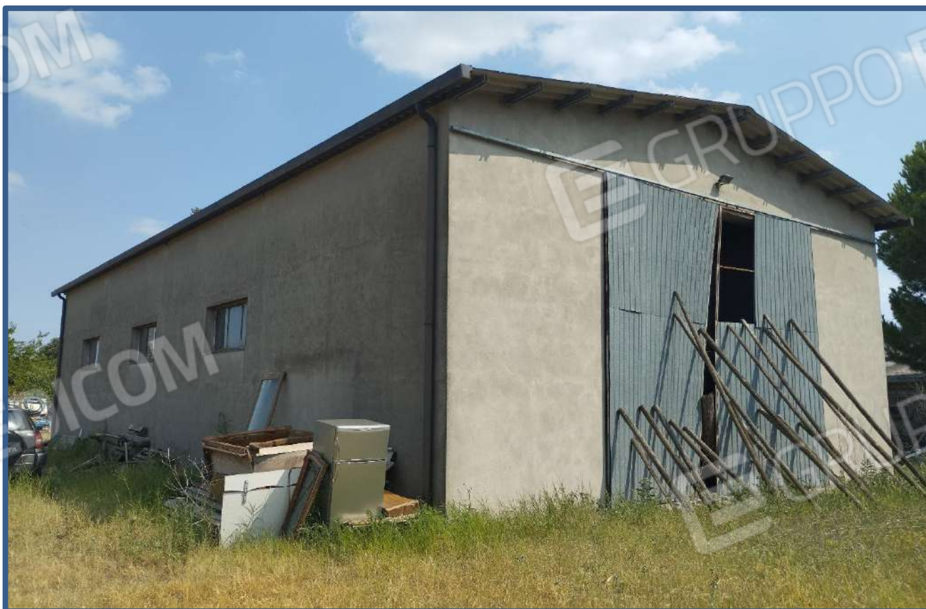
Foto 19 – fabbricato magazzino agricolo
