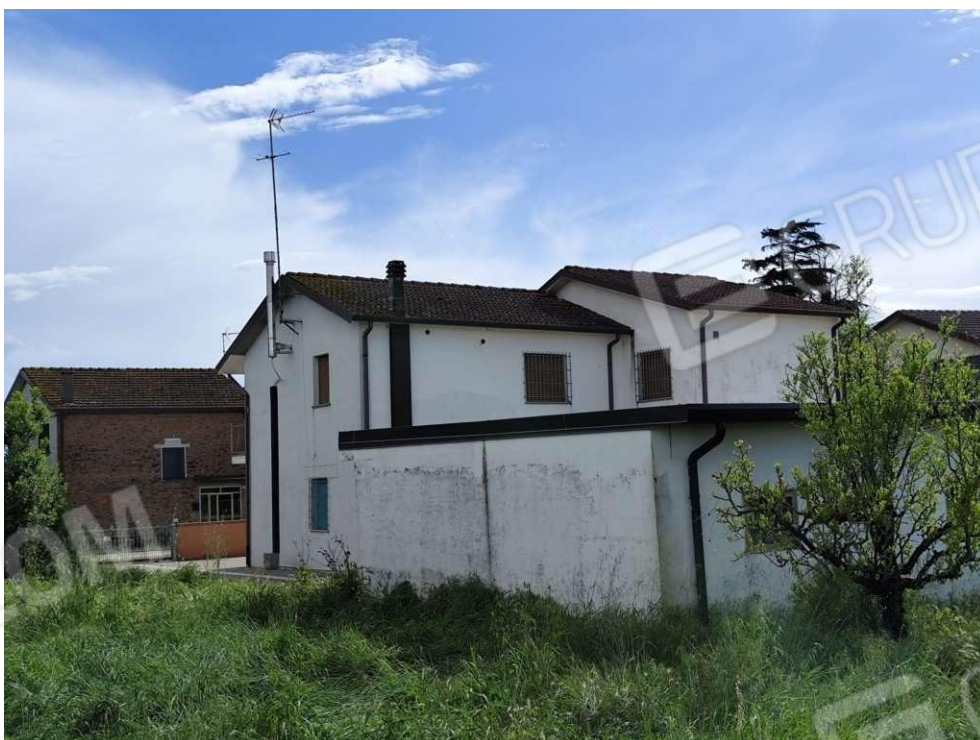
0.6 – vista da nord
